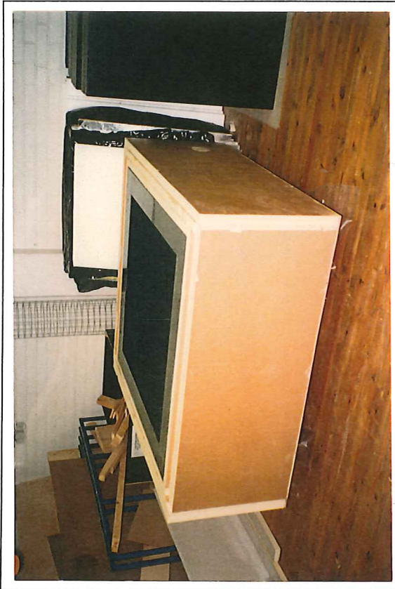
Kuva 1. PUR-levyt liimattiin PVC-levyistä hitsatun kotelon pintaan (katselusuunta toisinpäin).
