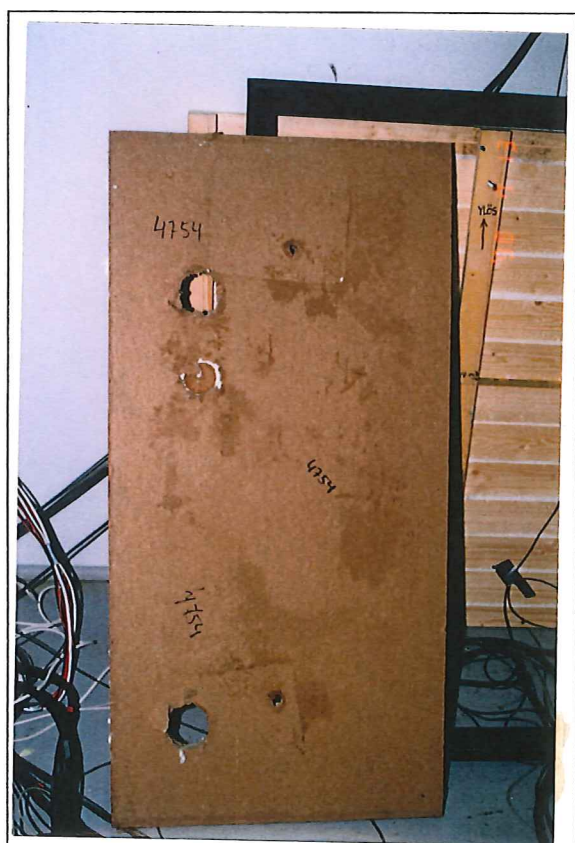
Kuva 4. Koeseinän 2 tuulensuojalevy oli kauttaaltaan märän tuntuinen kokeen jälkeen.
