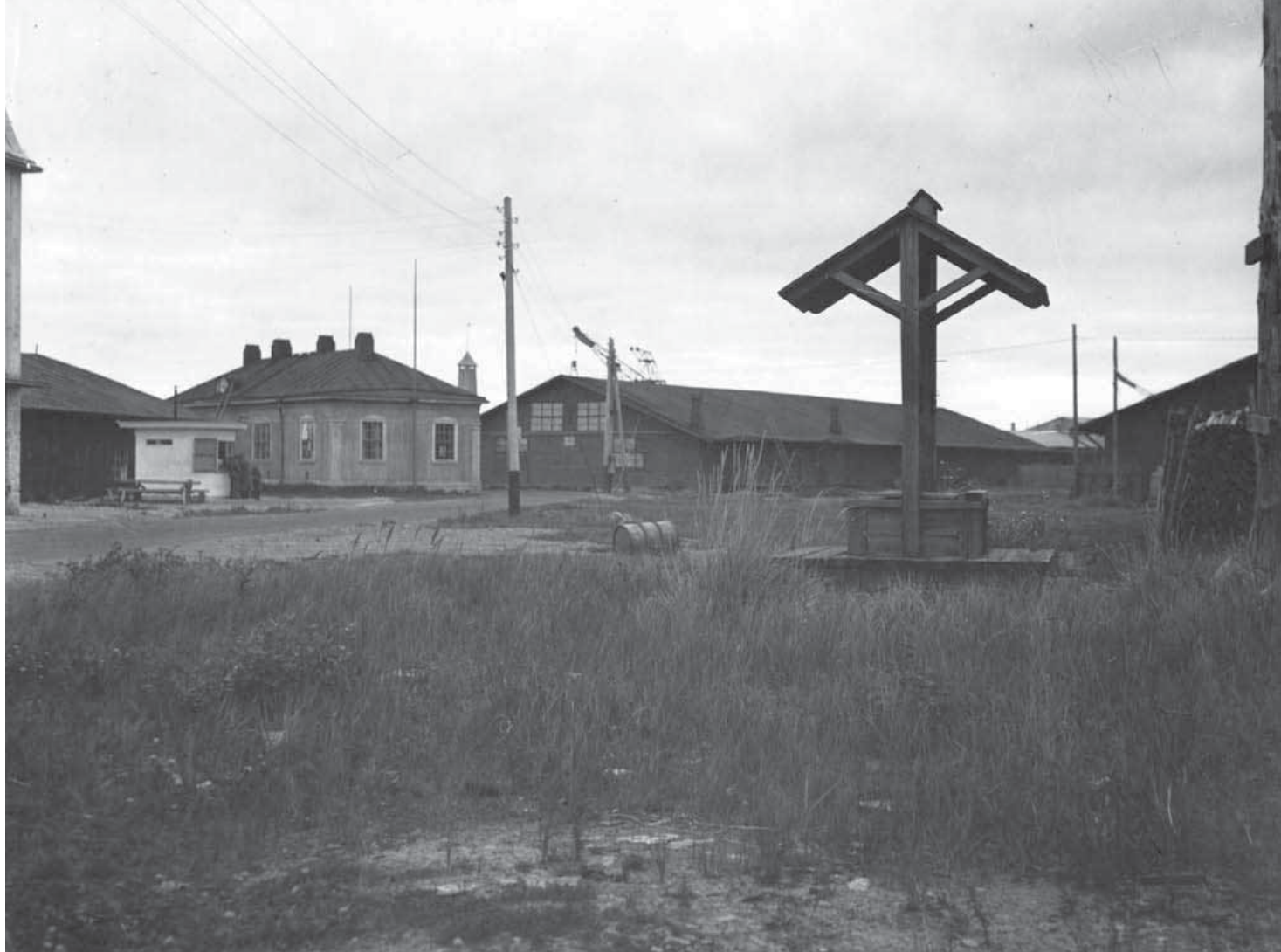
Kuva 6.5. Kaivo ja maisemaa Porista. Kuvassa katettu kuilukaivo. Katos suojaa kaivoa auringonpaisteelta, vedeltä ja lumelta. Puiet kaivoarkut olivat yleensä neliön muotoisia, kivistä tehdyt olivat pääosin muodoltaan pyöreitä. (Satakunnan Museo)
