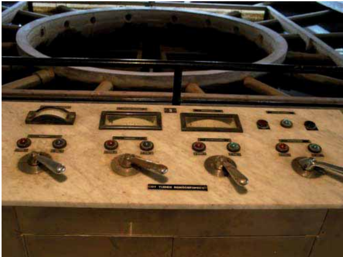
Kuva 7.1a ja b. Filtraattorilaitos, joka oli käytössä Porin Lukkarinrannassa vuodesta 1958 lähtien ja on varalaitoksena vielä tätä kirjoitettaessa. (a: Katko 2009; b: Suomen kaupunkiliitto 1958. Väestökeskusten vesilaitokset. Käytännön kunnallistekniikka III. 287 s.)
