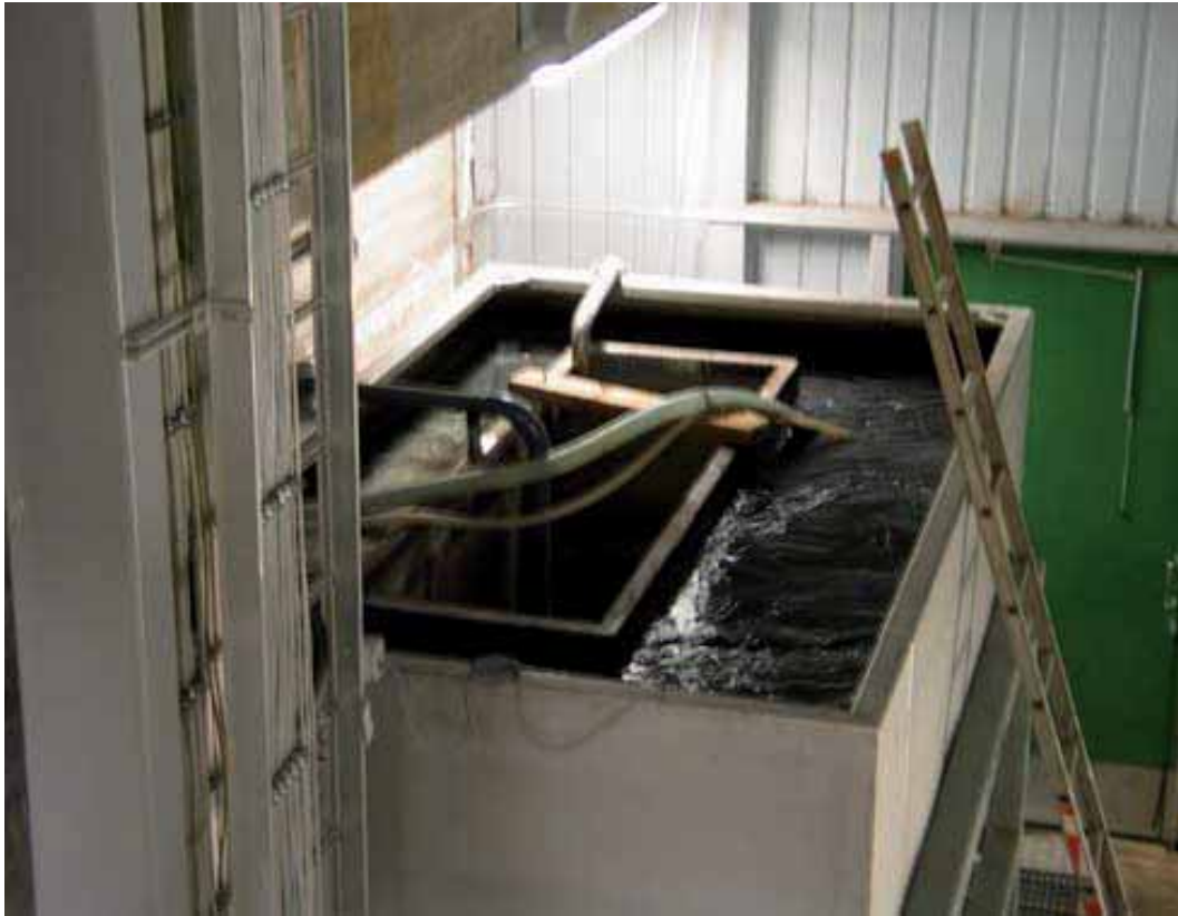
Kuva 7.27. Paineentasausallas ennen imeytysaltaille johtamista (Katko 2009).
