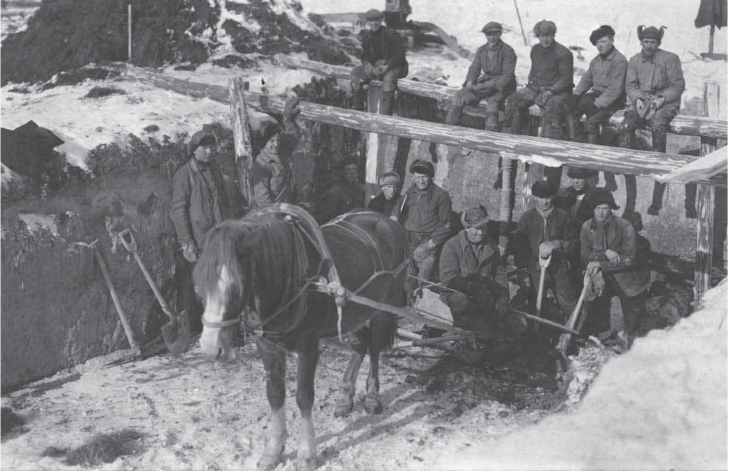
Kuva 6.19. Vesilaitosta rakentaessa konevoimaa ei juurikaan ollut käytössä, vaan käytettiin hevos- ja miesvoimia. (Satakunnan Museo)
