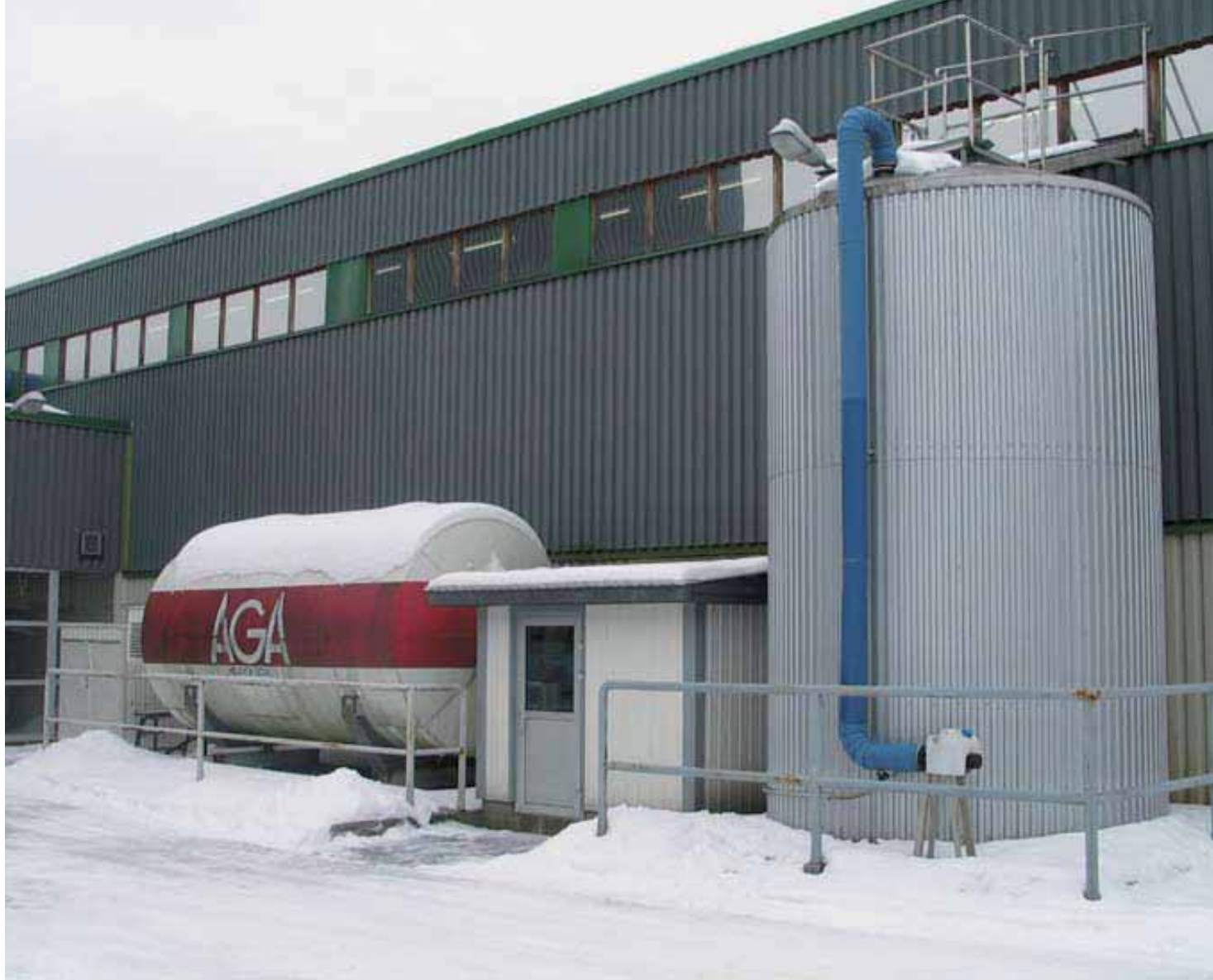
Kuva 7.34. Harjakankaan laitos: vasemmalla 25 tn hiilidioksidisäiliö ja oikealla 40 m 3 polyalumiinikloridisäiliö. (Katko 2009)
