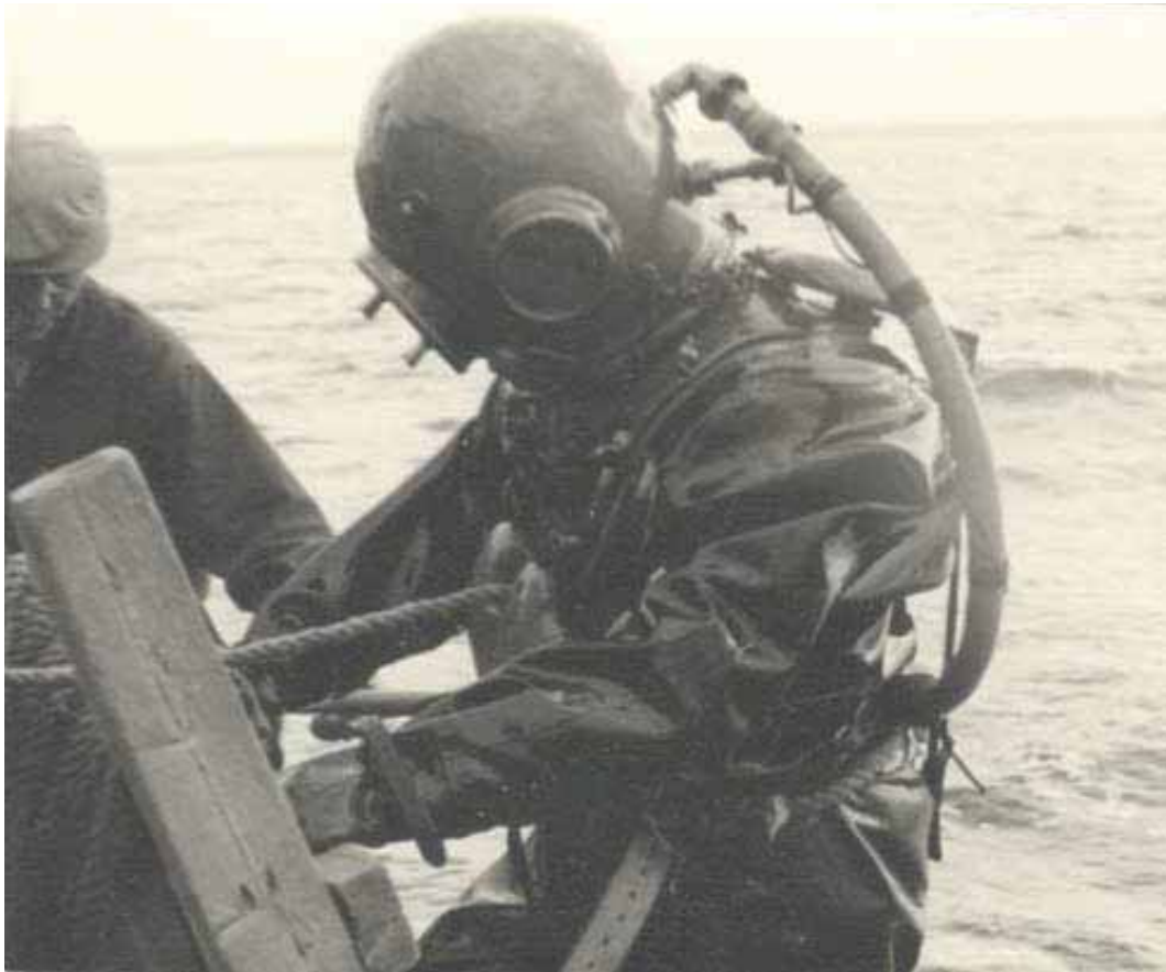
Kuva 9.15. Kumiputken laskussa tarvittiin myös sukeltajan apua. (Porin Vesi)
