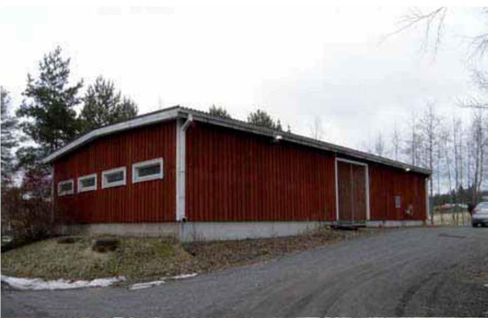
Kuva 8.22. Ahlaisten metoxy-jätevedenpuhdistamo. (Rajala 2009)
