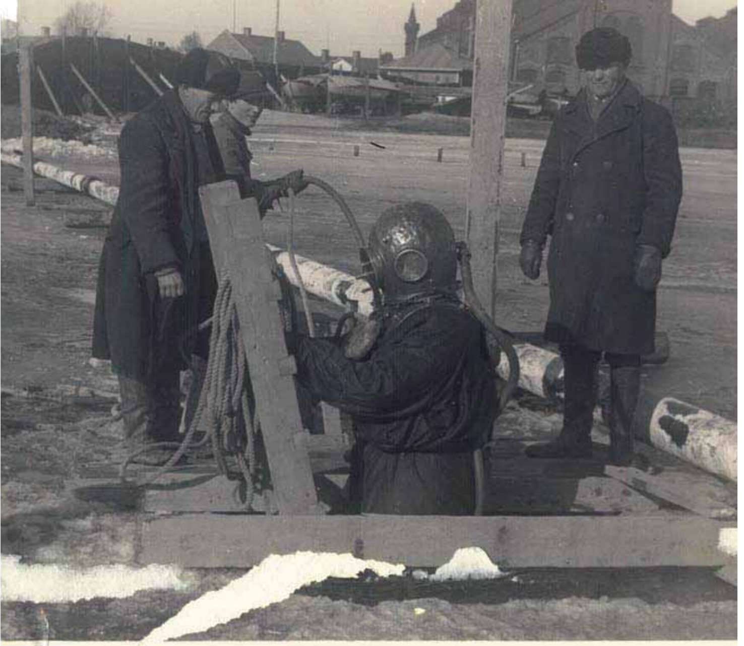
Kuva 6.23. Sukeltajaakin tarvittiin vesilaitosta rakennettaessa. (Porin Vesi)
