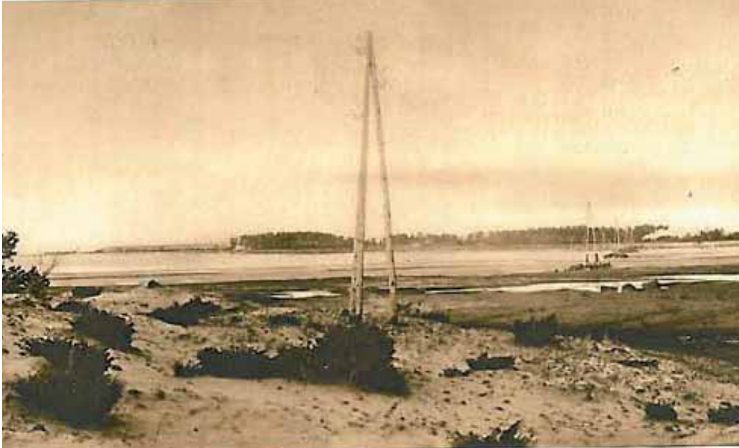
Kuva 5.20. “Sähkövirran hankintasopimuksessa mainitut 2000 V:n pylvääit Uparon ja Mäntyluodon välillä.” (Blomqvist 1931)
