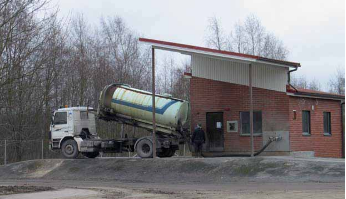
Kuva 8.8. Sakokaivolietteen vastaanottoa puhdistamolla. (Katko 2009)
