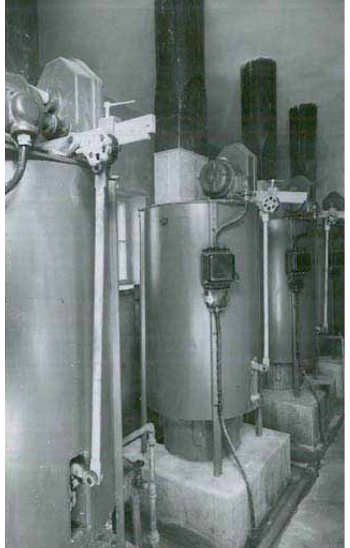
Kuva 6.34a ja b. Lukkarinsannan pintavesilaitoksen kemikaliokojeet. (Porin Vesi)
