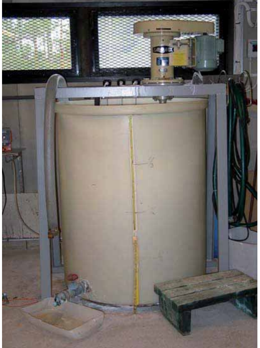
Kuva 7.41. Ahlaisten pohjave- denottamo ja lipeän syöttömahdollisuus. (Katko 2009)
