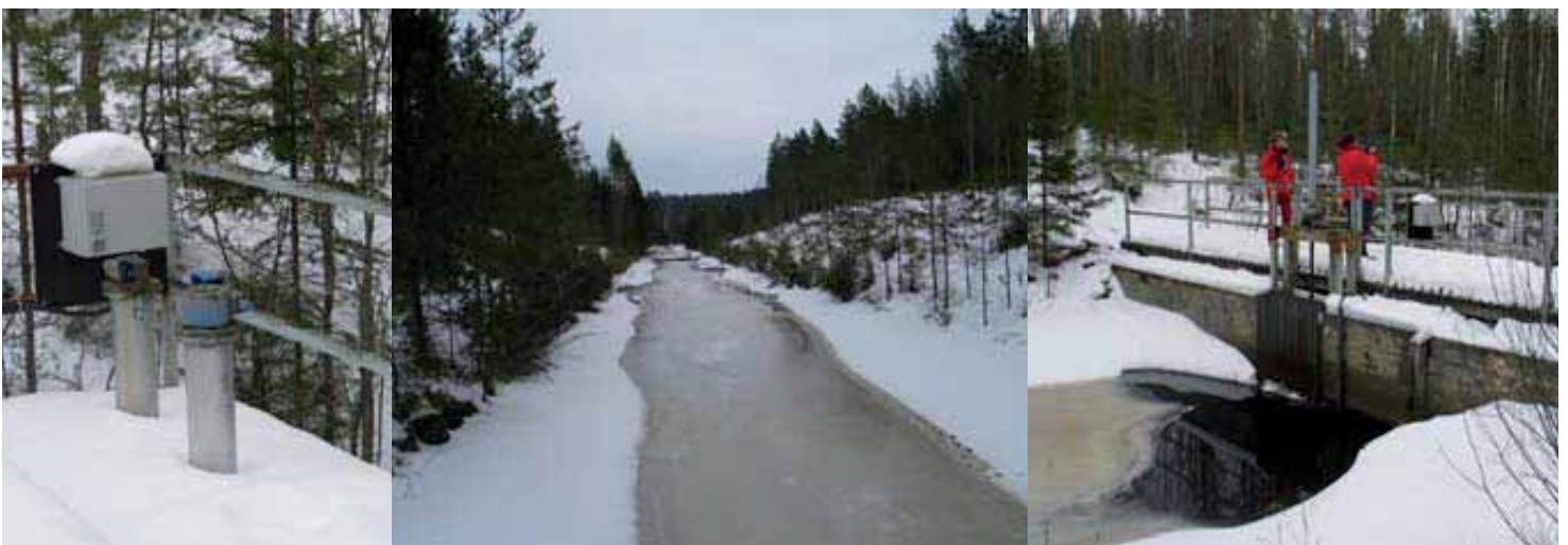
Kuva 7.19 a, b ja c. Tuurun pato Tuurujärven lounaiskolkassa (Katko 2009)
