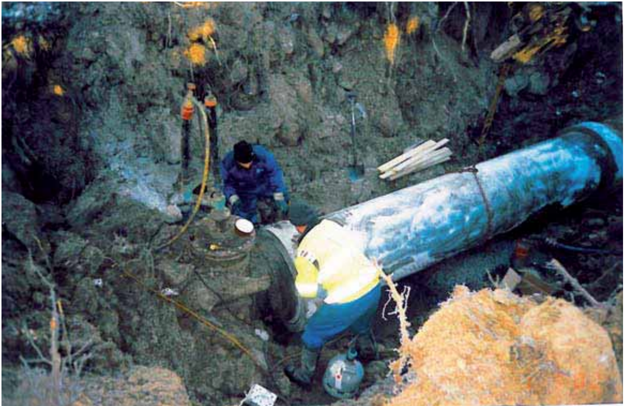
Kuva 9.52a ja b. Vuoto pääsyttöjohto Rottapekissä 7.3.2002. Yläkuvassa vasemmalta Pekka Virtanen, Rauno Irjala ja Jari Kurro. Alakuvassa vas. Pekka Virtanen ja oik. Veikko Eskola. (Porin Vesi)
