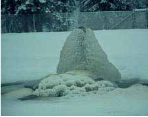
Kuva 7.13. Porin Harjakankaan tekopohjavesilaitoksen imeytysallas (Katko 25.1.1980).
