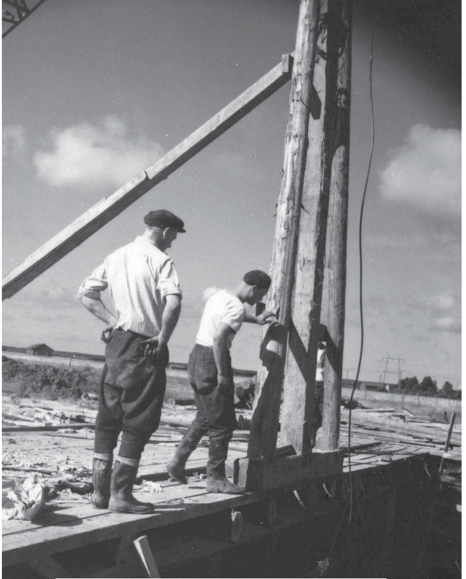
Kuva 9.3a. Kolijuovan pumppuasema rakennusvaiheen aikana vuonna 1954. (Satakunnan Museo, Seppänen H. 1954)
