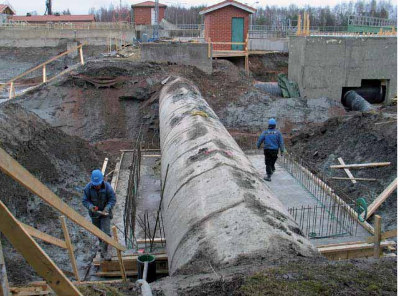
Kuva 8.15a ja b. Luotsinmäen jätevedenpuhdistamon käyttöön jäävä purkuviemäri sekä puhdistamoalueella käytettävä kerrosrakenteinen viemäriputki ja Petri Juuti. (Katko 2009)
