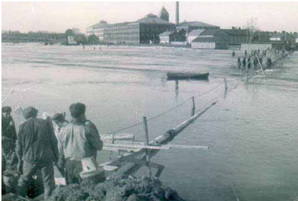
Kuva 6.45. Putken laskua noin vuodelta 1937. (Porin Vesi)
