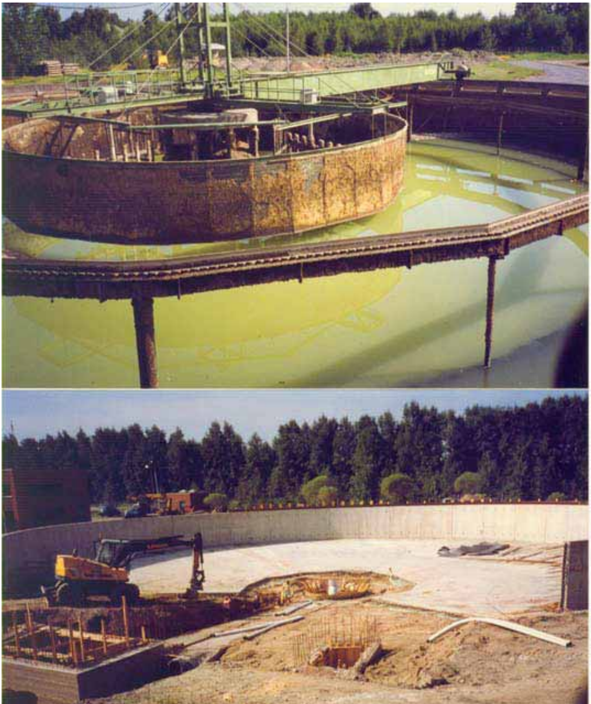
Kuva 8.4f-j. Kuvia Luotsinmäen jätevedenpuhdistamon laajennustöistä kesäkuulta 1994.
