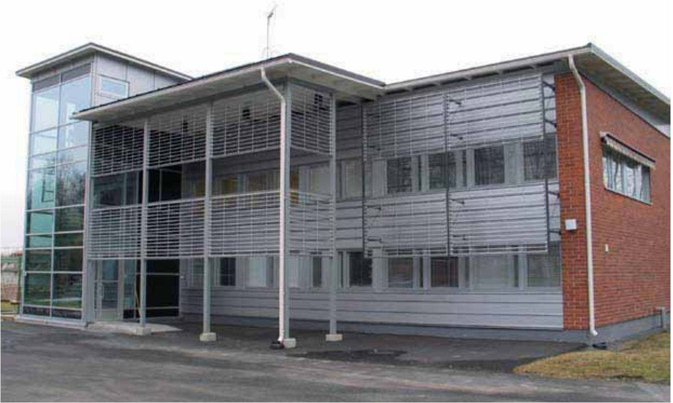
Kuva 8.7. Luotsinmäen jätevedenpuhdistamon saneerattu toimistorakennus. (Katko 2009)
