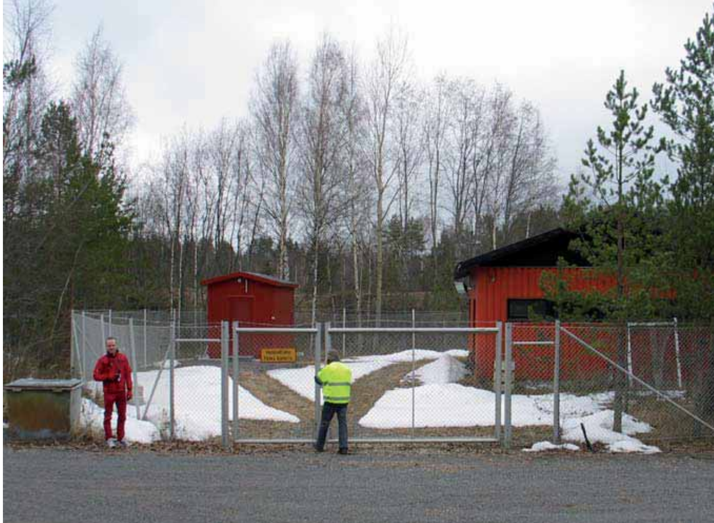
Kuva 7.39. Ahlaisten pohjavedenottamo oikealla ja vasemmalla varavoimala sekä aitaus ympärillä. (Katko 2009)
