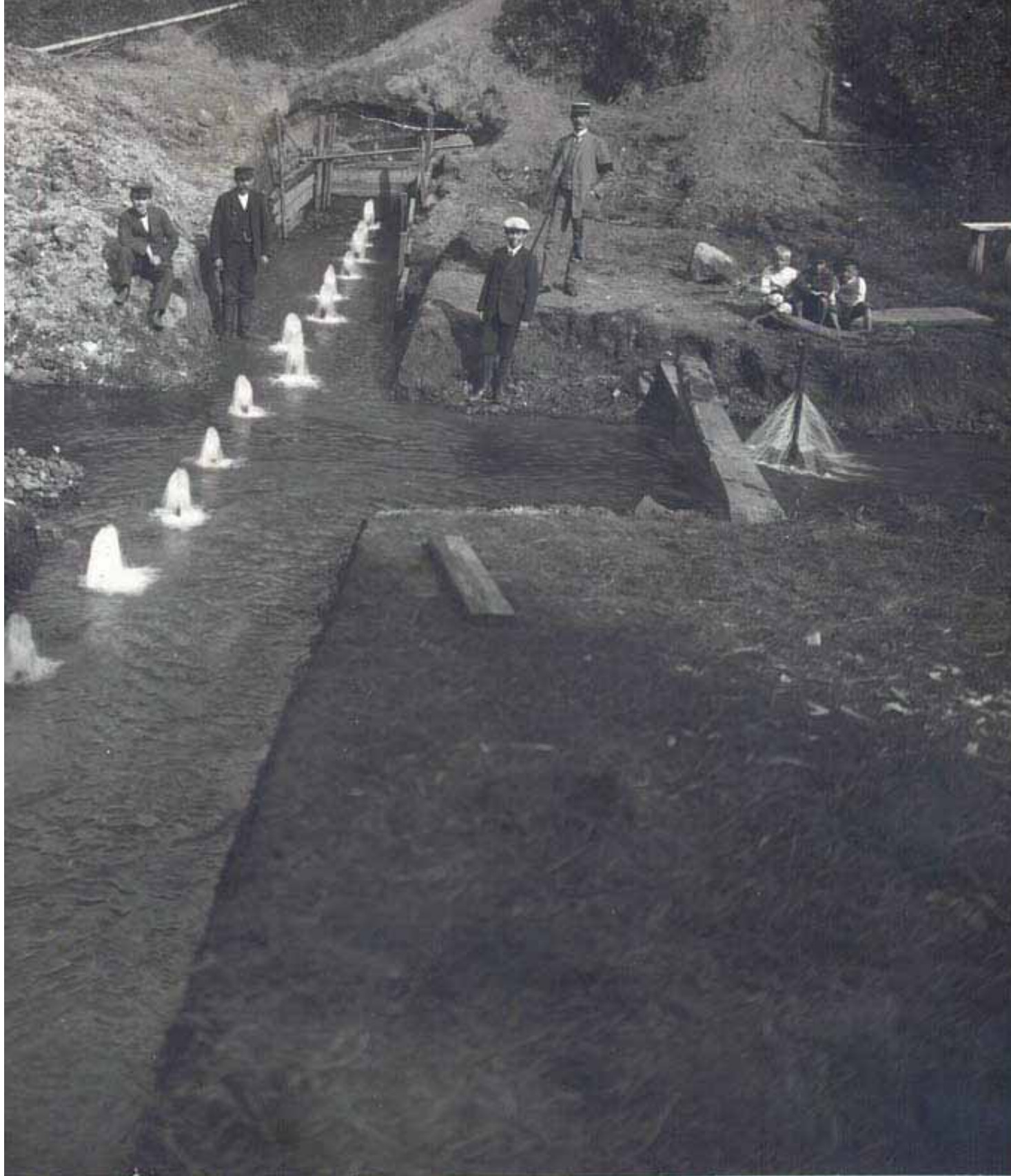
Kuva 6.13. Pohjavesitutkimus Tampereen Vuohenojalla vuonna 1916. Tämä kuva löytyi Porin Veden kuva-arkistosta ja sen on todennäköisesti aikoinaan Poriin lähettänyt B. Gagneur. Hän johti Vuohenojalla pohjavesitutkimuksia vuosina 1916-1917. Ks. asiasta tarkemmin Juuti & Katko 1998.
