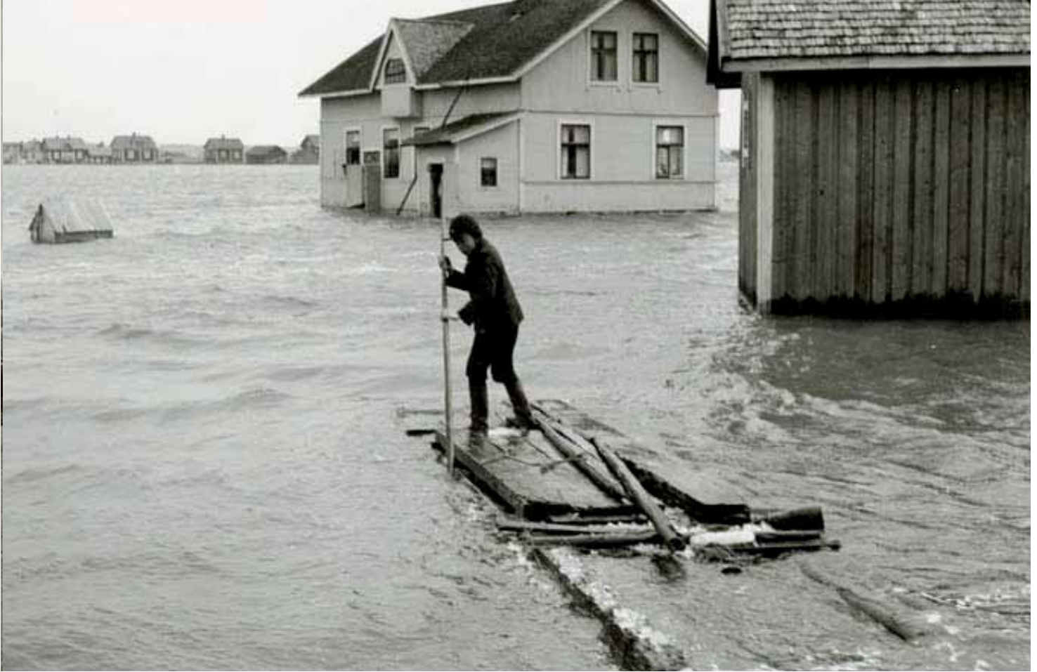
Kuva 4.12. Etenkin Kokemäenjoen pohjoispuolella sijaitseva Toejoen alue kärsi pahoista tulvista, jotka turmelivat rakennuksia. (Satakunnan Museo)
