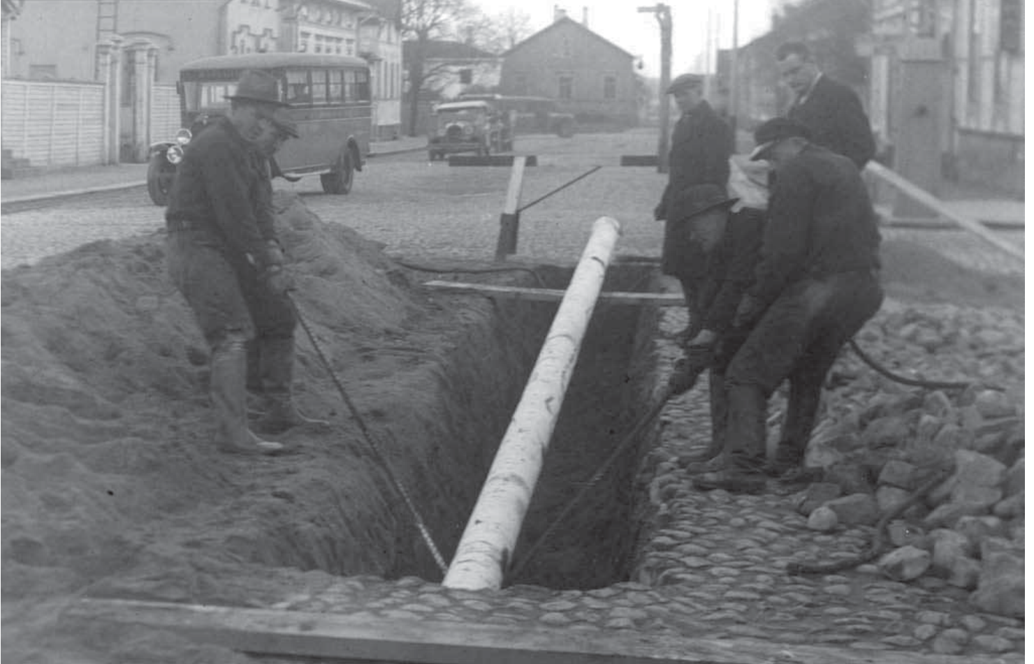
Kuva 6.18. Valtakadulla lasketaan runkovesijohtoa miesvoimin. (Satakunnan Museo)
