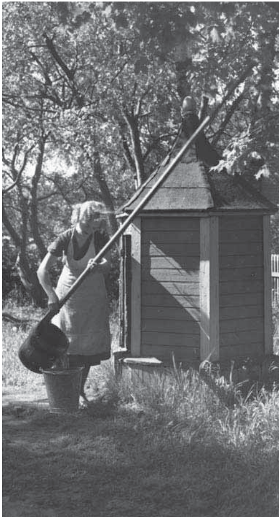
Kuva 5.8. Vettä hakemassa kaivosta vuonna 1934. Huomaa kätevä vedenostin. (Satakunnan Museo)
