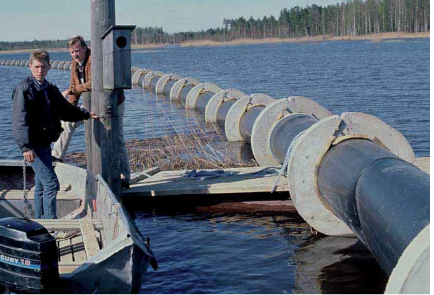
Kuva 9.38. Raakavesiputken lasku vuonna 1989. Kuvassa ollaan Palusjärven pohjoispäässä, Kyytimenluodon luona. Oikealla, linnunpöntön takana, Pertti Aaltonen. (Porin Vesi)
