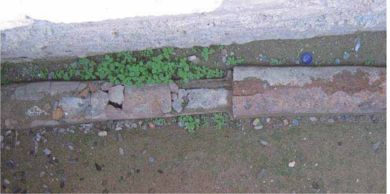
Kuva 3.4. Minolaiskauden savinen vesiputki, Knossoksen palatsi, Kreetta. Palatsiin johdettiin vettä näillä putkilla läheiseltä vuorelta. Huomaa putkien kapeneva muoto, jonka avulla ne saatiin liitettyä kätevästi toisiinsa. (Juuti 2005)
