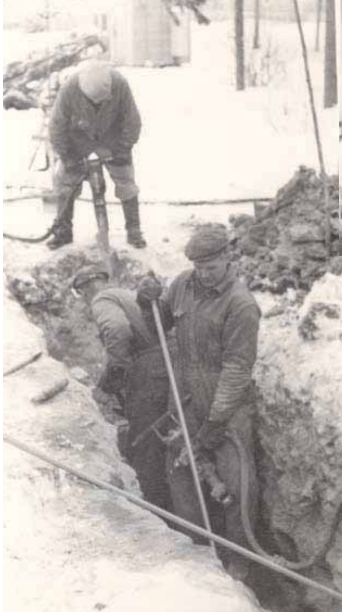
Kuva 9.19a ja b. Vasemmalla vesi- huoltotöitä talvella. Kuvassa edessä Aatos Kulmala. Yläpuolinen kuva otettu 24.2.1954. Huomaa työssä apuna käytetyt kolmijalat. (Porin Vesi)
