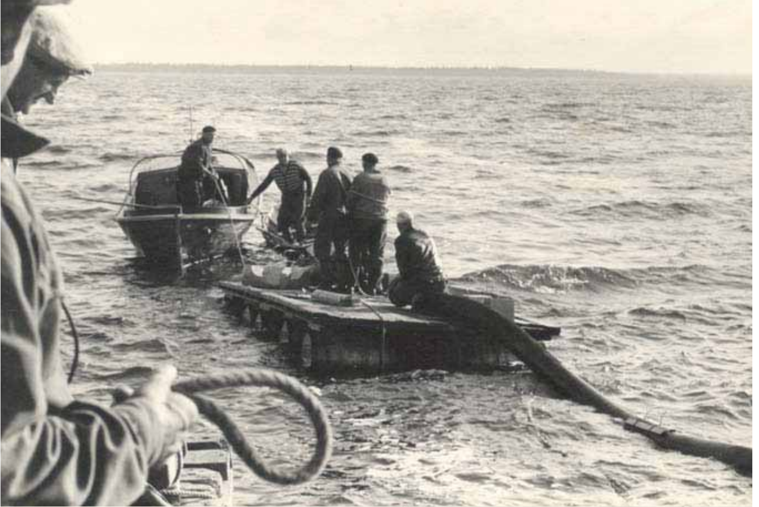
Kuva 9.14a ja b. Yläkuva: kumiputken laskussa oli vene apuna. Alakuva: kumiputken laskua Mäntyluodon puoleisessa päässä. (Porin Vesi)
