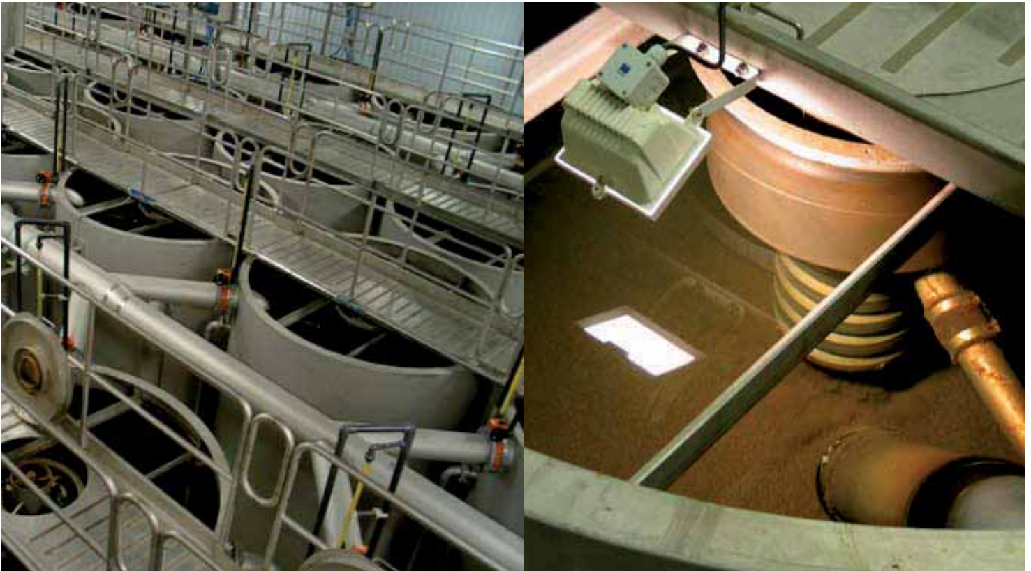
Kuva 7.29a ja b. a) Harjakankaan DynaSand-patteristo (4x7) ja b) pulppuaminen (Katko 2009)
