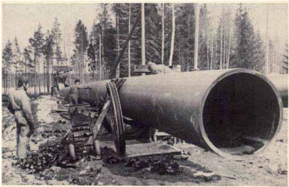
Kuva 7.9. Harjakankaan vesilaitoksen 1200 mm imujohdon saumahitsaustyö meneillään 1976.(VL VK 1976)
