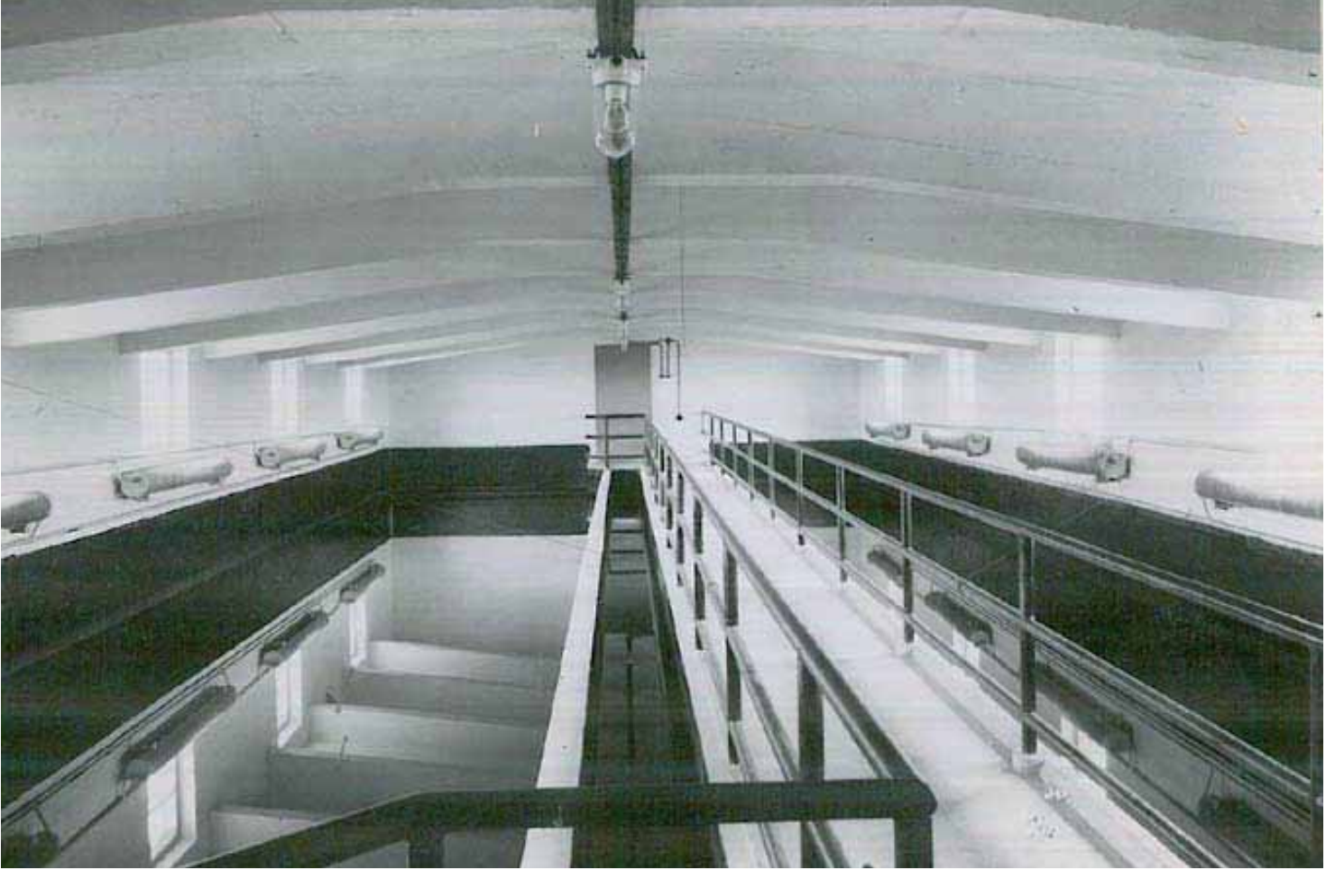
Kuva 6.33. Lukkarinsannan pintavesilaitoksen saostusaltaat. (Porin Vesi)
