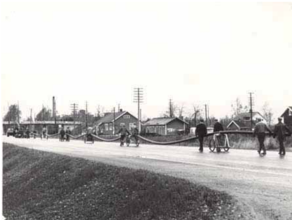
Kuva 9.11a ja b. Muoviputken saapuminen Poriin. Tämä kuvan 100 metriä pitkä muoviputki asennettiin rautatienalitusputkeksi. Näyttävä kuljetus saapui Ulvilasta Poriin vuonna 1962. (Porin Vesi)
