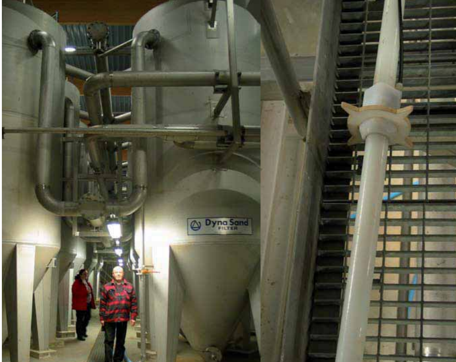
Kuva 7.30. Noin 6 m korkea DynaSand-kartio, jonka pohjalta hiekka pumpataan mammut-pumpulla suodattimen yläosaan. (Katko 2009)
