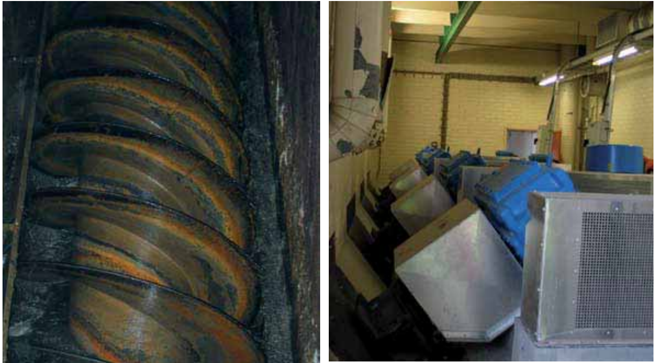
Kuva 8.9a ja b. Luotsinmäen puhdistamon tulopumppaamon ruuvipumppu sekä ruuvipumppujen yläpää. (Katko 2009)
