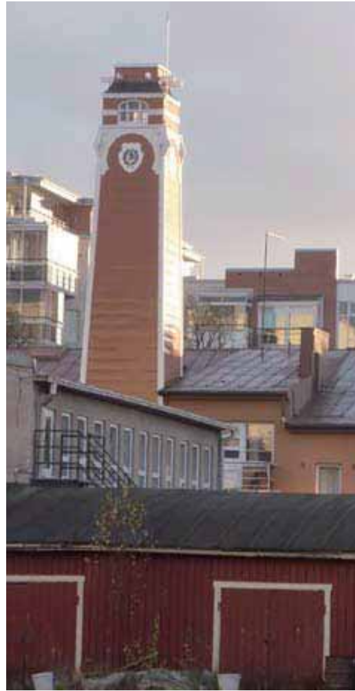
Kuva 2.5. Näkymä Porista. Vanhan paloaseman torni. (Juuti 2009)
