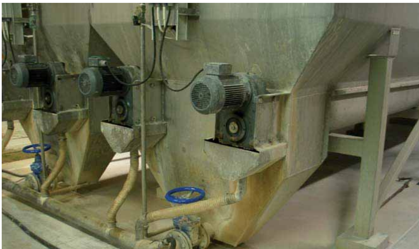
Kuva 7.26. Kalkkisiilot ja kalkkivedenselkeyttimien pohjakourut, josta sinne liukenematon kalkkisakka ja kalkin mukana tullut liukenematon kiviaines las-ketaan vuotovesikaivoon ja pumpataan edelleen Tyvijärvenrannassa olevaan ”kalkkikanavaan” josta liukenematon kalkkisakka ja kiviaines siirretään vuo-sittain lähiseudun pelloille maanparannusaineeksi. (Katko 2009)
