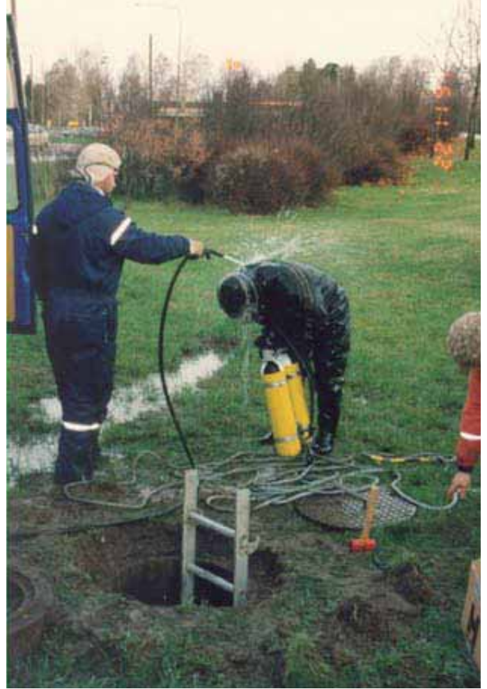
Kuva 9.43c. Matti Ristolainen pesee sukeltajaa viemärisukelluksen jälkeen. (Porin Vesi 22.11.1991)
