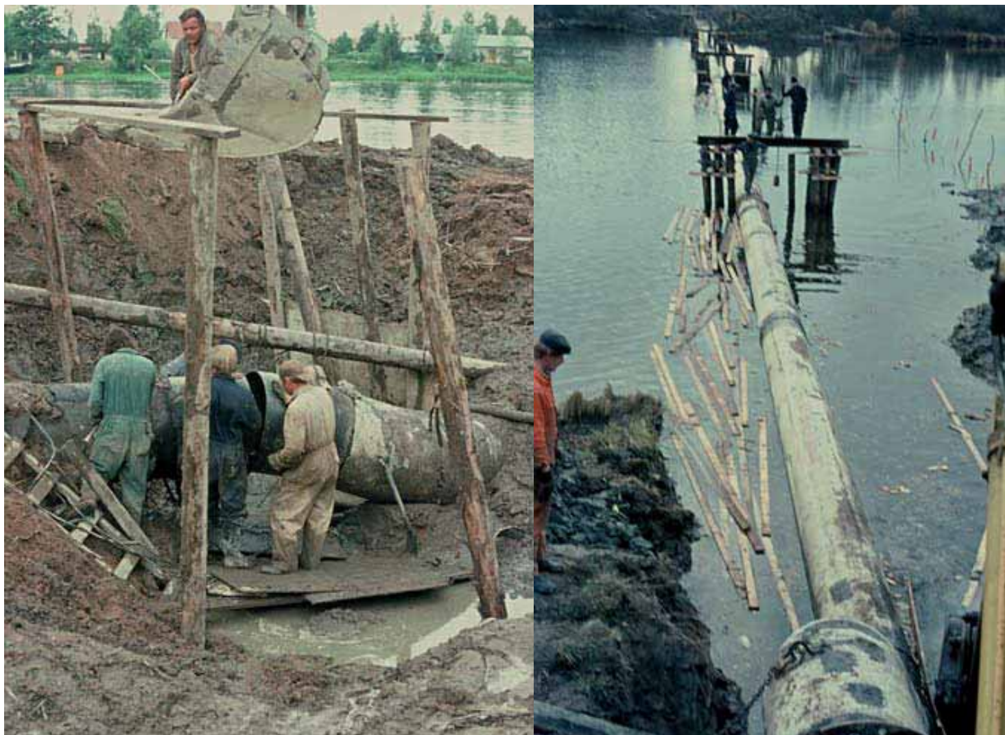
Kuva 9.34a ja b. Porin vesihuollon rakentaminen on edellyttänyt vesistöjen alituksia. Kuvissa tehdään putkea Harjakankaalta Lukkarinsantaan ja kyseessä on Kokemäenjoen alitus. Huomaa Timo Irjala kaivurin kauhassa. Alapuolella vasemmalla Pauli Vasama ja keskellä Pertti Kekki. (Porin Vesi)
