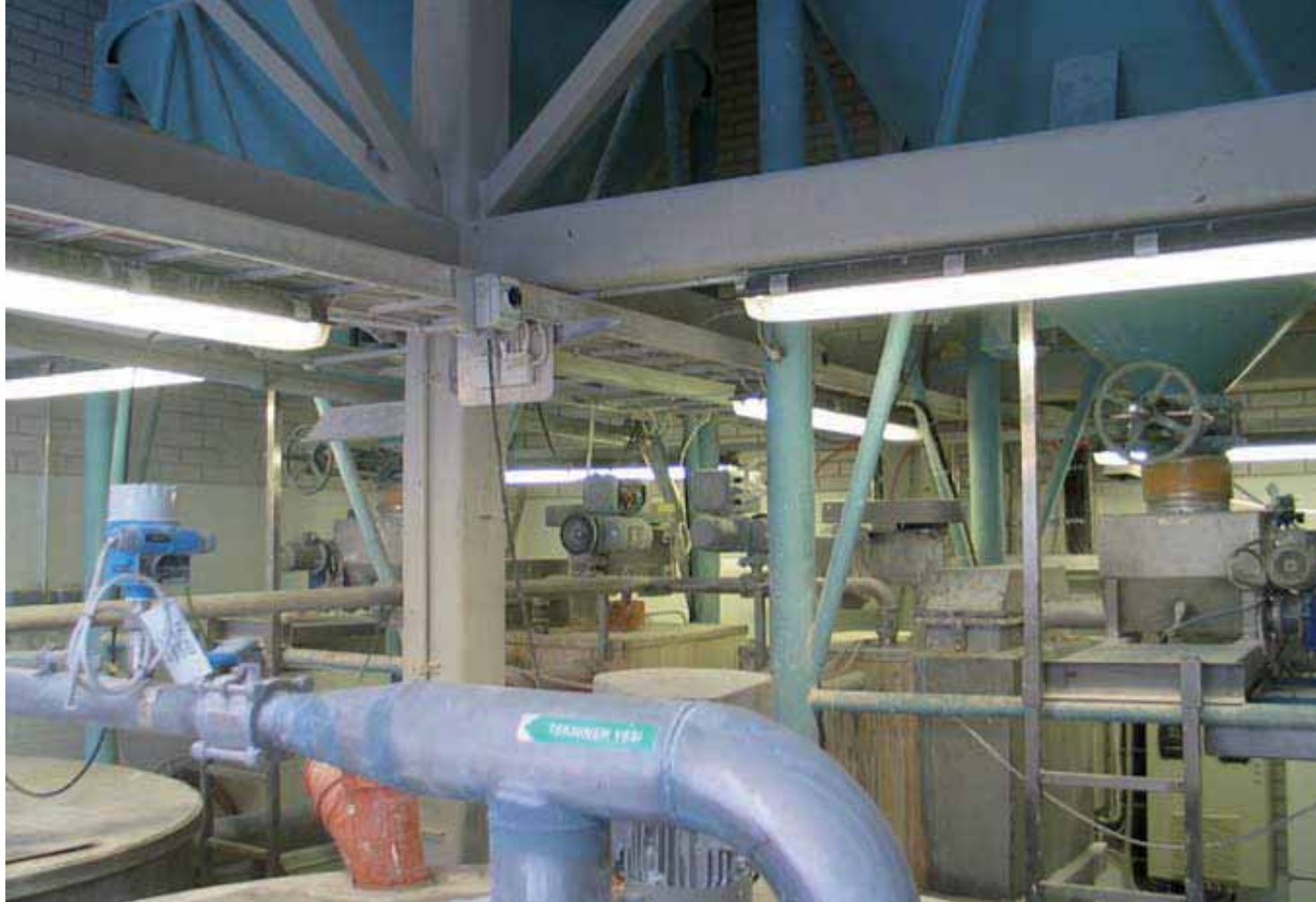
Kuva 7.26. Kalkkisiilot ja kalkkivedenselkeyttimien pohjakourut, josta sinne liukenematon kalkkisakka ja kalkin mukana tullut liukenematon kiviaines las-ketaan vuotovesikaivoon ja pumpataan edelleen Tyvijärvenrannassa olevaan ”kalkkikanavaan” josta liukenematon kalkkisakka ja kiviaines siirretään vuo-sittain lähiseudun pelloille maanparannusaineeksi. (Katko 2009)
