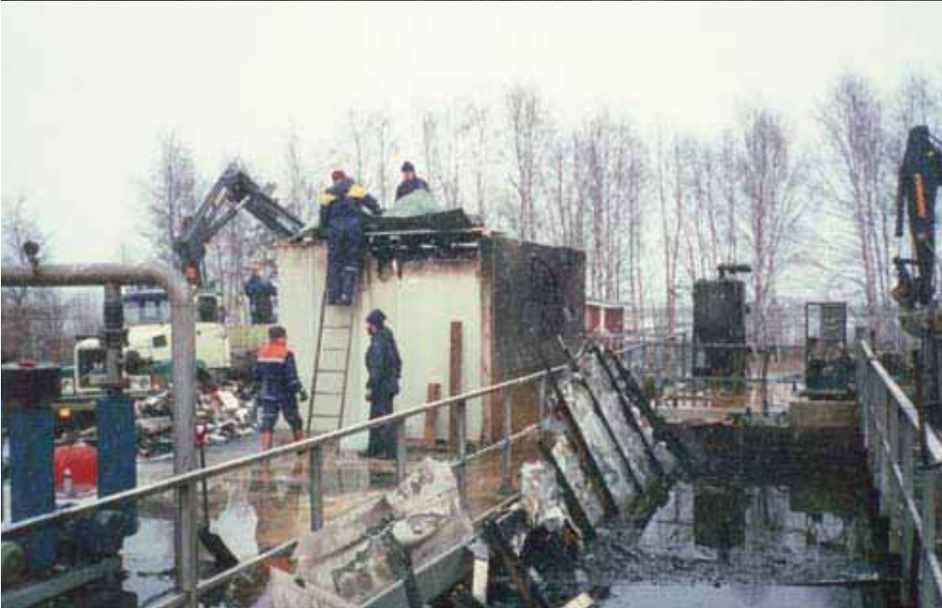
Kuva 8.20e. Jälkien korjausta tuhopolton jälkeen Reposaaren jätevedenpuhdistamolla. (Porin Vesi 1996)
