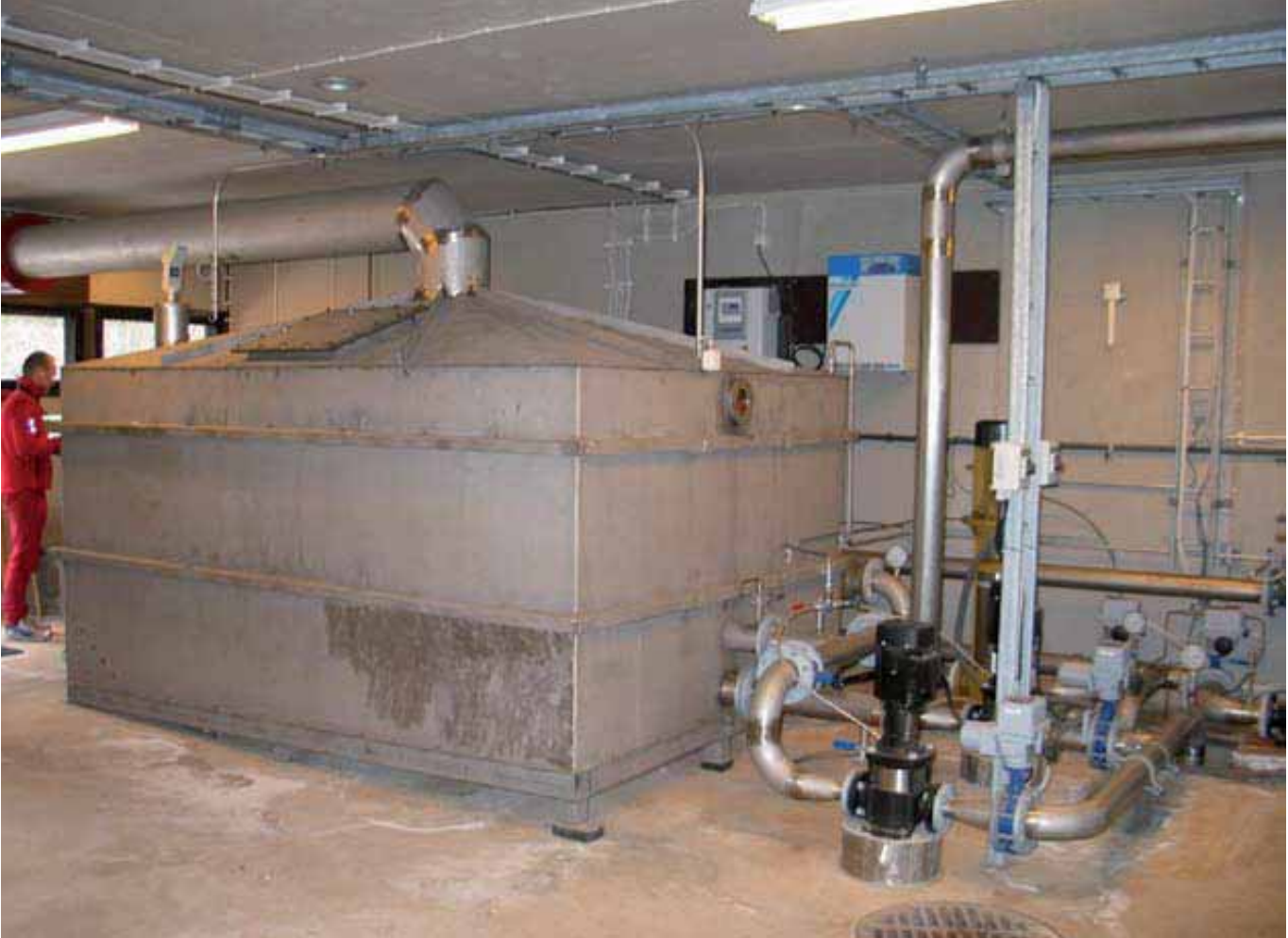
Kuva 7.42a ja b. Ahlaisten pohjavedenottamon ilmastussäiliö ja kompressori. (Katko 2009)
