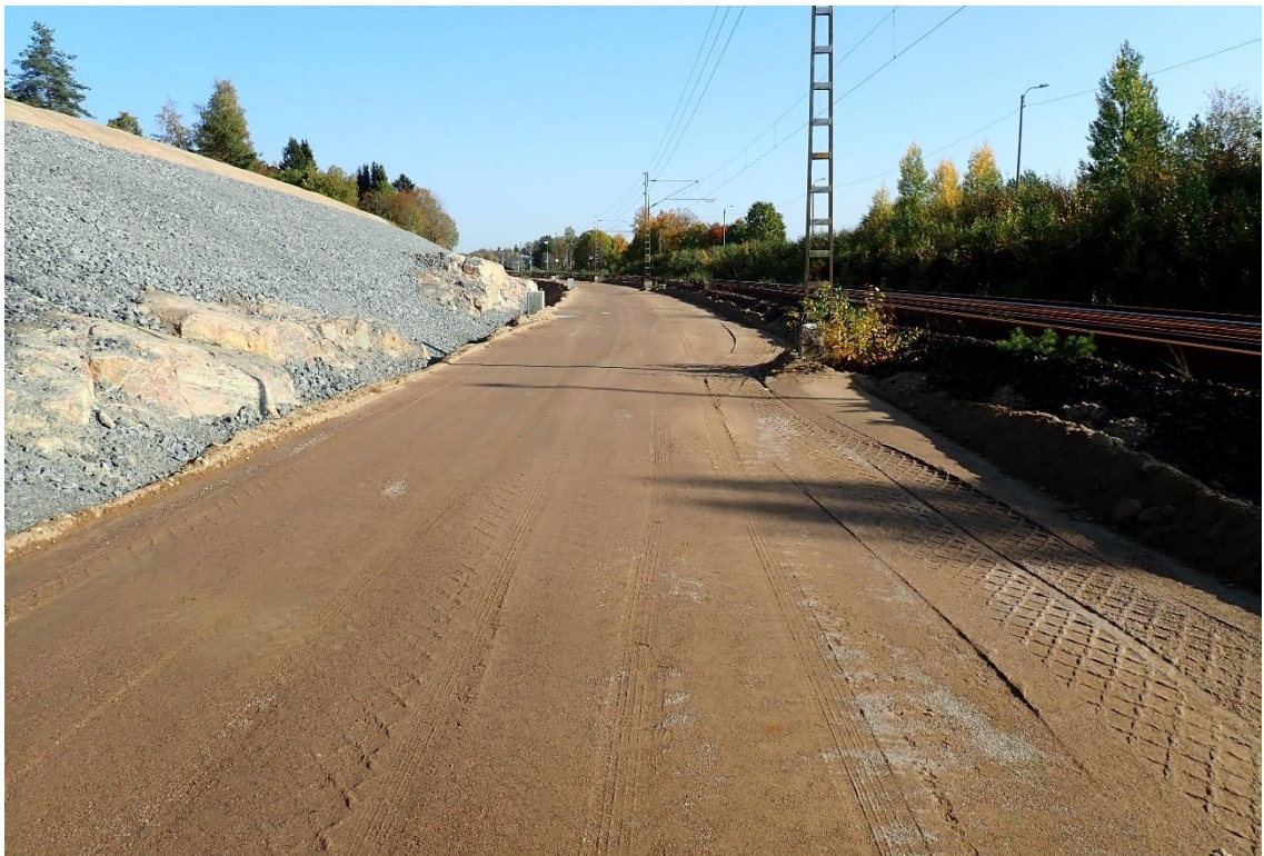
Kuva 6.1: Mittauspäivänä tiivistetty eristyskerros
