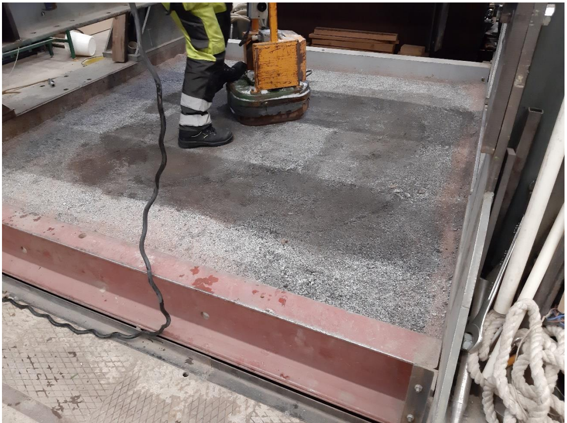
Kuva 6.20: Koerakenteen alusta ja tiivistämiseen käytetty tärylevy
