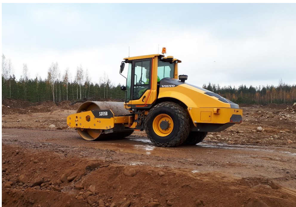
Kuva 6.6: Koepenkereiden tiivistämiseen käytetty 13 t valssijyrä
