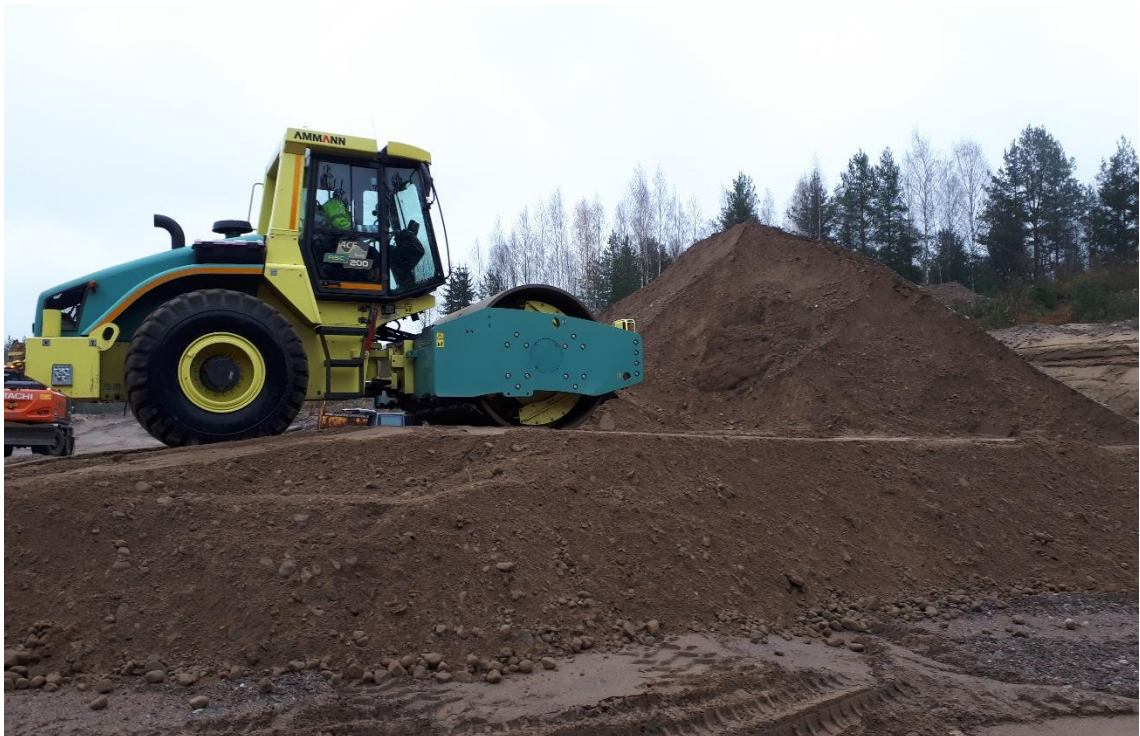
Kuva 6.12: Penkereen I tiivistys 23 t valssijyrällä
