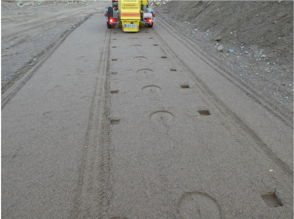
Kuva 6.13: PPL-mittaukset penkereelle E
