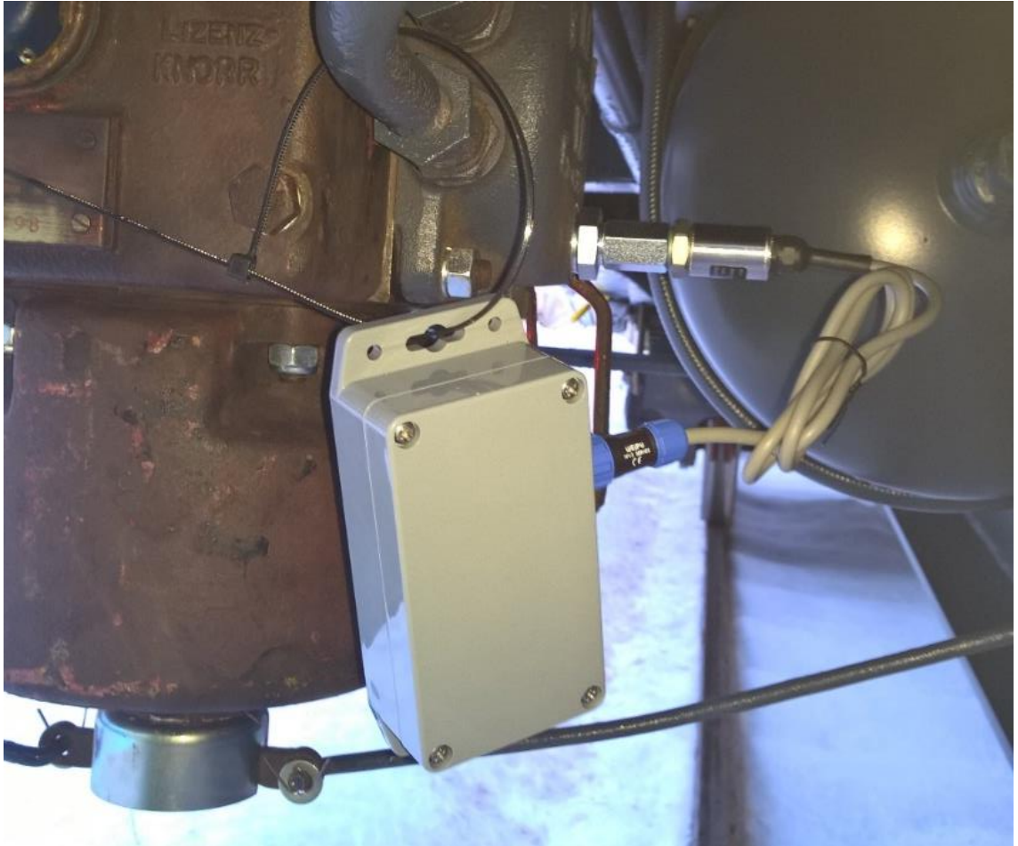
Kuva 27. Jarrusylinterin mittaus toimiventtiin lohkosta
