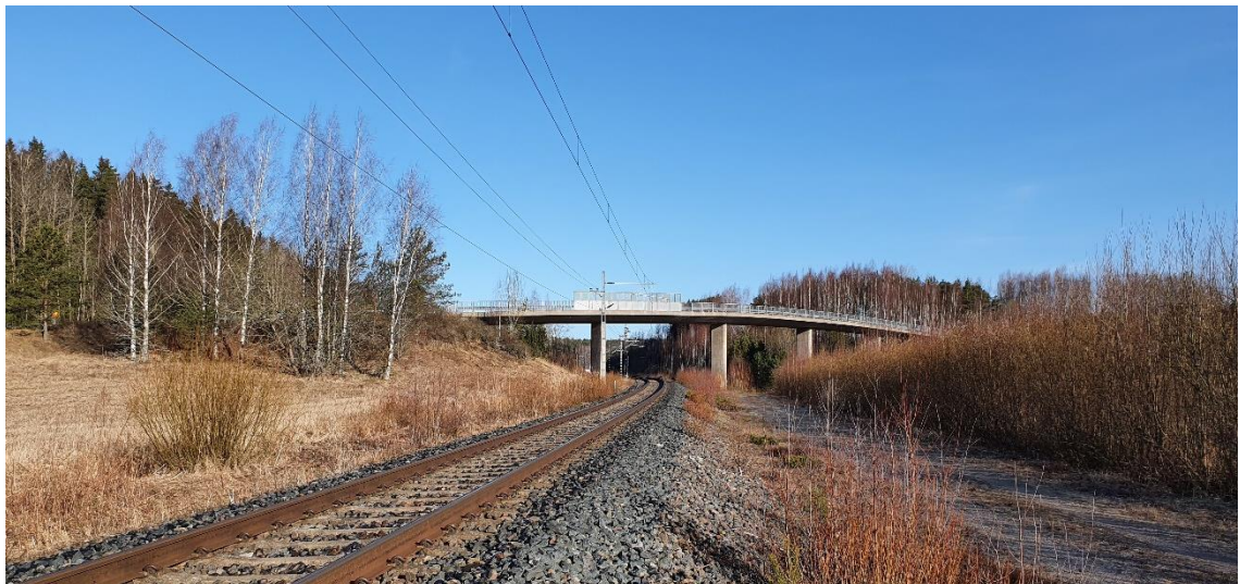
Kuva 31. Yliskylän ylikulkusilta km 129+502.
