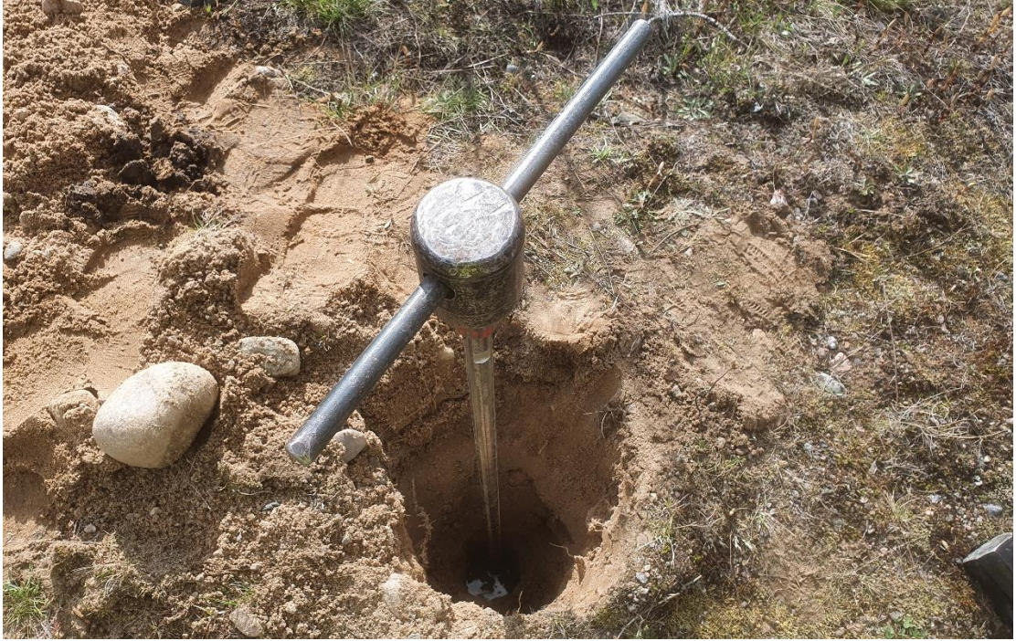
Kuva 38. Kierrekairan asennus maahan.
