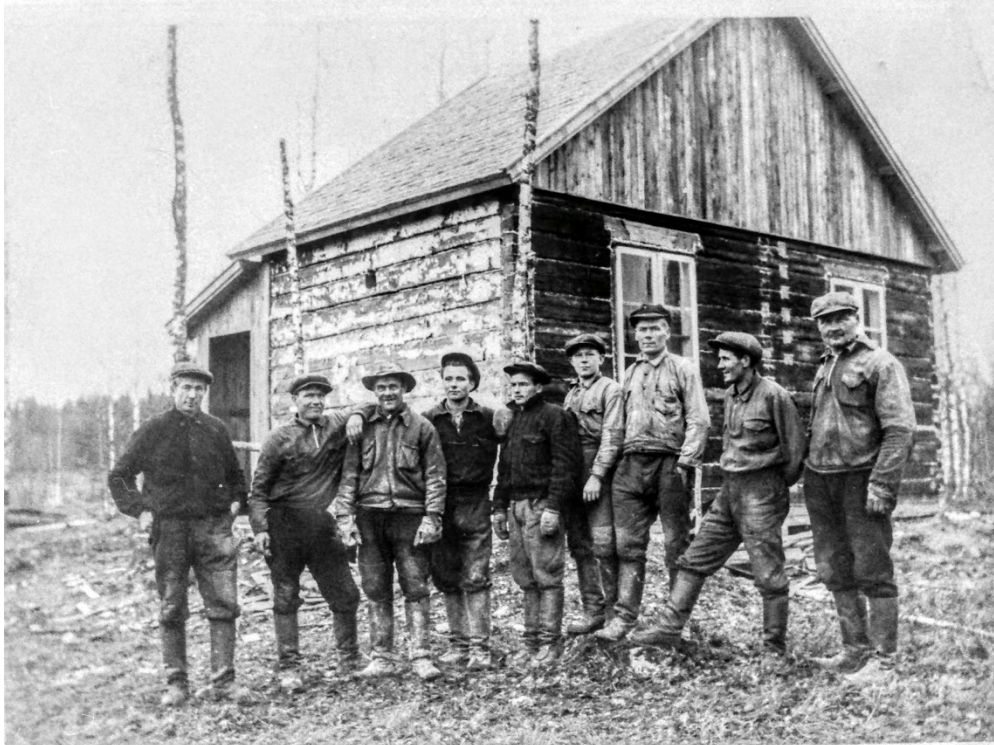
Kuva 5 Kantolan kartanon vierasrakennuksen hirsistä rakennetaan uutta taloa, kartanon mentyä konkurssiin vuonna 1935. Lähde: Luopioisten aineistopankki
