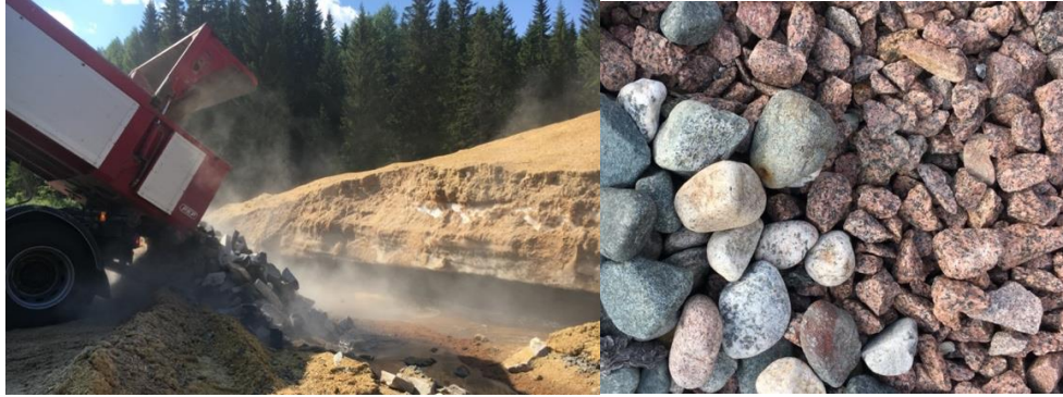
Kuva 18. A) Sivukivi louhetäyttö B) Mursketuotannon sivutuotteina syntyneitä seulanpääkiviä sekä mursketta
