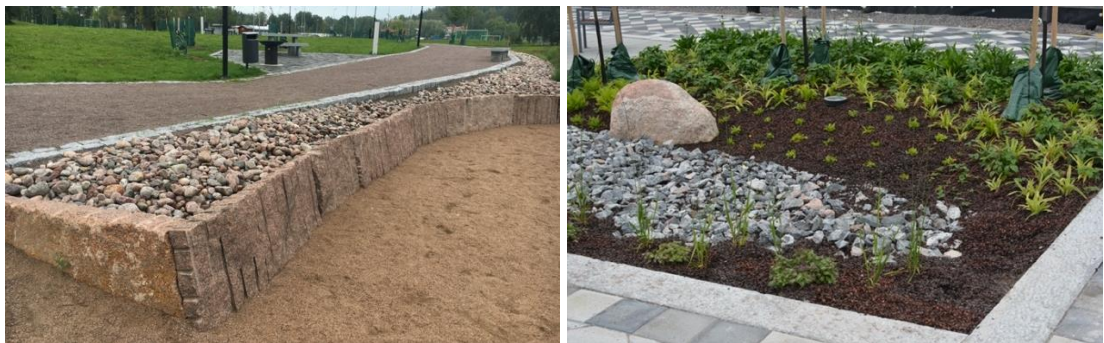
Kuva 20. Puisto- ja kaupunkirakentaminen A) Poskikivet, Mäntsälä B) Hulevesien imeytysalue, Tuusula
