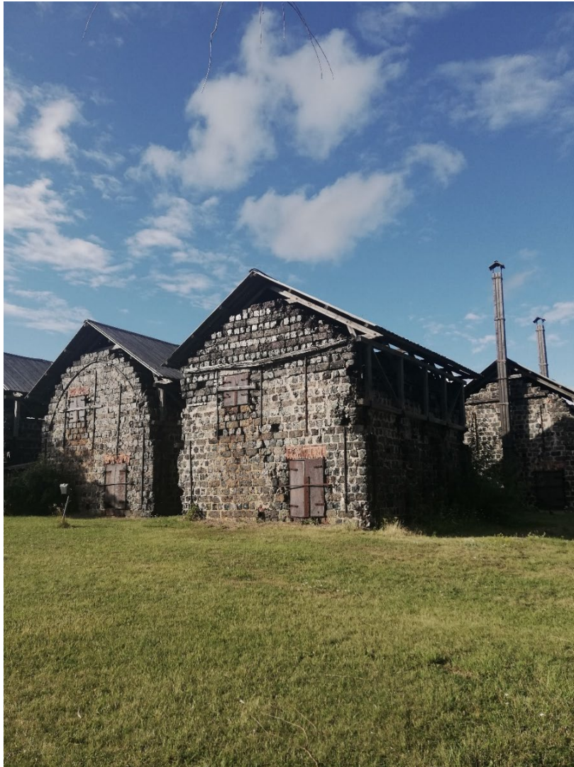
Kuva 27: Vanhoja hiiliuuneja Taalintehtaalla (1853-1910). Puhtaasti funktionaalisetkin rakennukset kiehtovat meitä ja kertovat tarinoita paikan historiasta.
