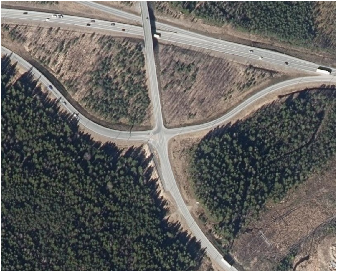
Kuva 41: Yhdystien 3400 ja valtatie 9 eritasoliittymän ramppi (Maanmittauslaitos 2020)
