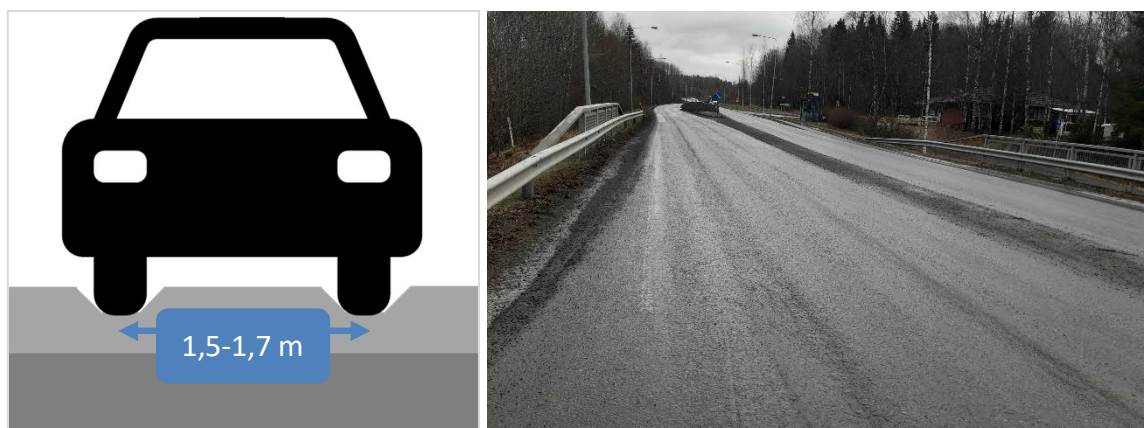
Kuva 5. Päällysteen nastarengaskulumisurat (Tuomala 2020).
