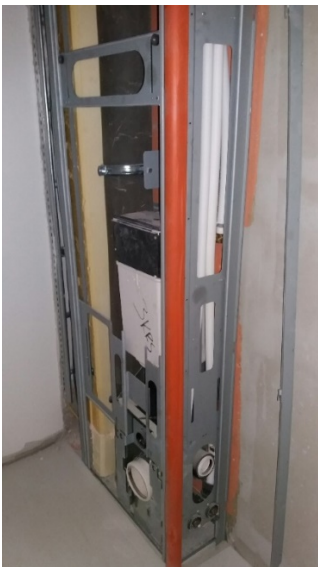
Kuva 15. Elementti kiinnitettynä paikalleen.
