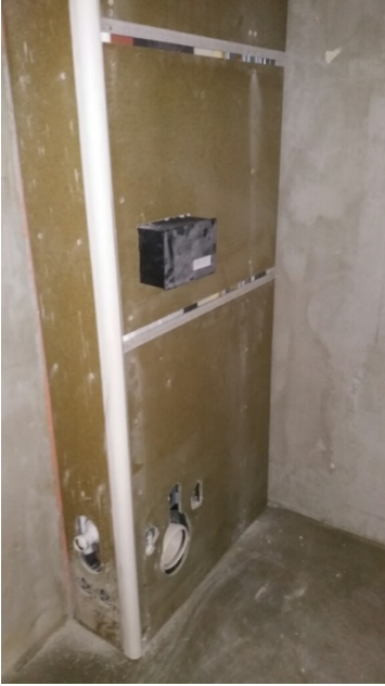
Kuva 16. Elementin levyttäminen/pellitys ja kulmalistan asentaminen.
