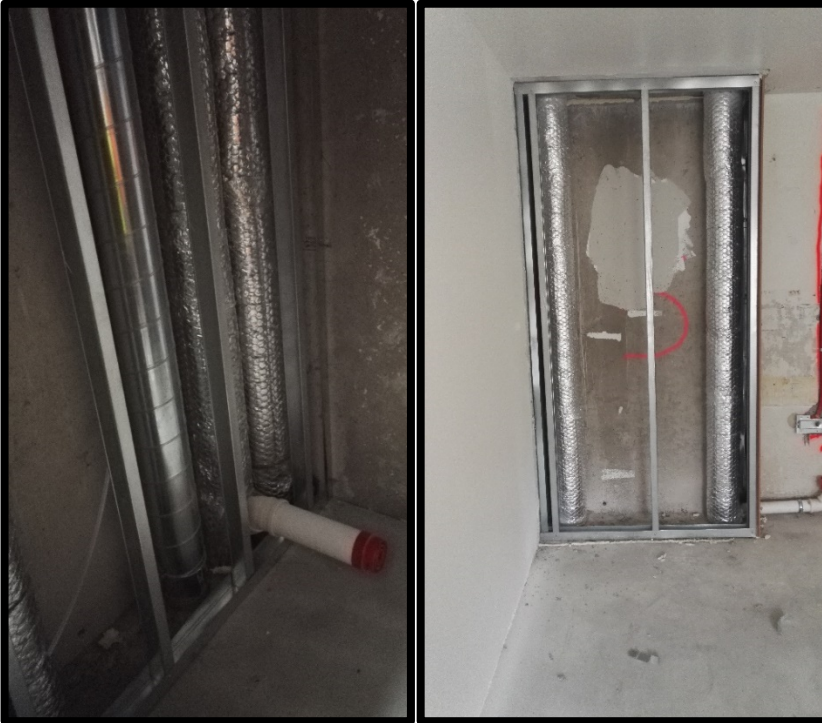
Kuva 23. Eristysten jälkeen asennetaan hormin runko. Elementtinousu toimii hormin runkona.
