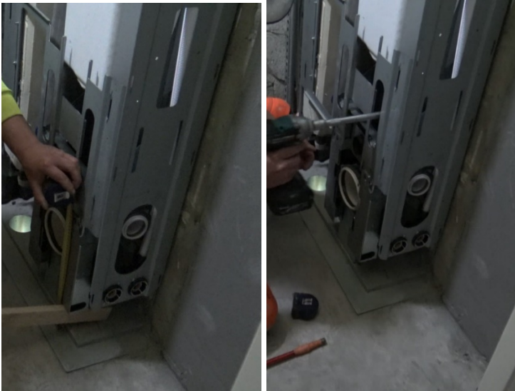
Kuva 14. Elementin korkeusaseman säätämistä ja kiinnittämistä paikalleen.
