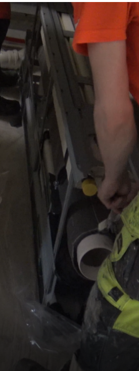
Kuva 12. Elementin viemäriputken eristeen muokkaamista/leikkaamista asennusta varten.
