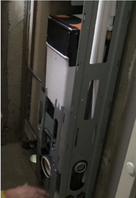
Kuva 13. Elementti nostettuna paikalleen.
