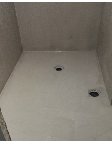
Kuva 25. Kylpyhuoneen lattia ja seinät vedeneristetään paikalla rakennetun hormin seinät mukaan lukien.
