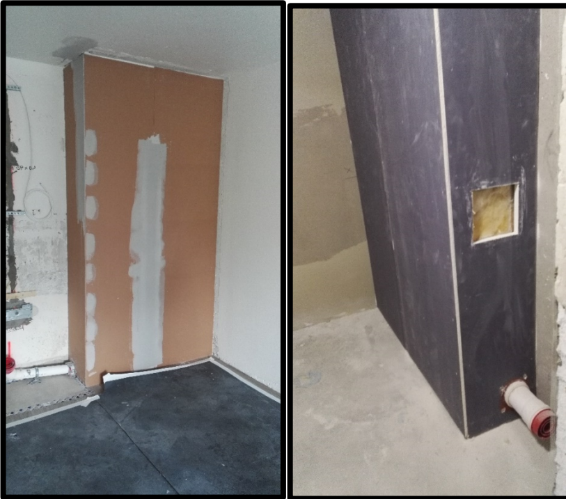
Kuva 24. Hormin rungon jälkeen hormi levytetään umpeen.
