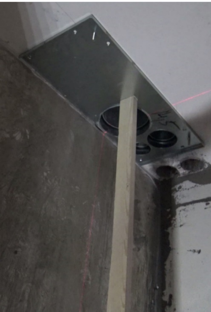
Kuva 6. Edellisen kuvan alakattoon on kiinnitetty erillinen alakattoon jäävä metallilevy.
