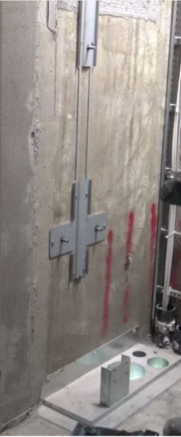
Kuva 11. Elementin taustalevy asennettu paikoilleen.
