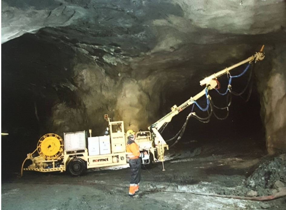
Kuva 4. Ruiskutusrobotti ja sitä ohjaava työmies (BY63 2015)
