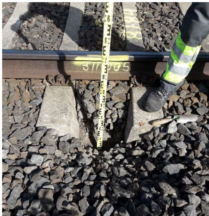
Kuva 7.3. Tukikerrosnäytteenotto nykyohjeistuksen mukaan.
