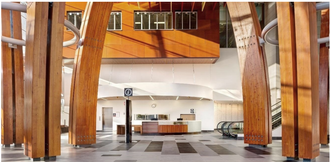
Kuva 19 Surrey Memorial Hospitalin aulatilaa kannattelevat puun runkoja muistuttavat pylväät (Timber Tonic: How Wood and Natural Materials Can Transform Healthcare Facility Design 2019).
