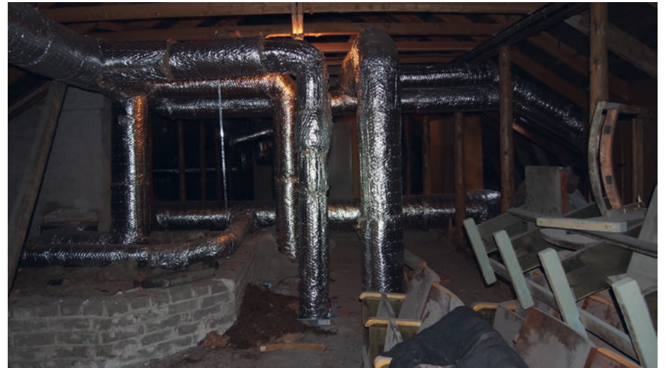
Kuva 144: Koska ullakolle ei ole suunniteltu mitään käyttötarkoitusta, on ilmanvaihtoputkien reiteille ollut runsaasti tilaa. Oikealla kuvassa on kasa teatterin penkkejä. Ei ole tietoa, ovatko penkit alkuperäisiä vai teatterin remontin yhteydessä varalle teetettyjä. Ullakolta on tosin löytynyt aikoinaan paljon suojeluskunnan omaisuutta, kuten Perinnehuone Suojalukossa näytillä olevat puhallinsoittimet.
