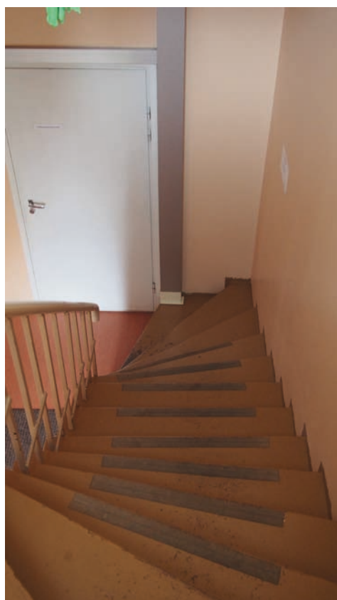
Kuva 122: Siiven portaikko välitasanteelta katsottuna. Sähkövedot kiinnittävät huomion, sillä koteloinnit on tehty myös yläkerrassa suoraan seinän pintaan.
