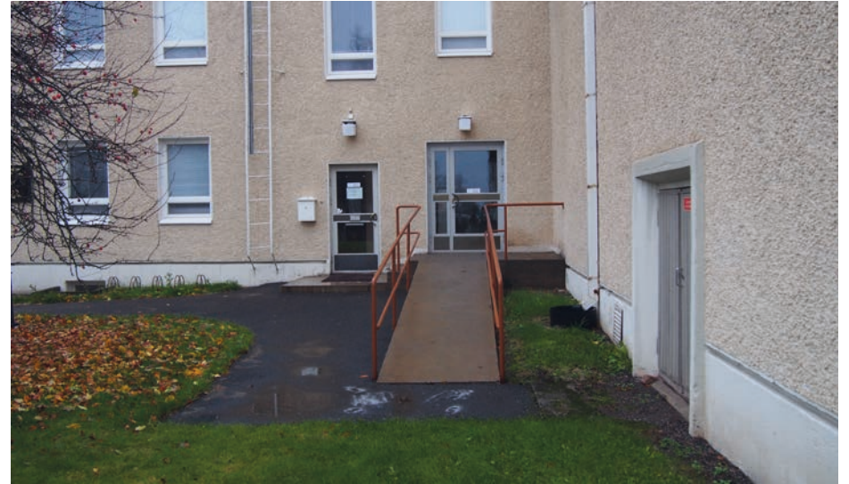
Kuva 56: Kolmesta ovesta vasemmanpuoleisin johtaa vanhan postisiiven porrashuoneeseen. Porrasaskelman vuoksi sisäänkäynti ei ole esteetön.
