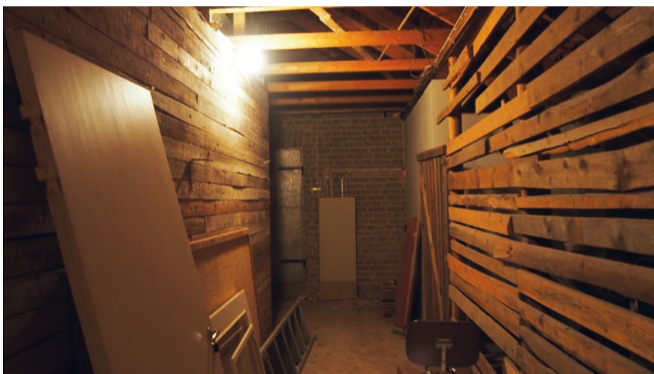
Kuva 145: Kirjaston päällä olevassa ullakkotilassa on kylmien varastotilojen (oikeassa reunassa laudoilla rajattu alue) lisäksi yksi lämmin huone (kuvassa vasemmalla, sisätilat kuva 146) sekä yksi IV-konehuone (kuvassa oikealla ennen tiiliseinää).
