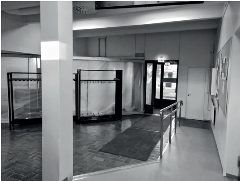
Kuva 75: Aula ennen uusien wc-tilojen rakentamista. Katossa ei tuolloin ollut vielä alaslaskua.
