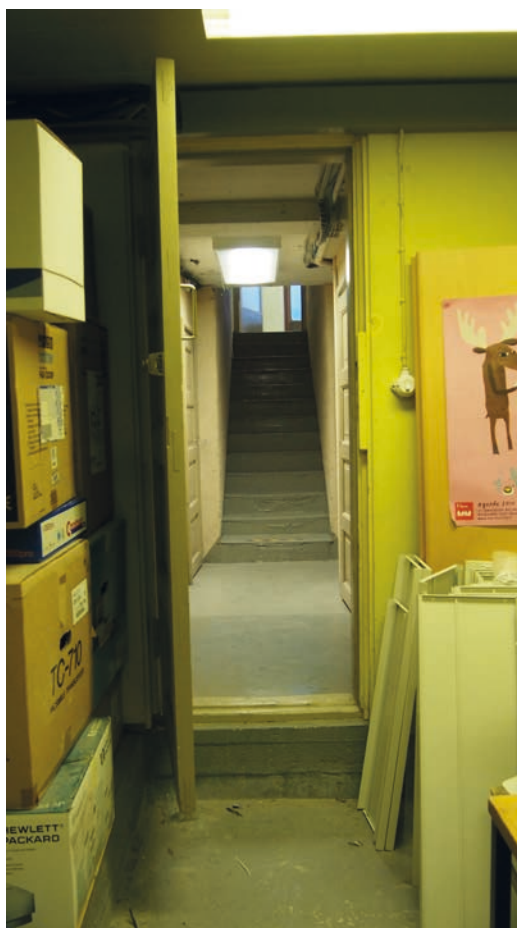
Kuva 105: Perähuoneen lattia on kellarin ”aulaa” matalammalla.
