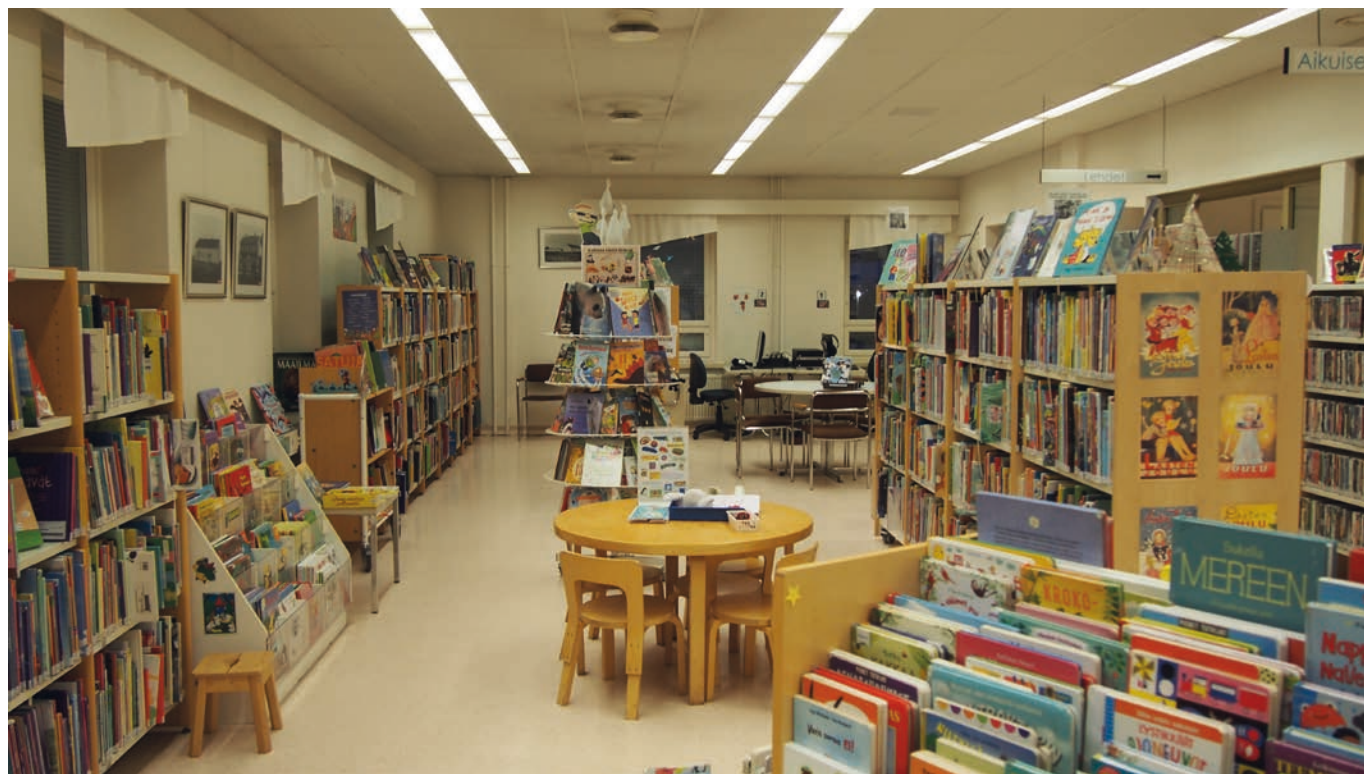
Kuva 81: Kirjaston 1. kerroksen lastenosasto lainaustiskiltä kuvattuna. Huonekorkeutta madaltaa järjestelmälakatto, jonka yläpuolelle jää tekniikalle noin puoli metriä tilaa.
