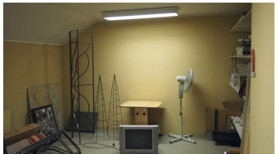
Kuva 146: Lämpöeristetty huone, jonne on suunnitteilla tuoda rakennuksen uusi iv-kone ilmanvaihtoremontin yhteydessä.
