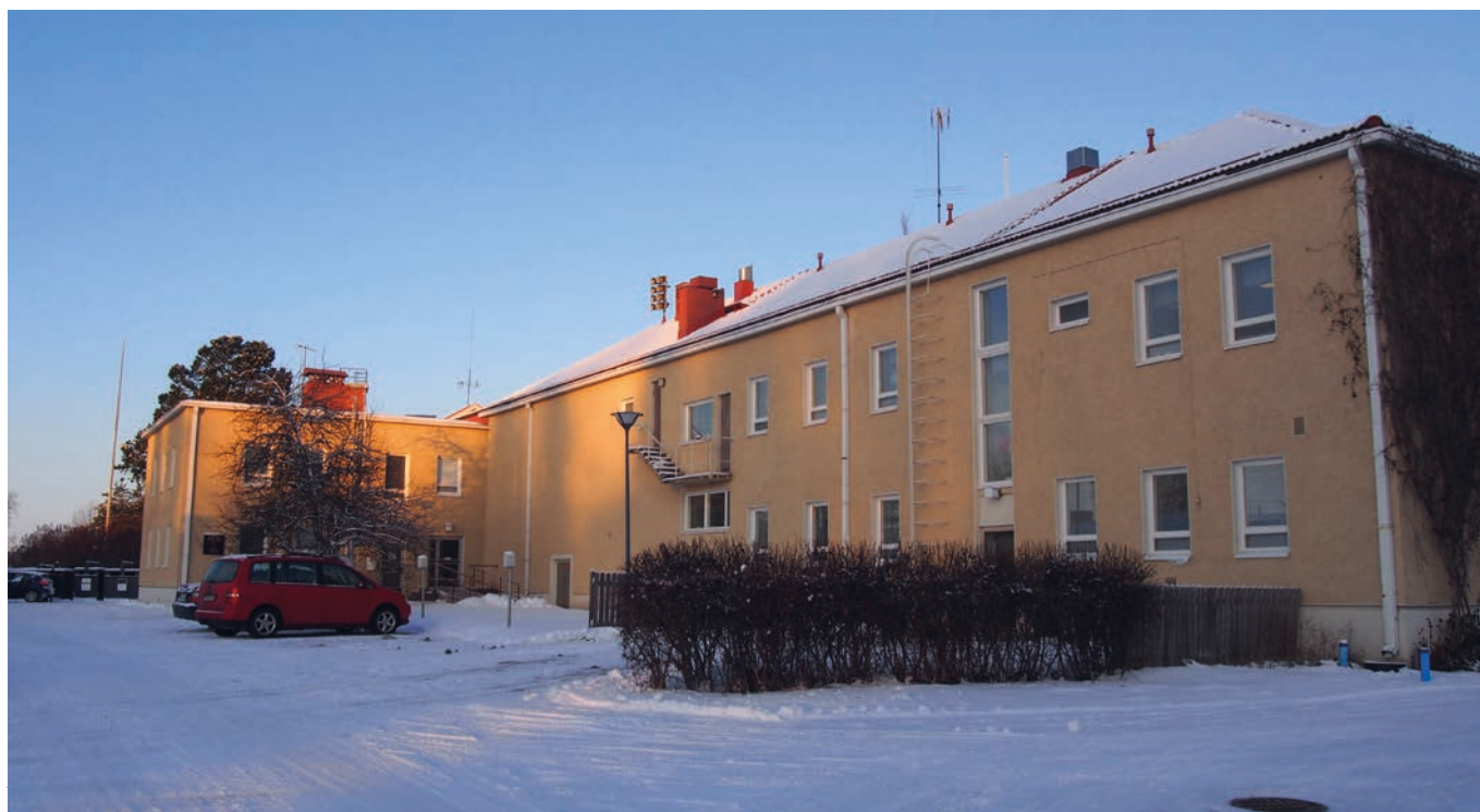
Kuva 50: Kirjaston nykyiset ikkunat takajulkisivulla. Konehuoneen portaikon yhteydessä oleva ikkuna-aukko on puolet alkuperäistä pienempi (vrt. kuva 47)
