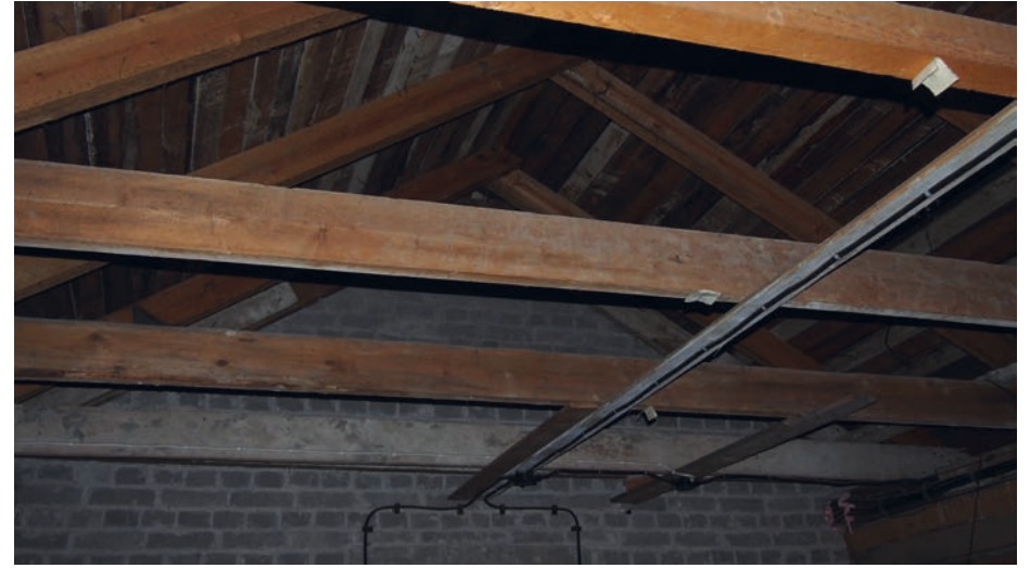
Kuva 142: Katon harjan rakenne. Taustalla näkyy sementtitiiliseinä, joka jakaa kylmän ullakon kahteen osastoon. Toinen osasto on kirjaston ja toinen aulan ja teatterin päällä.
