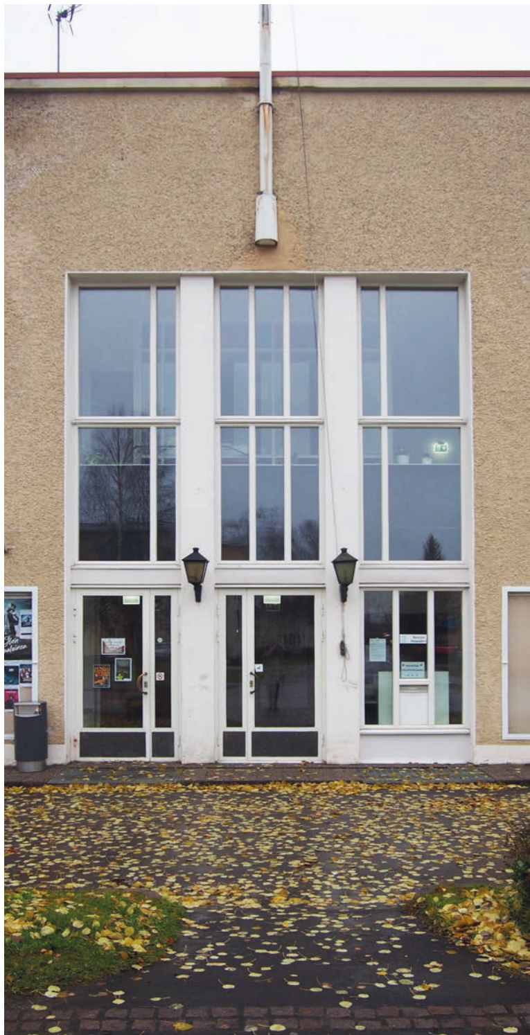
Kuva 51: Kirjaston päsisäänkäynti. Keskeisin muutos alkuperäiseen on ikkunoiden lisäksi aulassa tehty remontti, jonka seurauksena oikeanpuoleinen ulko-ovi ja keski-ikkuna vaihtoivat paikkaa. Ikkunan valkoinen luukku toimii kirjojen palautusluukkuna kirjaston ollessa suljettuna.
