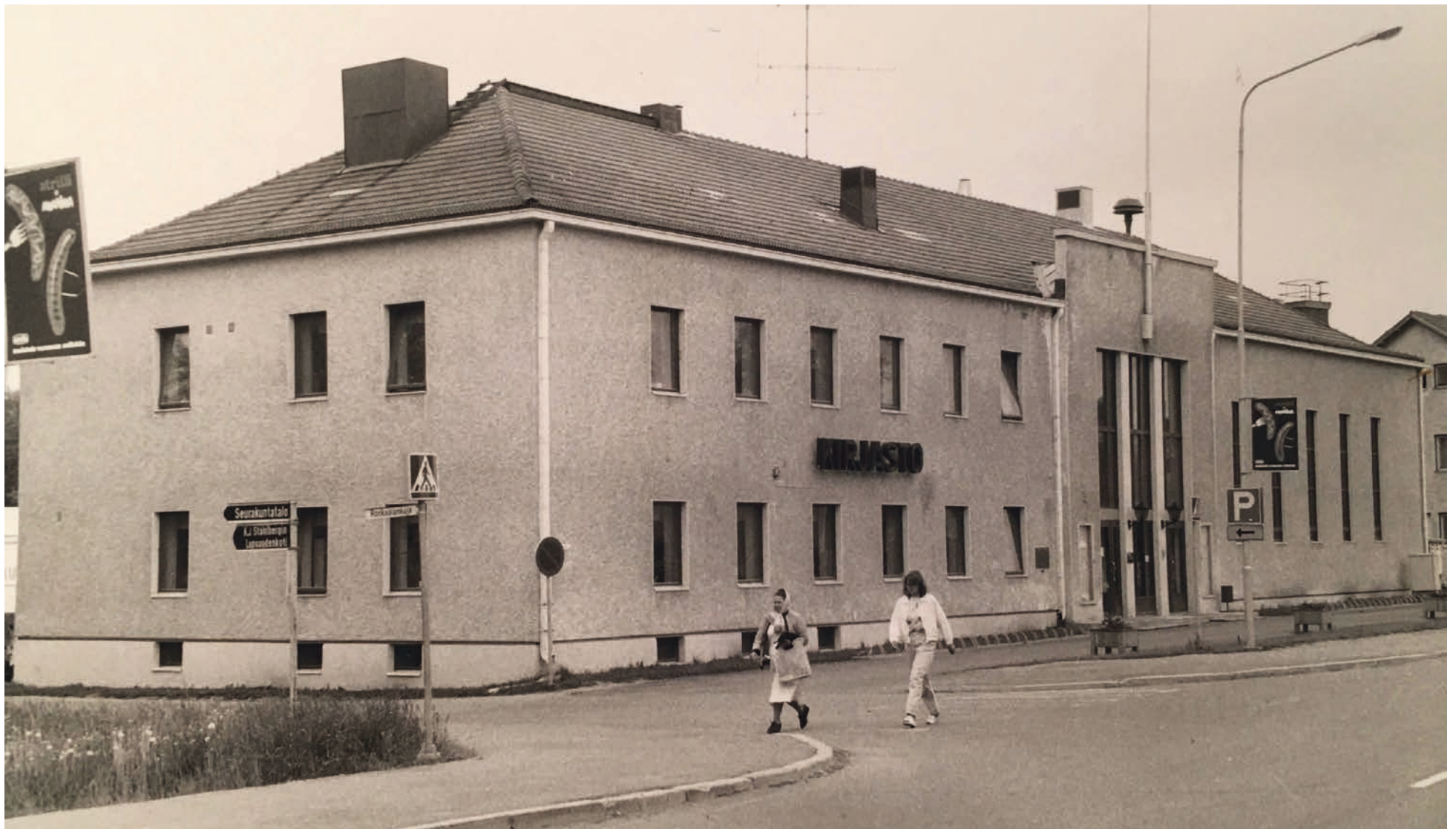
Kuva 27: Kirjasto- ja kulttuuritalo 1985. Ronkaalankuja kulkee vielä rakennuksen vierestä kohti pappilaa. Myöhemmin risteystä siirrettiin useita metrejä kauemmas kirjastosta, jolloin kirjastolle saatiin omat parkkipaikat. Kuvan lähde: Haapajärvi-Seuran kotiseutuarkisto, kuvannut Jaakonaho Pasi
