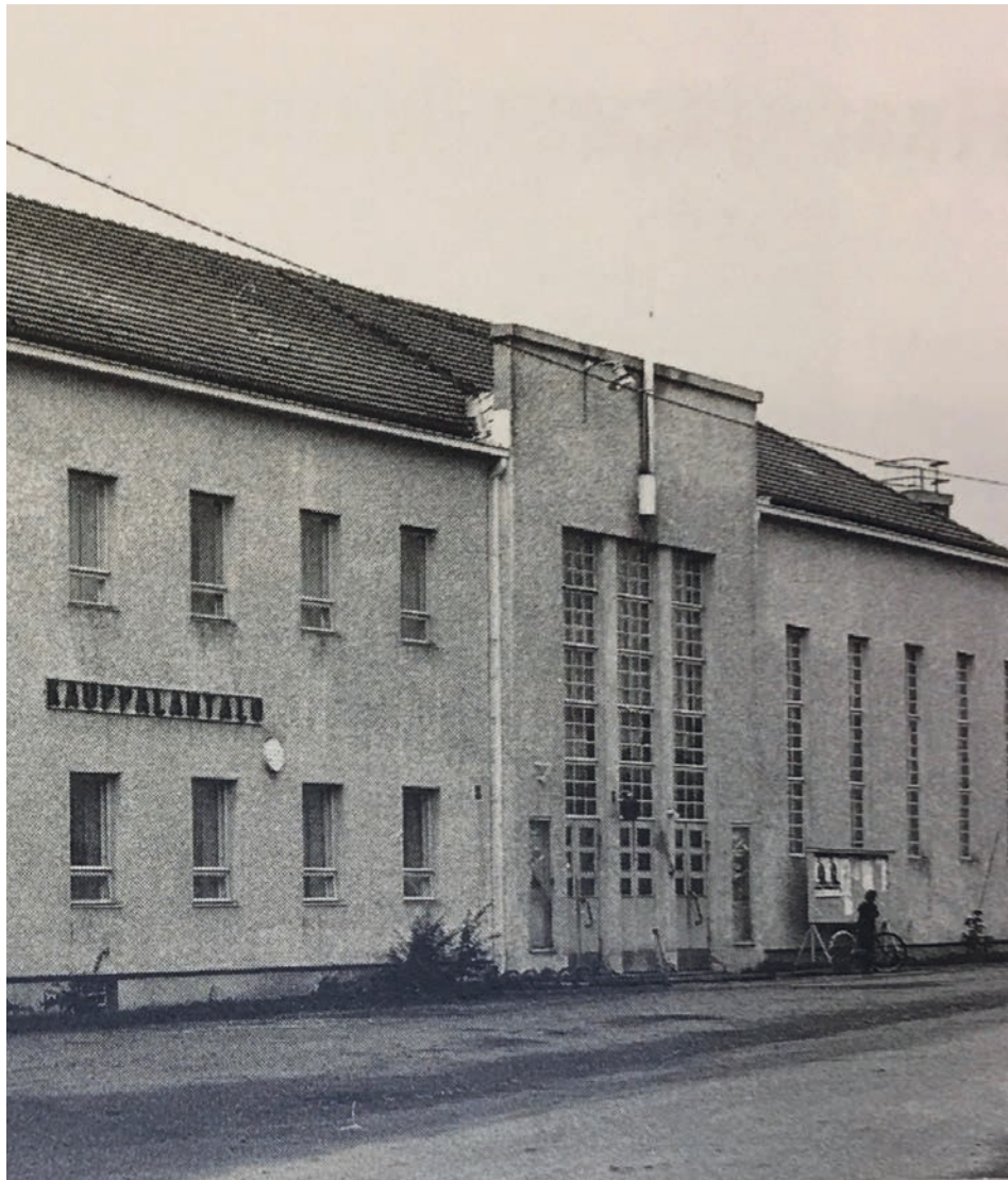
Ote kuvasta 24: Vanhan suojeluskuntatalon ikkunoiden pieniruutuisuus säilyi ainakin kauppalantaloaikoihin asti vaikka väri vaihtuikin vaaleammaksi. Voidaan myös olettaa ovien pysyneen alkuperäisinä. Kuusiruutuisista pariovista luovuttiin seuraavan ikkunavaihdon yhteydessä, eikä alkuperäisistä löytynyt ylläolevan kuvan lisäksi muuta dokumentaatiota.
