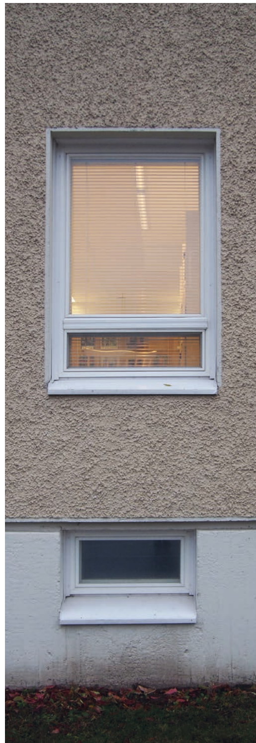
Kuva 52: Rakennuksen yleisin perusikkuna ja kellari-ikkuna. Perusikkunan kaksiosainen malli muistuttaa alkuperäistä, mutta paksummat karmit tekevät yleisilmeestä alkuperäistä tukkoisemman.
