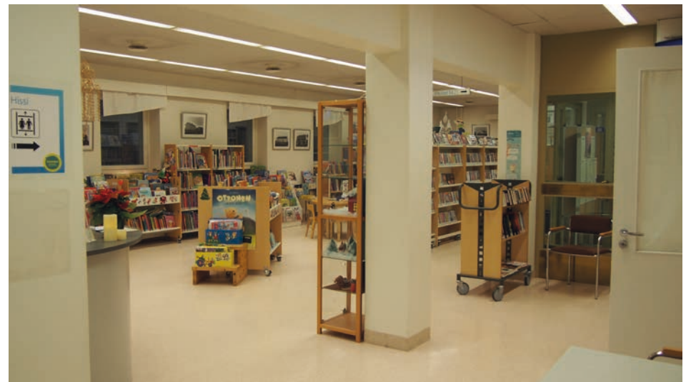
Kuva 83: Paksua primääripalkkia kannatteleva pilaririvistö kulkee kirjaston tilojen läpi. Oikealla työhuoneet, vasemmalla lainaustiski. Edessä oikealla porrashuoneen ikkuna.
