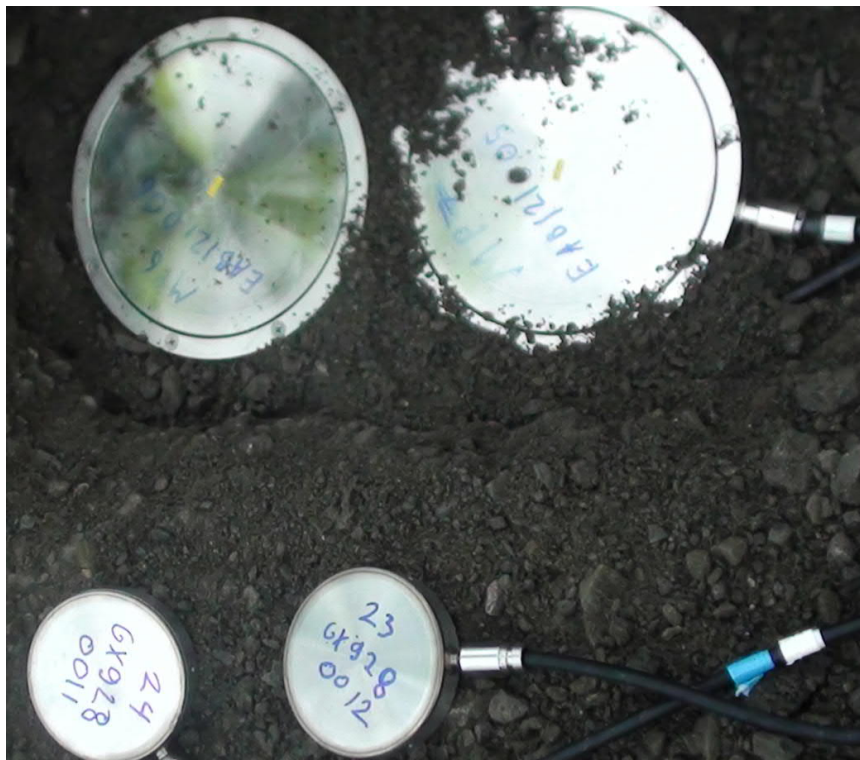
Kuva 22 Pystyjännitysanturien asennusta kohteella PL4900.
