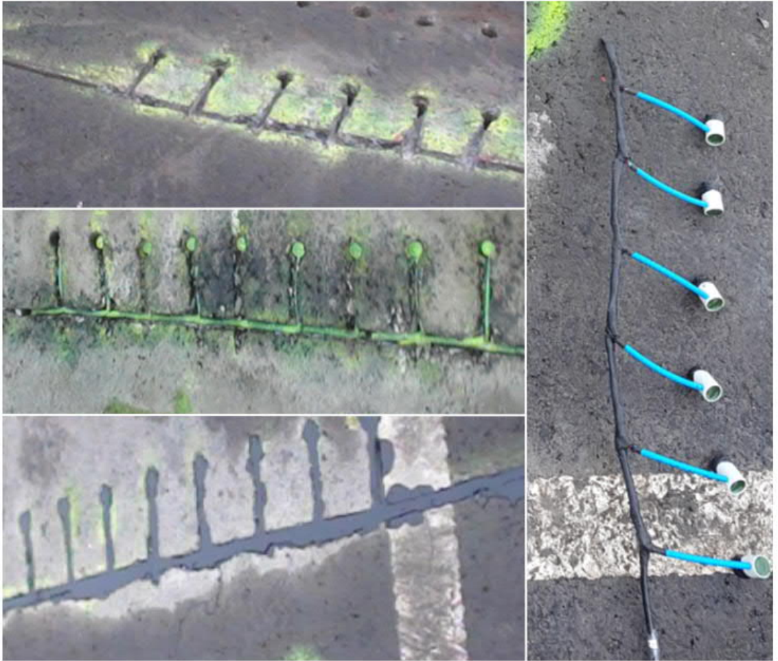
Kuva 26 Kiihtyvyyssanturien asennusta.
