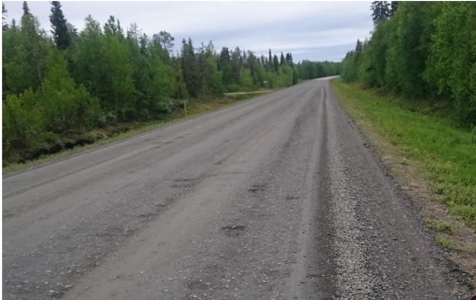
Kuva 18 Mittauskohde PL4900 ennen asfaltin asentamista. (Varin 2017)
