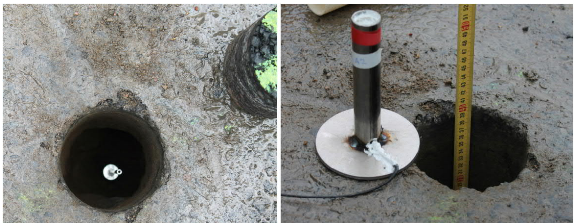
Kuva 24 Tien pinnan pystysiirtymäanturin asennusta. (Vuorimies et al. 2018)
