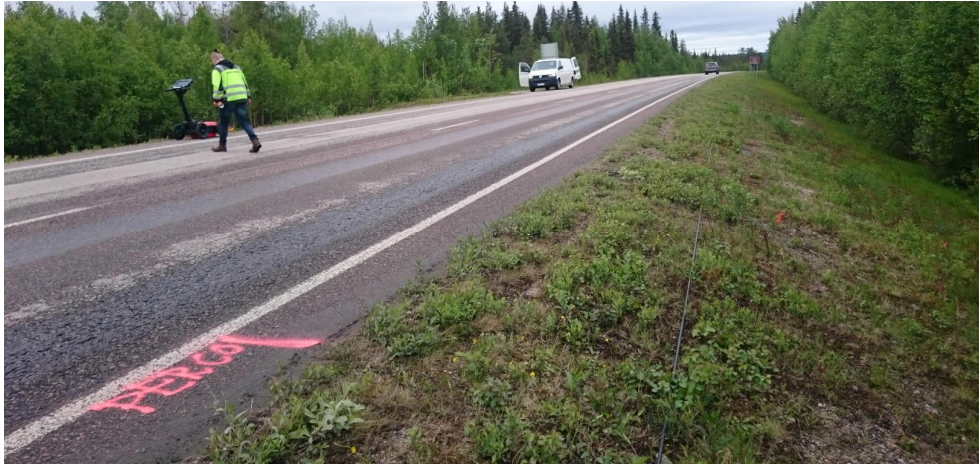
Kuva 20 Mittauskohde PL5700 vanhalla päällysteellä ennen anturien ja uuden päällystekerroksen asennusta. (Varin 2017)
