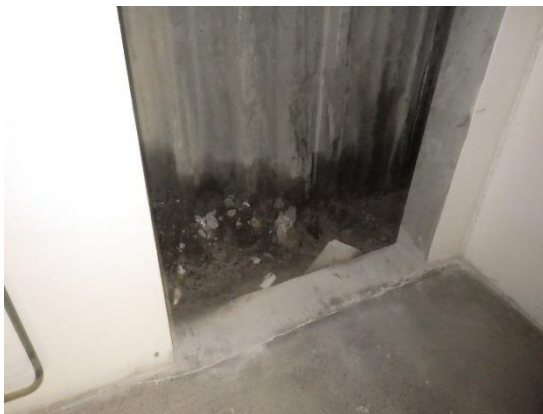
Kuvat 5 a ja b. Louhitusta kalliosta valuva vesi aiheuttaa jatkuvaa kosteusrasitusta sisäpuoliselle betoniseinälle. Kuvat 5 a ja b. on otettu Kuva 4 vastakkaiselta seinältä.
