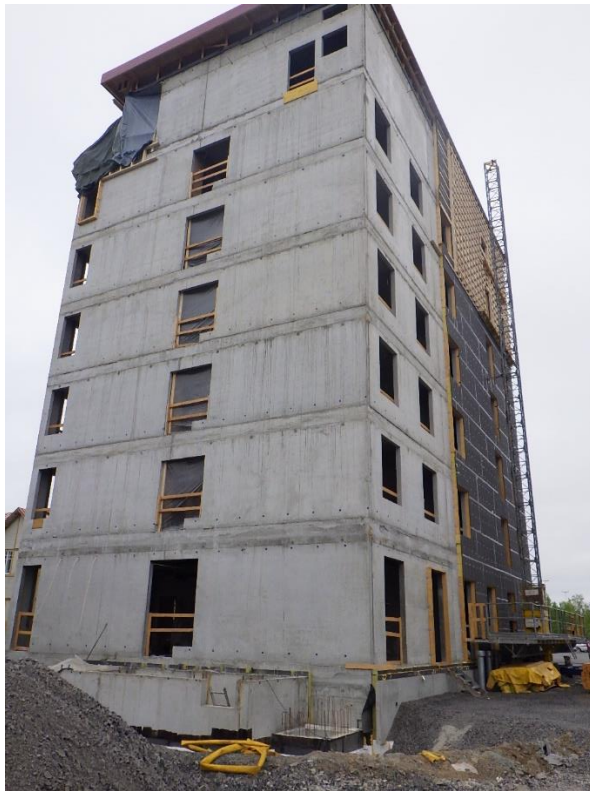
Kuva 1. Yleiskuva rakennuksesta lopullisessa kerroskorkeudessaan. Ulkoseinillä on parhaillaan menossa levyeristystyö.
