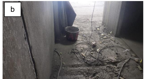
Kuvat 7 a ja b. Ontelolaatastojen vedenpoistoreiät on porattu auki. Kohteessa oli panostettu ontelovesien talteenottoon suurella ämpärimäärällä, joihin kerättiin onteloista tuleva vesi talteen.
