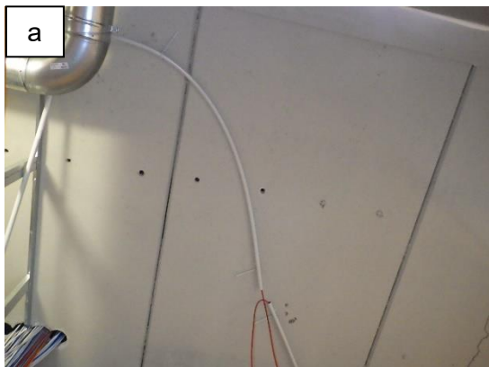
Kuvat 4 a ja b. Ontelolaattojen vedenpoistorei'istä on paikoin tihkunut vielä vettä. Käytävällä alakattotöiden yhteydessä yhdestä ontelosta tuli porauksen yhteydessä vielä 1-2 ämpärillistä vettä.
