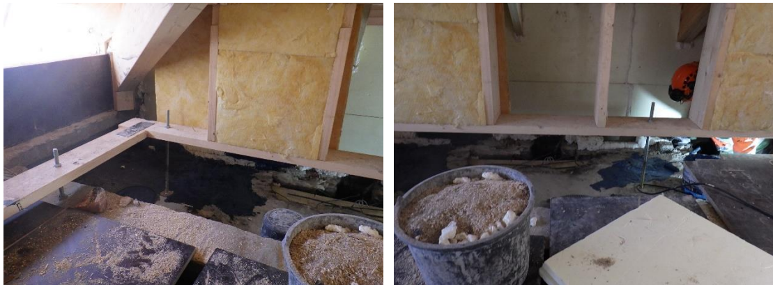
Kuva 7. Yläpohjalle tehtiin katselmuksen aikana vedeneristystöitä. Alustana vanha laatta on erityisen haastava. Työskentelytilat ovat ahtaat ja tilassa on työn laatua heikentävää kivi- ja puupölyä.
