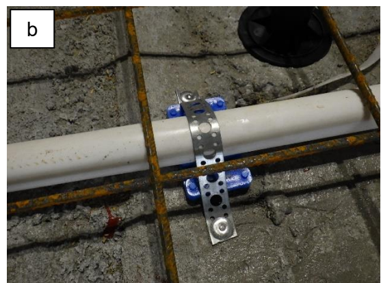
Kuvat 4 a ja b. Viemäriasennukset ovat valmiit ja odottavat valutöitä. Putket on kannakoitu tukevasti alapuoliseen laattaan.
