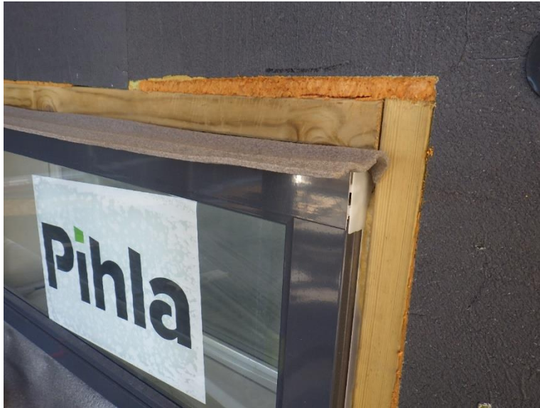
Kuva 2. Ikkunoiden ylä- ja alaosia on suojattu solumuovikaistalla, jotta valuva vesi ei pääsisi rakenteisiin.
