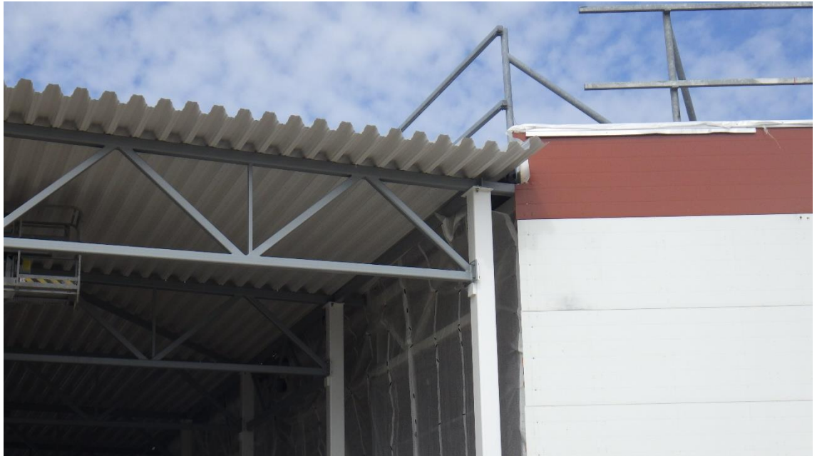
Kuva 2. Rakennuksen vanhan ja uuden osan liittymäkohta. Osalla katon laajennusosasta profiilipellin urat ovat kohtisuoraan alkuperäistä seinäosaa vasten. Suojaaminen näillä katon osilla on tuottanut urakoitsijalle haasteita.
