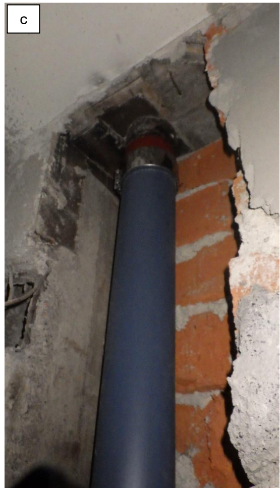
Kuvat 2 a...c. Vanhan lämmitysjärjestelmän paisuntasäiliön kautta oli tapahtunut vesivahingon aiheuttanut vuoto. Kuvassa C säiliön alemman kerroksen viemäriputken liitokset olivat vuodon sattuessa vielä keskeneräiset ja vesi pääsi pystysuuntaisen linjan kautta vuotamaan alla oleviin tiloihin.
