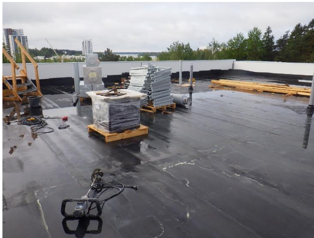
Kuvat 6. Alkuperäisistä suunnitelmista poiketen vesikaton vedeneriste vaihdettiin kermiin, jolla vedenpitävyyttä saatiin lisättyä. Tässä tapauksessa urakoitsija vastasi itse lisäkustannuksista.
