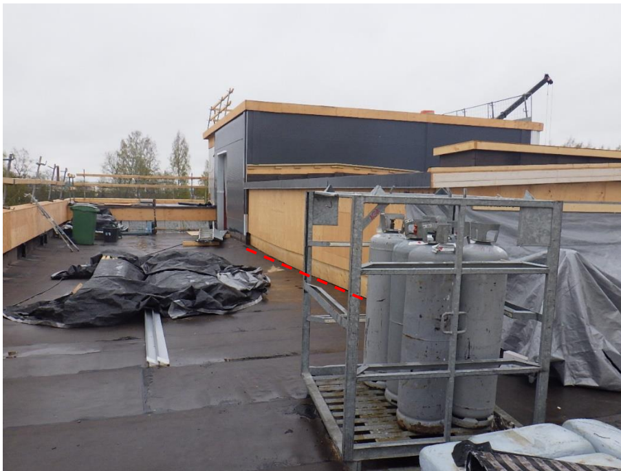
Kuva 6. Keskenräisen seinäosan alareuna pääsee kastumaan. Merkattu kuvaan punaisella katkoviivalla.
