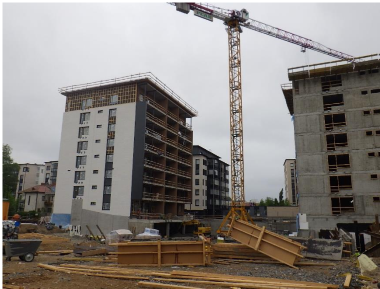
Kuva 1. Kerrostalojen ulkovaipat ovat ummessa. Vesikatolla tehtiin katselmuksen aikana ensimmäisen kermikerroksen asennusta.
