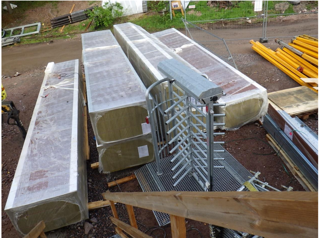
Kuva 2. Ulkoseinäelementit on suojattu kuljetuksen aikaisella suojauksella. Kuljetuksen aikaisessa suojauksessa havaittiin reikiä ja repeämiä.
