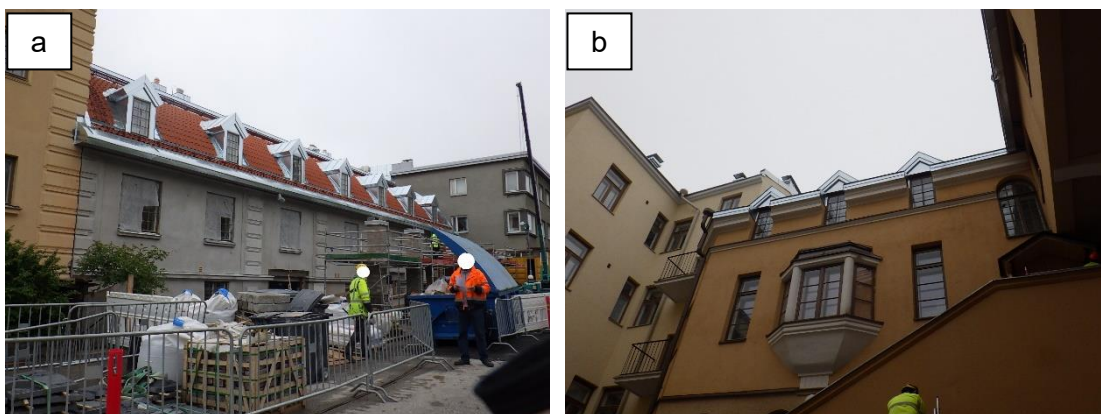
Kuva 1. Rakennus tien puolelta ja sisäpuhulta.
