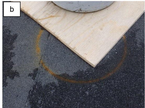
Kuvat 3 a ja b. Kaasupulloa on jossakin vaiheessa säilytetty suoraan kermin päällä. (kuva b) Nyt kaasupullo on asianmukaisesti vanerin päällä.
