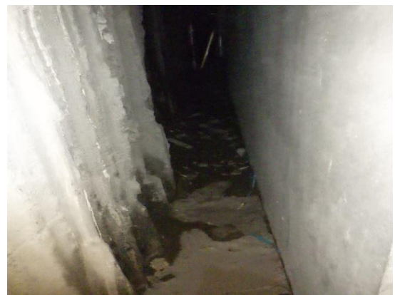
Kuvat 5 a ja b. Louhitusta kalliosta valuva vesi aiheuttaa jatkuvaa kosteusrasitusta sisäpuoliselle betoniseinälle. Kuvat 5 a ja b. on otettu Kuva 4 vastakkaiselta seinältä.
