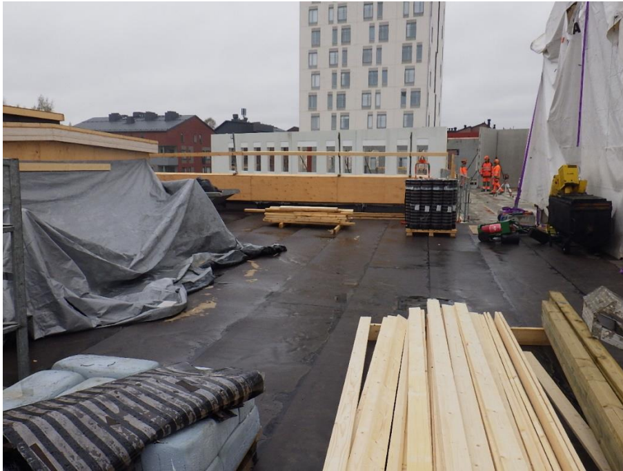
Kuva 5. Vesikattotyöt on toteutettu sääsuojan alla (kuvassa oikealla) siirtämällä sääsuojaa työn etenemisen mukaan. Materiaalien suojuksessa vesikatolla on puutteita.
