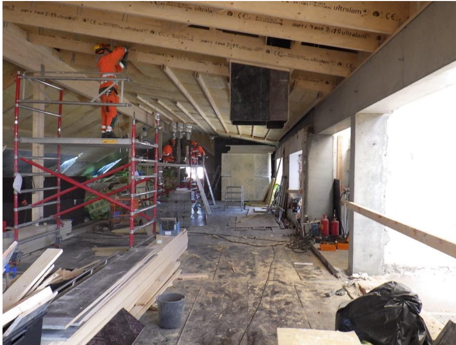
Kuva 6. Yleiskuvaa vesikaton alapuolelta.
