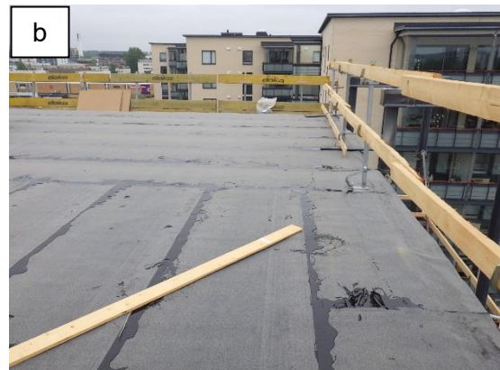
Kuvat 4 a ja b. Vesikaton kermityöt olivat katselmuksen aikaan käynnissä.
