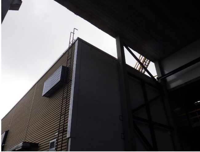
Kuvat 7. Uuden ja vanhan seinän liittymistä ei ole vielä riittäviä suunnitelmia, joissa on huomioitu rakenteen kosteustekninen toimivuus.
