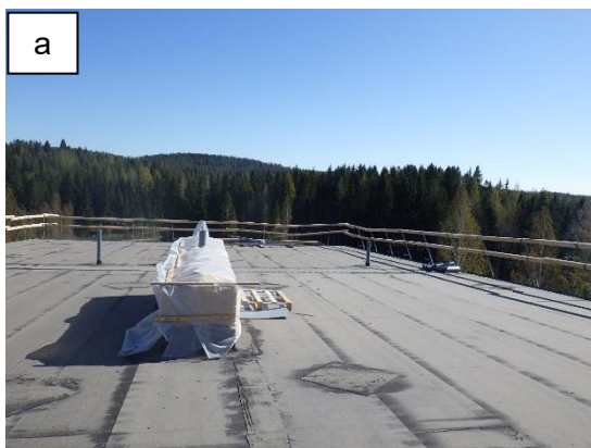
Kuvat 2 a ja b. Vesikatolle on asennettu ensimmäinen kermikerros. Vielä keskeneräisessä ylösnostossa oli lieviä puutteita suojauksessa.
