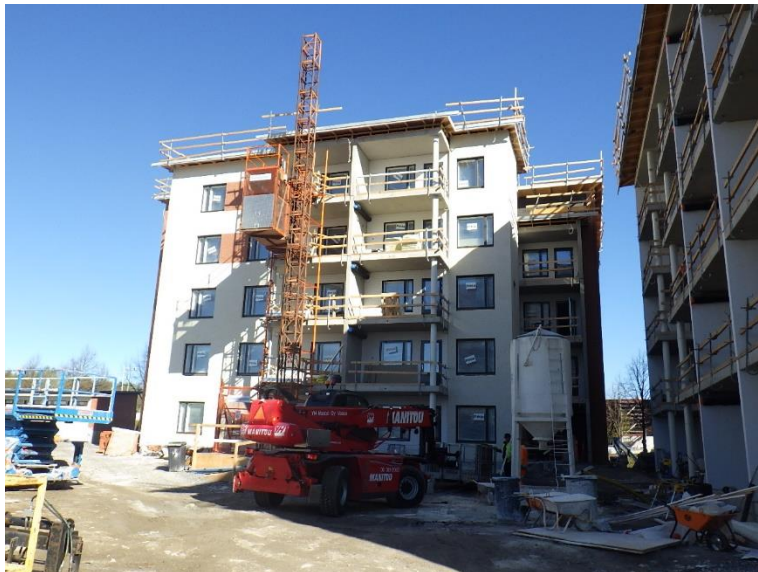
Kuva 1. Kerrostalojen ulkovaipat ovat ummessa. Vesikaton ensimmäinen kermikerros on asennettu. Ylimmässä kerroksessa tehdään julkisivun levytystöitä.
