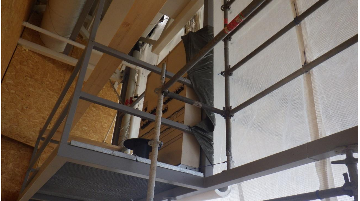
Kuva 4. Vanhan rakennusosan sähkökaappi sijaitsee puretun seinän osalla suojaseinämän välittömässä läheisyydessä. Sähkökaappia on suojaseinän lisäksi pyritty suojaamaan pressulla.
