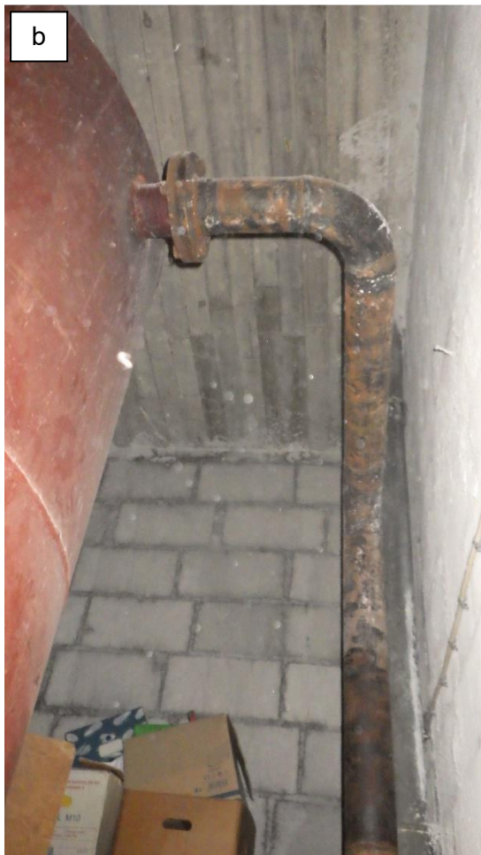
Kuvat 2 a...c. Vanhan lämmitysjärjestelmän paisuntasäiliön kautta oli tapahtunut vesivahingon aiheuttanut vuoto. Kuvassa C säiliön alemman kerroksen viemäriputken liitokset olivat vuodon sattuessa vielä keskeneräiset ja vesi pääsi pystysuuntaisen linjan kautta vuotamaan alla oleviin tiloihin.
