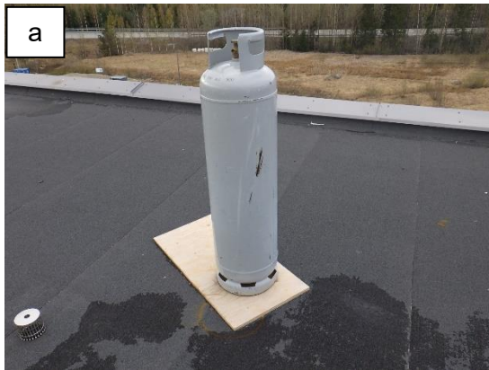
Kuvat 3 a ja b. Kaasupulloa on jossakin vaiheessa säilytetty suoraan kermin päällä. (kuva b) Nyt kaasupullo on asianmukaisesti vanerin päällä.
