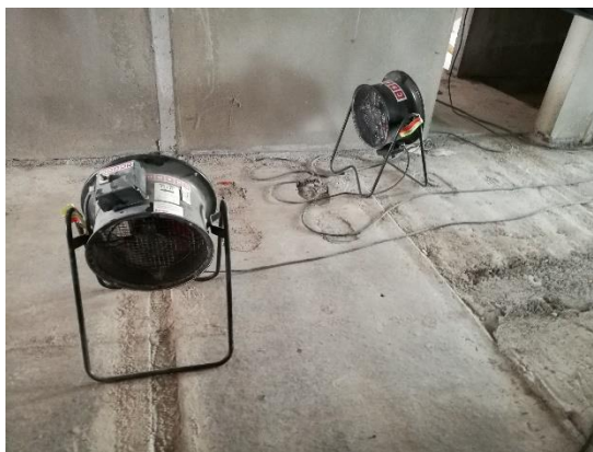
Kuva 8. Yhdessä huoneistossa oli kuivumisen nopeuttamiseksi käytössä kanavapuhaltimia.
