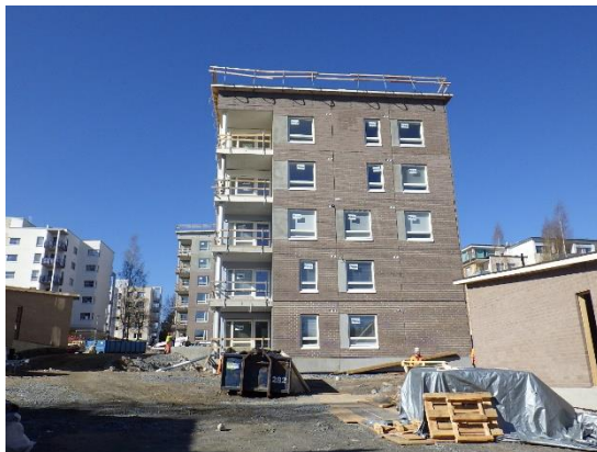
Kuvat 1 a ja b. Kummankin kerrostalon ulkovaippa on ummessa ja vesikatto on saatu vedenpitäväksi.
