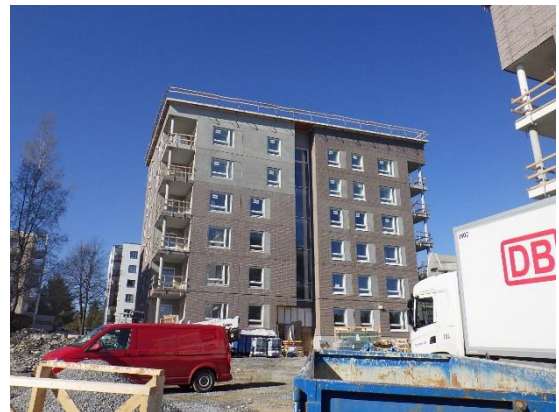
Kuvat 1 a ja b. Kummankin kerrostalon ulkovaippa on ummessa ja vesikatto on saatu vedenpitäväksi.
