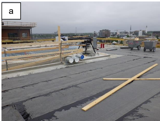
Kuvat 4 a ja b. Vesikaton kermityöt olivat katselmuksen aikaan käynnissä.
