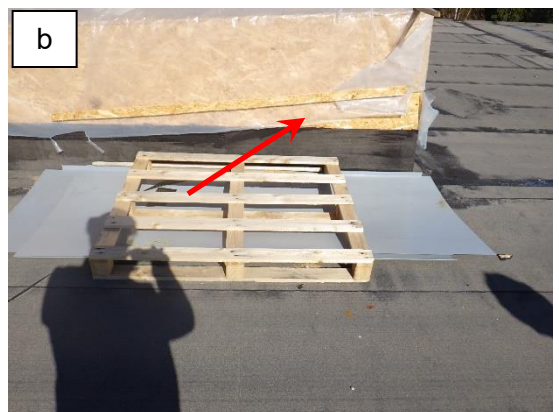
Kuvat 2 a ja b. Vesikatolle on asennettu ensimmäinen kermikerros. Vielä keskeneräisessä ylösnostossa oli lieviä puutteita suojauksessa.
