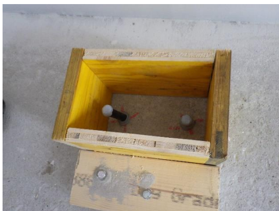
Kuva 4. Kosteusmittaukset on toteutettu porareikämenetelmällä. Mittauspisteet on suojattu valun pultatulla puisella kehyksellä, jotta mittausputkia ei epähuomiossa vaurioiteta.
