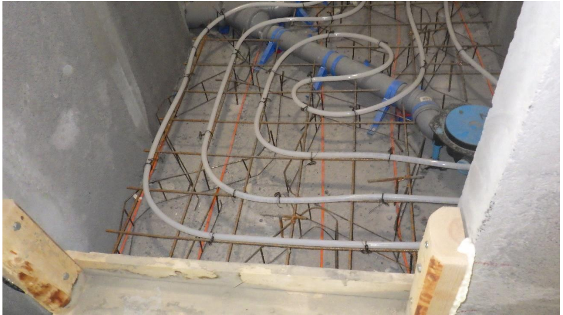
Kuva 6. Märkätilojen valujen kuivumista on pyritty varmistamaan lisäämällä valuihin lämmityslangat, joilla tarvittaessa voidaan nopeuttaa valun kuivumista.
