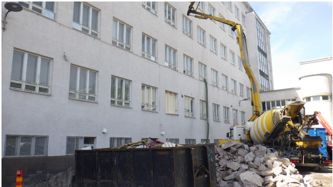
Kuva 1. Yleiskuva rakennuksesta sisäpihan puolelta.
