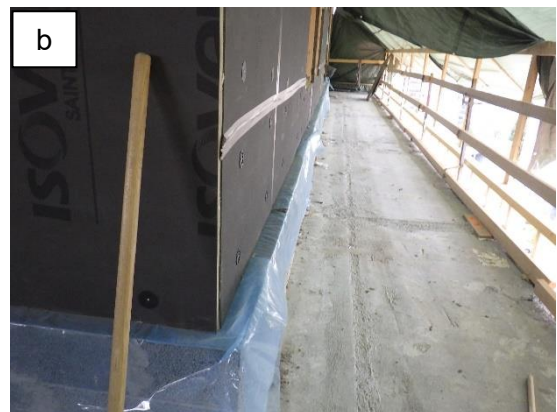
Kuvat 3 a ja b. Räystäästä ulkoneva parvekerakenne on suojattu työnaikaisesti puurimoista ja pressusta tehdyllä sääsuojalla. Sääsuoja on tähän asti kestänyt hyvin ja pitänyt sadeveden parvekkeen ulkopuolella. Höyrinsulkukalvon liitetty kevytrankaisen seinän alajuoksupuun alle.
