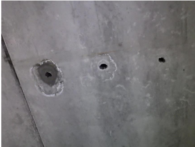
Kuva 2. Ontololaattojen vedenpoistoreiät on saatu porattua auki ja onteloiden kuivatus on käynnissä. Paikoittain onteloista on vielä havaittavissa ulos tulevaa kosteutta.
