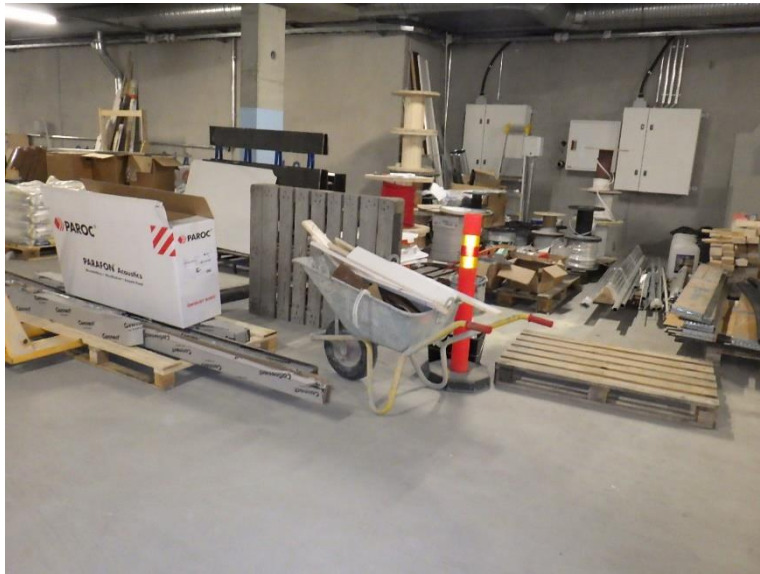
Kuva 1. Varastointitilana on käytetty parkkihallia, jossa helposti kosteusvaurioituvat materiaalit on saatu pidettyä kuivana.
