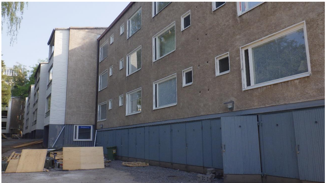
Kuva 1. Yleiskuva työmaasta rakennuksen ulkoa käsin.
