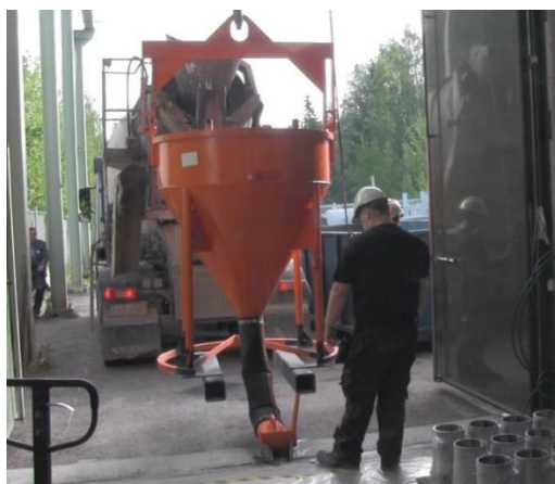
Kuva 3. Betonin nostoastia eli ”jassikka”, johon betoni lasketaan kuljetusautosta.
