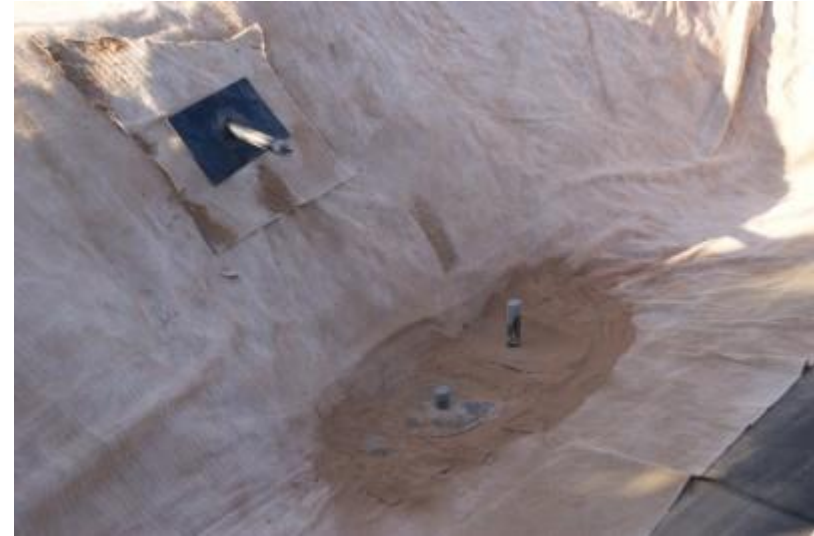
DSC04467 Tiivistetyt läpiviennit
