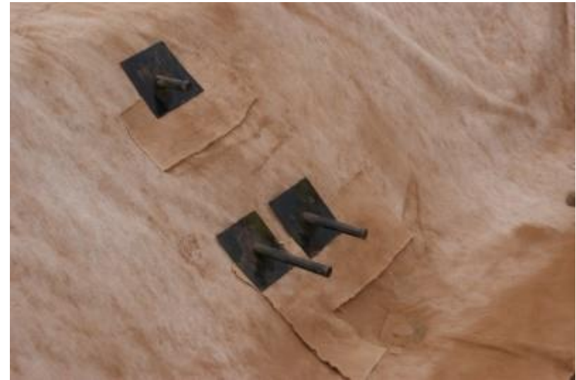
DSC04900 Läpivientien kaulukset
