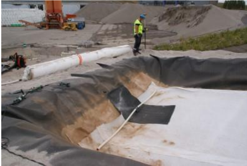
DSC04664 Pintakerroksen vedet kaivoon keräävä salaojaputki
