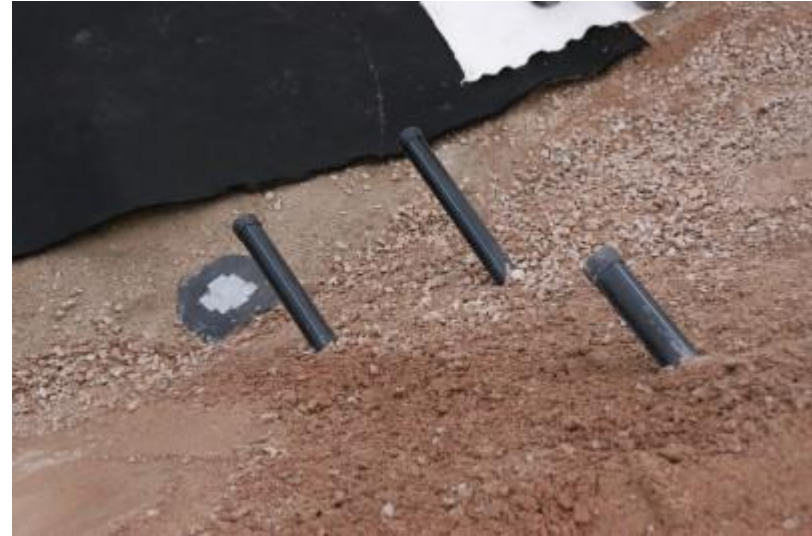
DSC04877 Valmiit putket ja pohjan läpivienti
