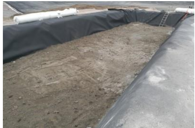
134848 Valmis koepintarakenne 5.9.2018 (Vahnen 2018)
