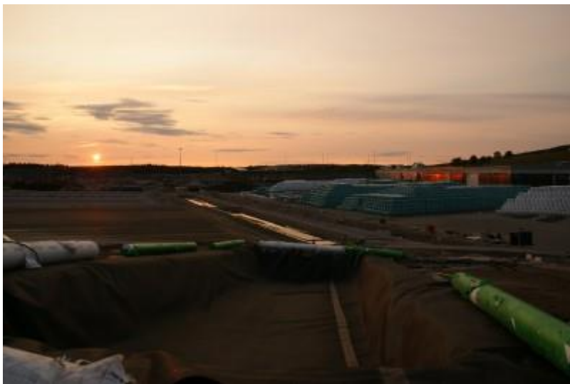
DSC04993 Pohjakalvon väliaikainen tuenta
