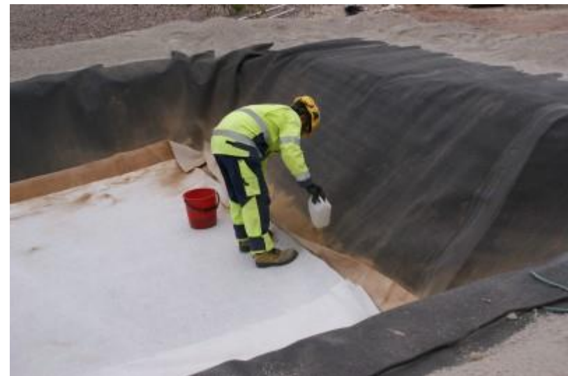
DSC04663 Bentoniittimaton reunojen tiivistäminen bentoniitilla
