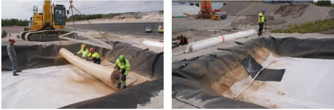
Kuva 35. Vasemmalla bentoniittimatton levittäminen ja oikealla pintakerroksen vedet keräävä salaojaputki (Reiman 2018).
