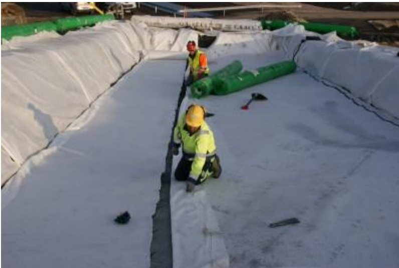
DSC05089 Salaojamaton ytimien kiinnittäminen toisiinsa
