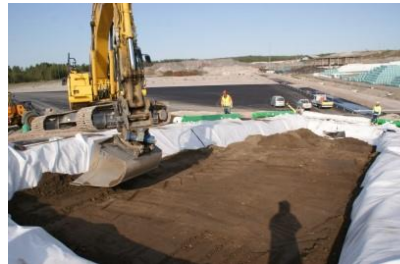
DSC05104 Pintakerroksen tiivistäminen kauhalla painelemalla
