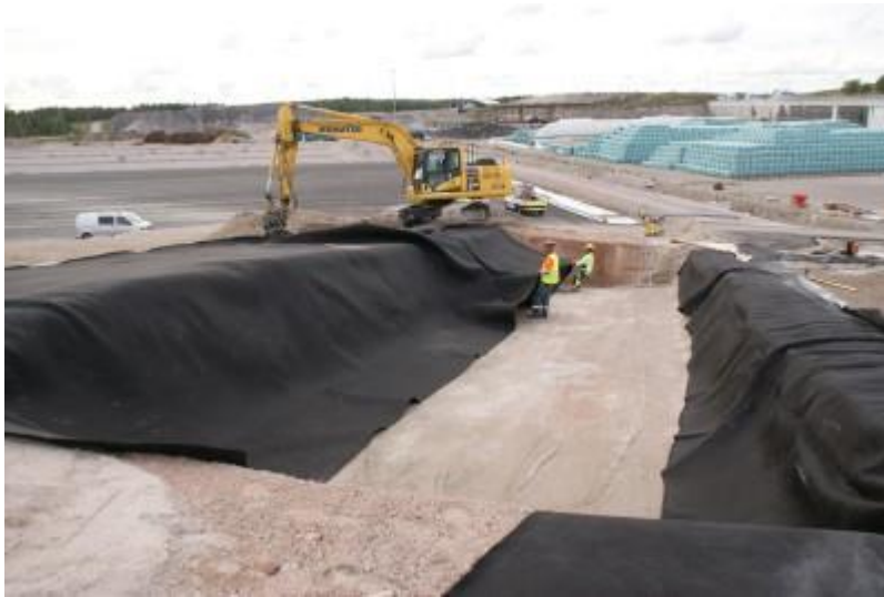
DSC04845 Suojageotekstiilin levittäminen kentän pohjalla
