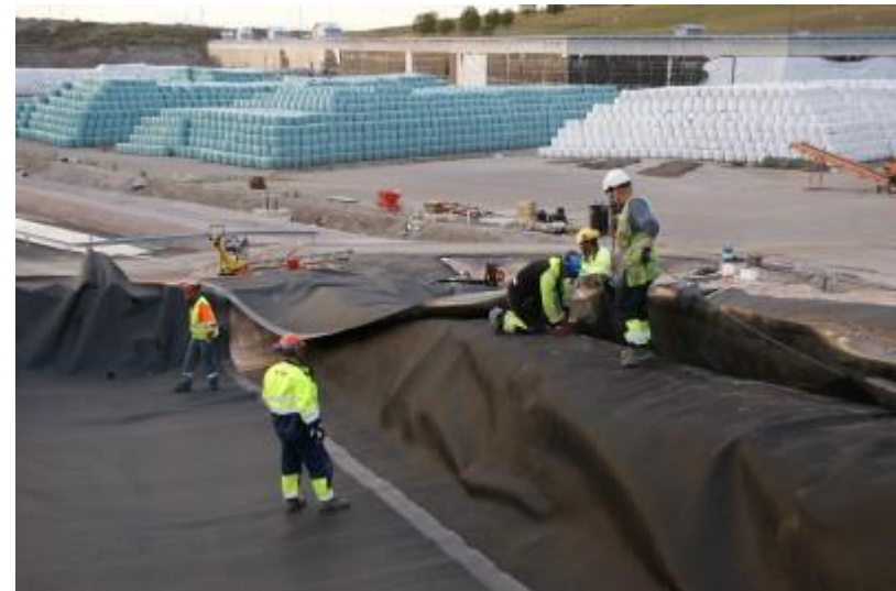
DSC04940 Suojageotekstiilien kiinnittäminen toisiinsa
