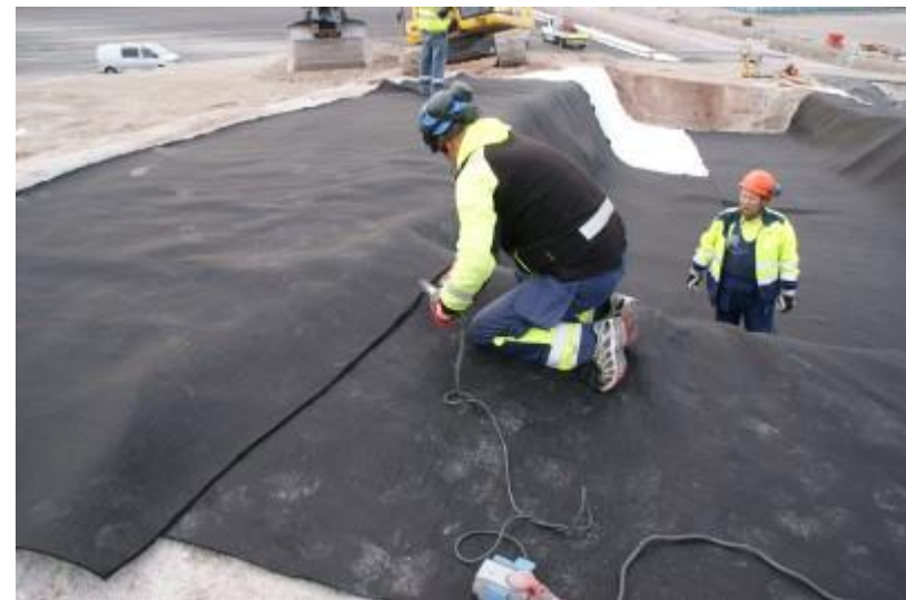
DSC04872 Suojageotekstiilin nurkan muotoileminen
