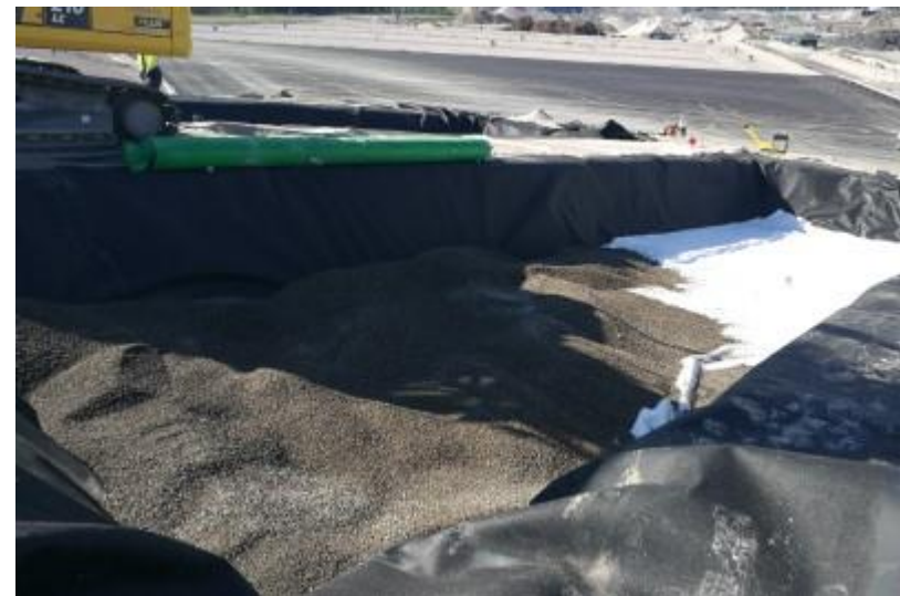
141923 Kapillaarikatkon kuonan levittäminen (Vahanen 2018)
