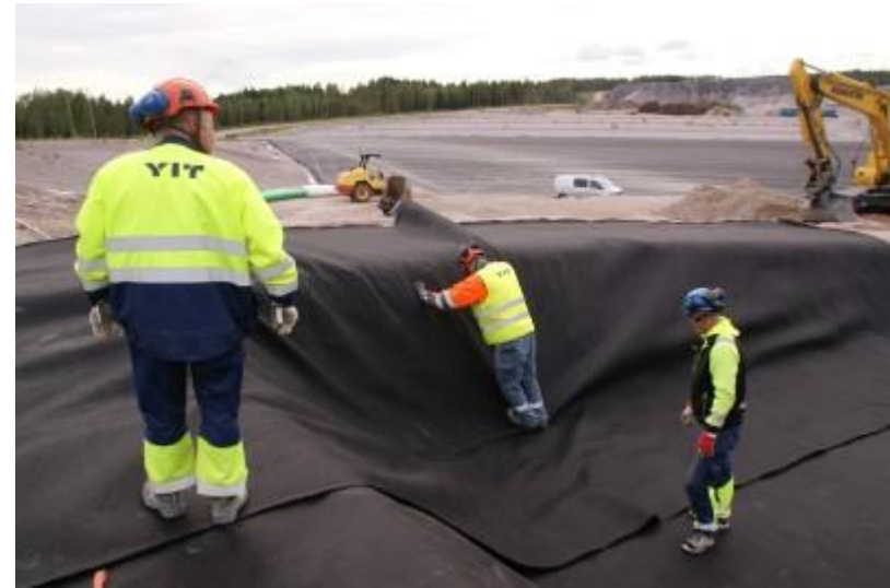
DSC04864 Suojageotekstiilin asetteleminen
