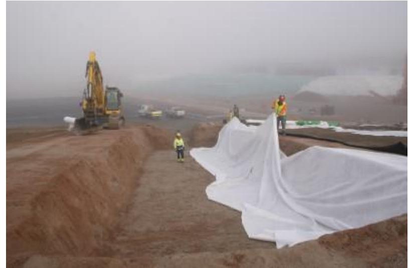
DSC05129 Suodatinkankaan levittäminen suojageotekstiilin sijasta
