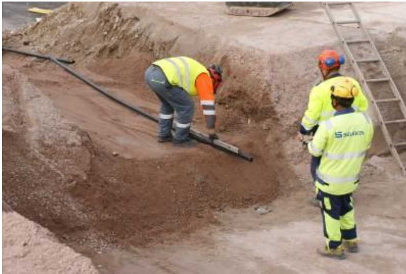
DSC04831 Putkien asentaminen tiivistetylle pohjalle
