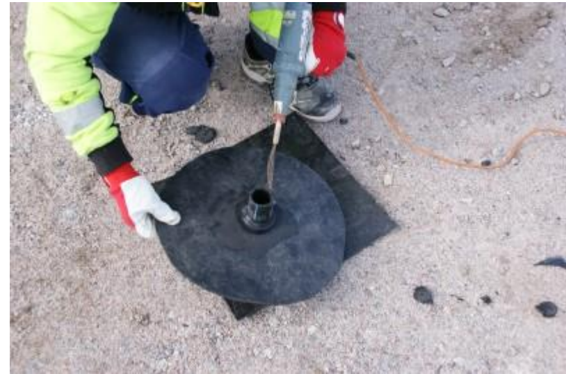
DSC04358 Läpivientielementin valmistus – kipinätesti
