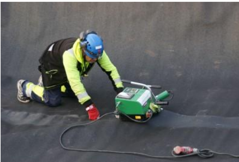
DSC04960 Pohjakalvon kaksoissaumaus
