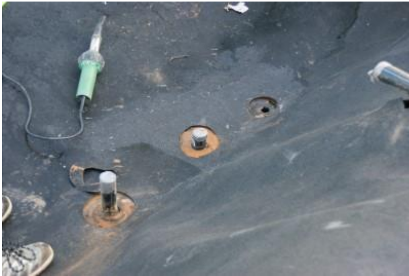
DSC04480 Lämpiviennit ennen saumausta
