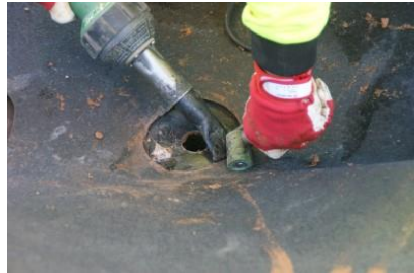
DSC04482 Pohjakalvon kiinnittäminen läpivientiin
