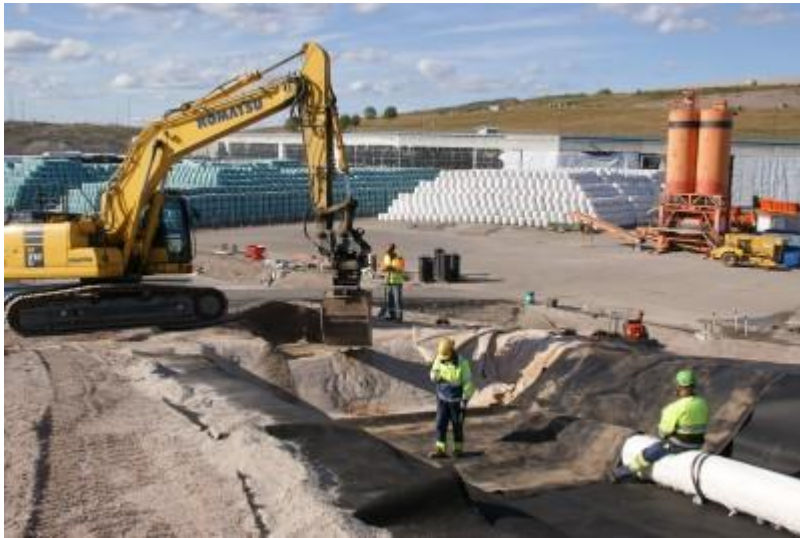
DSC04442 päädyn avaaminen uudestaan (1 läpivienti puuttui)
