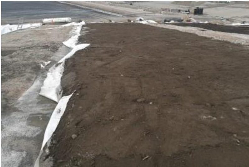
115410 Valmis pintakerros Helsinki-moreenista 10.9.2018 (Vahnen 2018)
