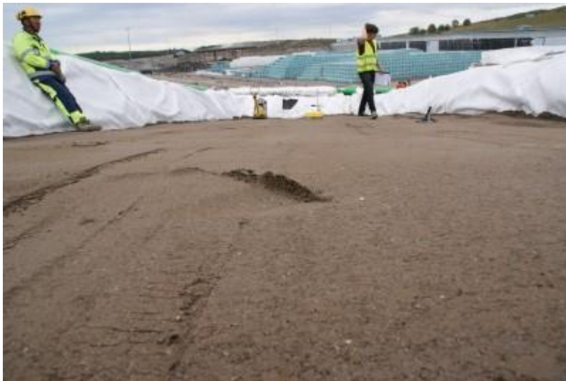
DSC05079 Kuonabentoniitin valmis pinta ja troxler-mittaus
