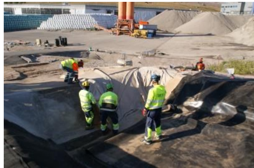
DSC04456 Päädyn bentoniittimaton uudelleen levitys
