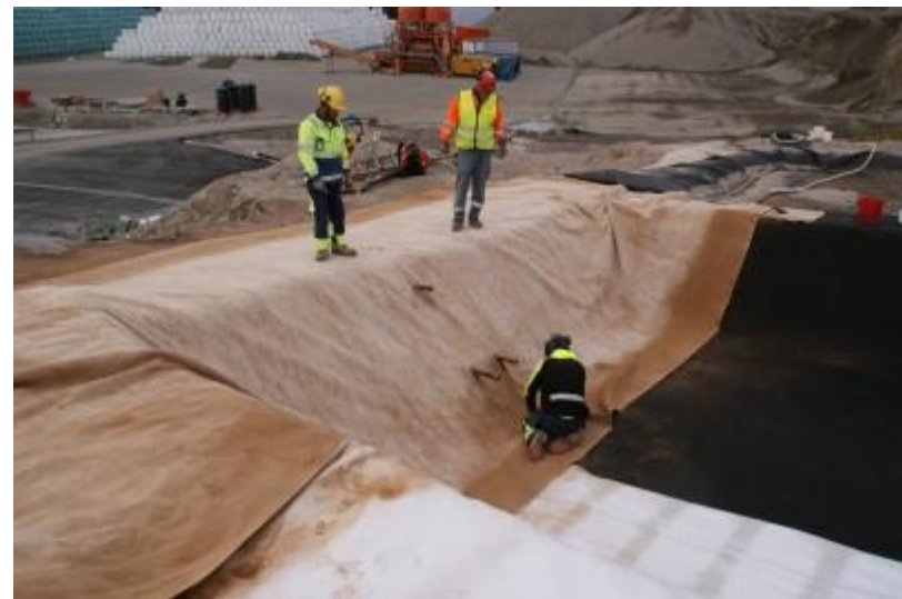
DSC04891 Läpivientien tekeminen bentoniittimattoon
