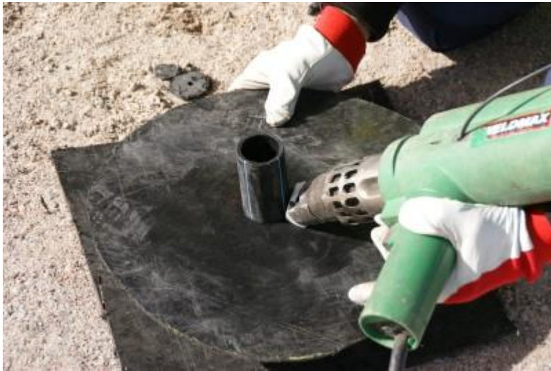
DSC04349 Läpivientielementin valmistus – ekstruusiosausaus
