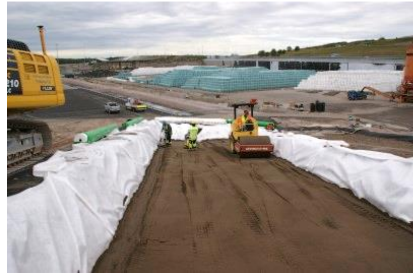
DSC05069 Reunojen ja keskiosan tiivistäminen
