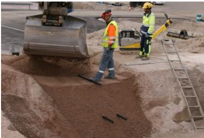
DSC04834 Putkien asentaminen
