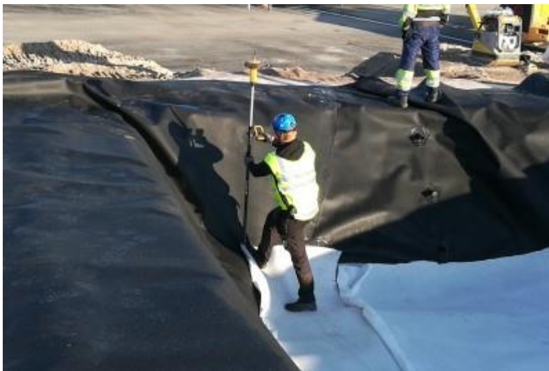
083236 Tarkkailukerroksen salaojamatton tarkemittaus (Vahanen 2018)
