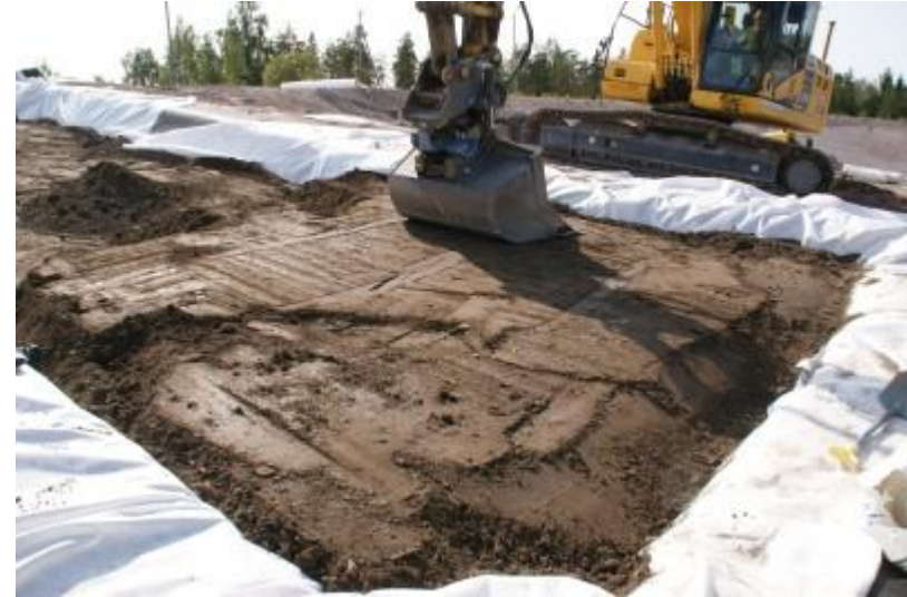
DSC05109 Pintakerroksen tiivistäminen
