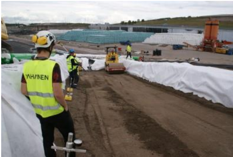
DSC05050 Kuonabentoniitin koetiivistys, 2. jyräys
