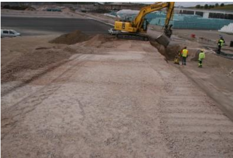
DSC04815 Valmiin välipenkereen pinta
