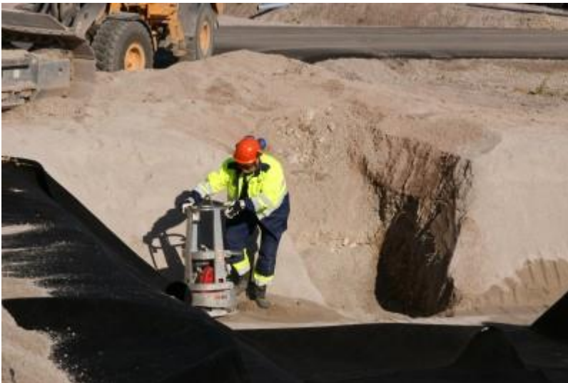
DCS04338 Pohjan tiivistäminen
