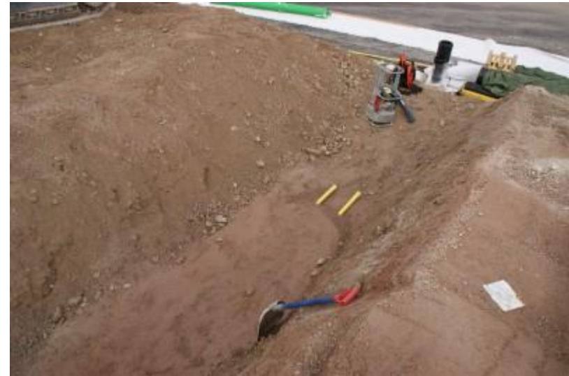
DSC05146 Läpivientien putket
