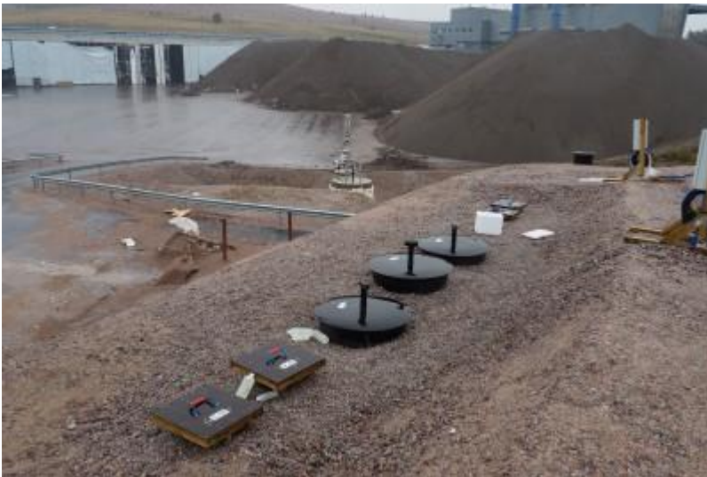
P4091331 Koepintarakenteiden A.1 ja A.2 kaivot 9.4.2019 (Reiman 2019)
