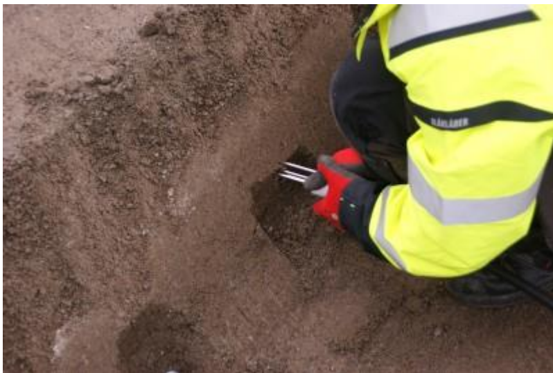
DSC05072 Yhdistelmäanturin asentaminen kuonabentoniittiin
