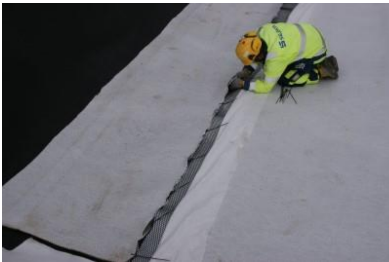
DSC05019 Salaojamaton ytimien kiinnittäminen nippusiteillä
