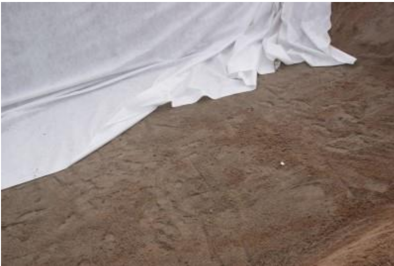
DSC05131 Altaan valmis pohja
