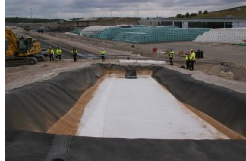
DSC04666 Kuivatuskerroksen salaojamatto bentoniittimaton päällä
