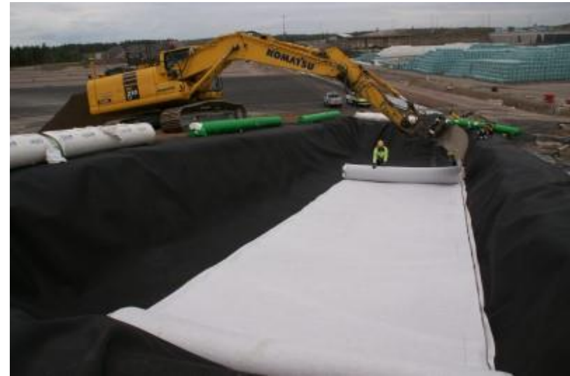
DSC05015 Tarkastelukerroksen salaojamaton levitys
