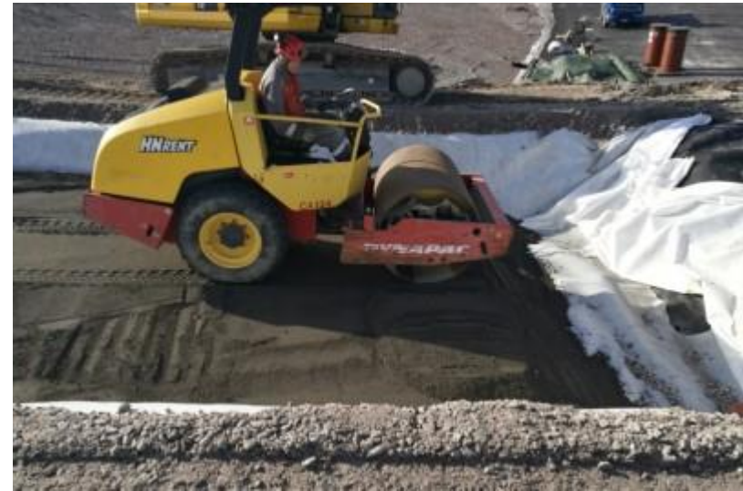
122012 Bitumikuonan tiivistäminen jyrällä. Luiskan alapää täyttämättä antureiden asentamista varten (Vahanen 2018)
