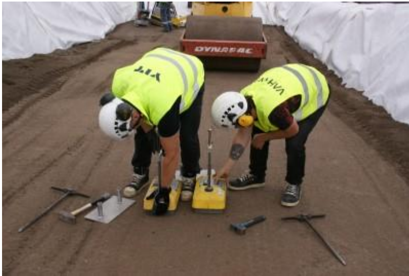
DSC05059 3. jyräyksen jälkeinen troxler-mittaus
