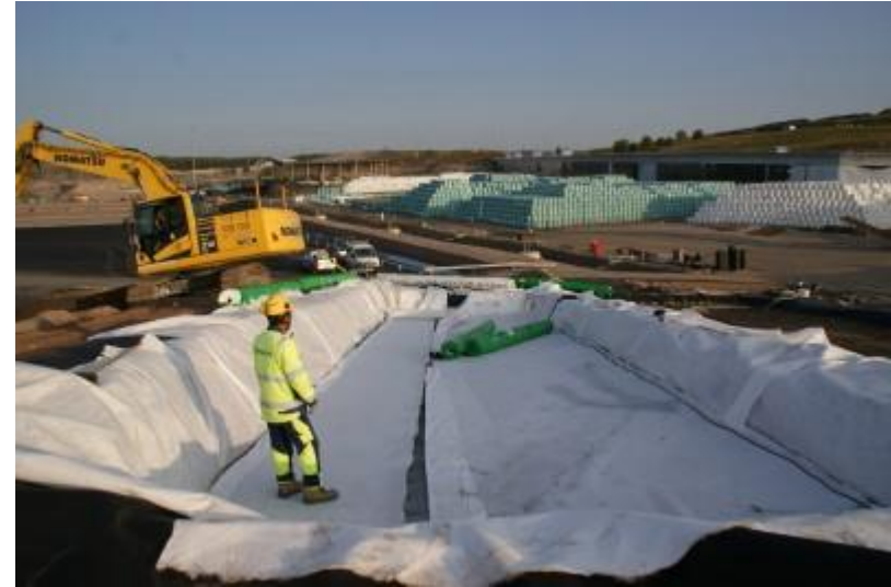
DSC05088 Oikean levyinen salaojamatto (29.8.2018)
