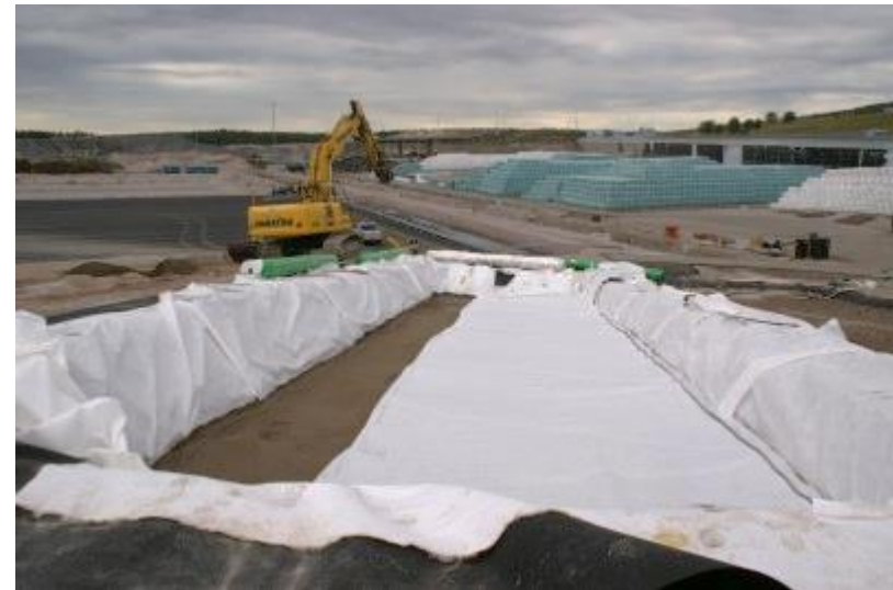
DSC05082 Kuivatuskerroksen salaojamaton levittäminen
