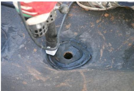
Kuva 34. Vasemmalla läpiviennin ekstruusiosausaus ja oikealla kuorintakoe kaksoissaumasta (Reiman 2018).
