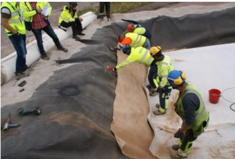
DSC04558 Bentoniittimattokaistaleen asentaminen päättyyn
