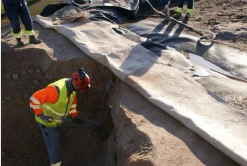
DSC04761 Penkan avaaminen putkien jatkamiseksi
