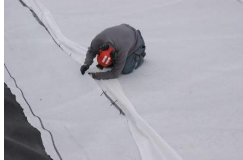
DSC04617 Salaojamattojen ytimien kiinnittäminen nippusiteillä
