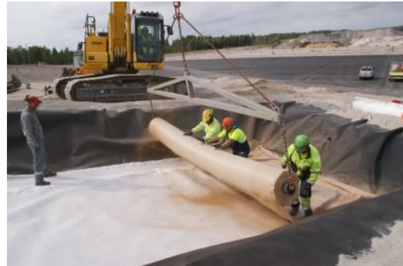
DSC04643 Bentoniittimaton levittäminen
