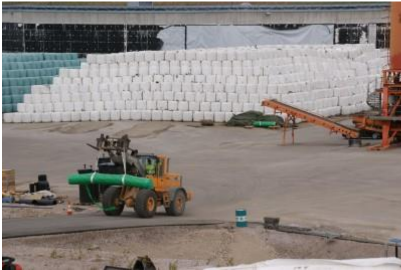
DSC04629 Bentoniittimatto matkalla varastokasalta työmaalle
