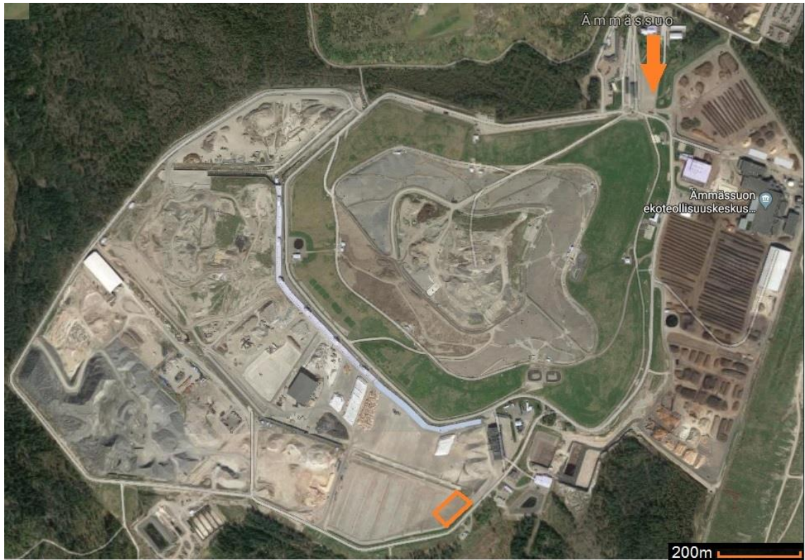
Kuva 28. Ämmässuon ekoteollisuuskeskuksen sääaseman sijainti. Sääasema on merkitty kuvaan oranssilla nuolella. Koerakenteiden sijainti on rajattu oranssilla viivalla.
