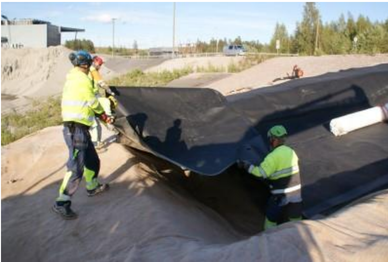
DSC04473 Pohjakalvo levitetään uudelleen
