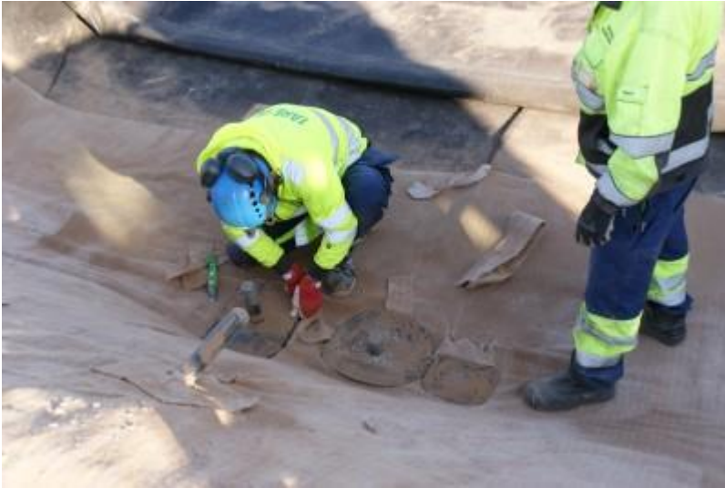
DSC04462 Läpivientien tiivistäminen uudelleen
