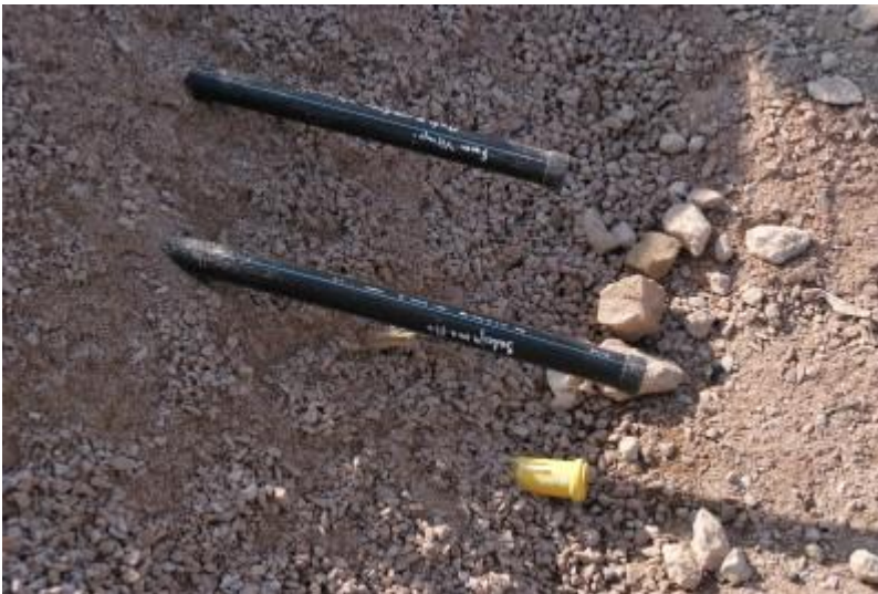
DSC05110 Läpivientien putket
