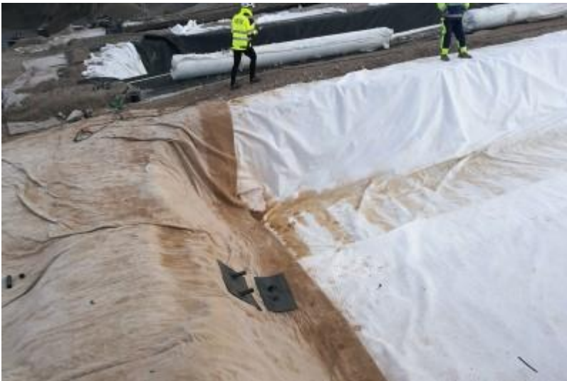
123158 Päädyn bentoniittimatto ja läpiviennit (Vahanen 2018)
