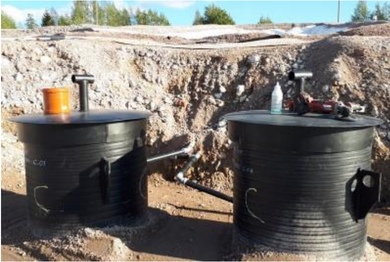
161932 Koekentän kaivot 19.9.2018 (Leppänen 2018)
