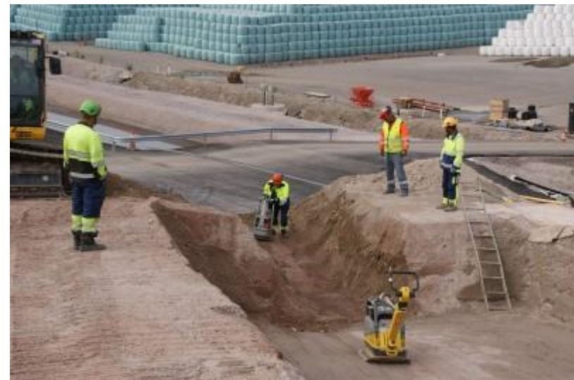
DSC04824 Putkikaivannon tiivistäminen
