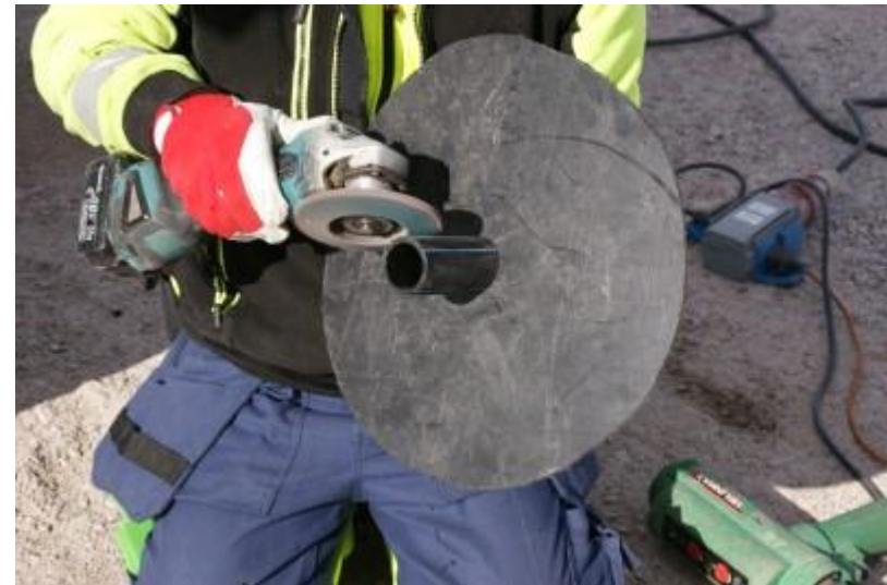
DSC04347 Läpivientielementin valmistus – hionta ennen saumausta
