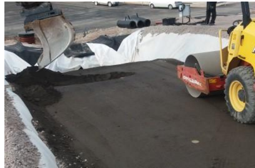
151806 Rakenteen avaaminen antureita varten (Leppänen 2018)
