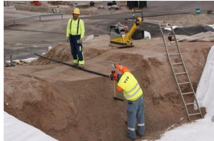
DSC05158 Putkien etäisyyden tarkistaminen
