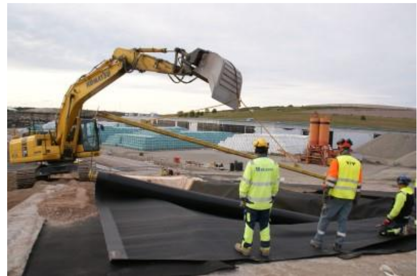
DSC04914 Pohjakalvon levittäminen
