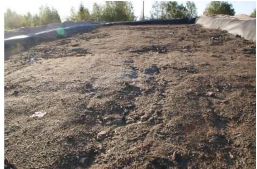
DSC04753 Valmiin pintakerroksen pinta sateen jälkeen
