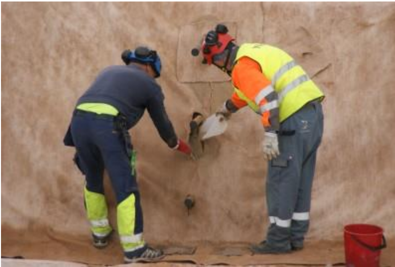
DSC05167 Lävivientien tiivistäminen bentoniittimattokaistaleilla ja -jauheella
