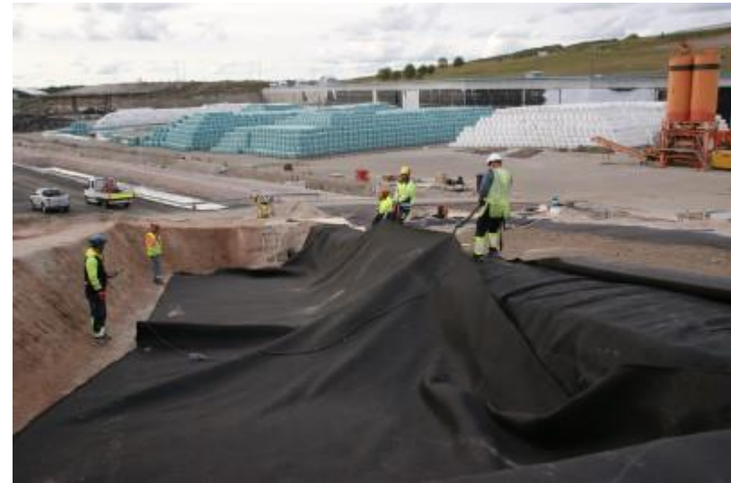
DSC0450 Suojageotekstiilin levittäminen
