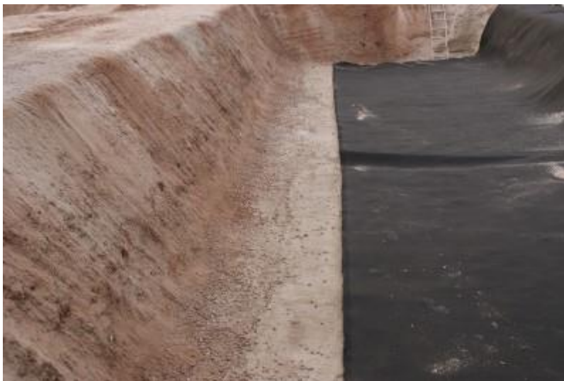
DSC04855 Luiska ja pohja geotekstiilin levittäminen jälkeen
