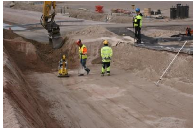
DSC04814 Kaivanto kaivoihin meneville putkille
