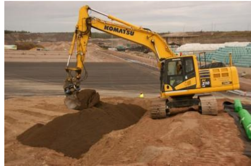
DSC04998 Kuonabentoniitin varastokasa työmaalla
