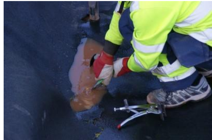
DSC04476 Pohjimmaisena läpiviennin avaaminen saumauksen ajaksi
