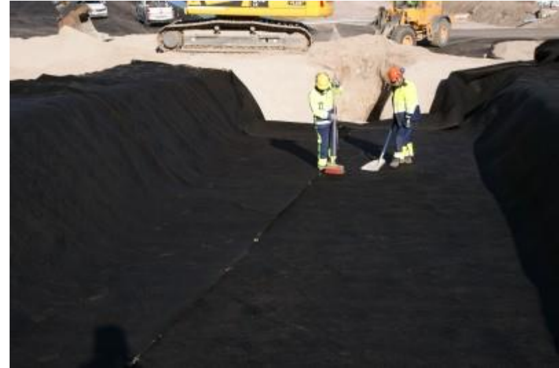
DSC04322 Kalvon alle tulevan suojageotekstiilin putsaaminen
