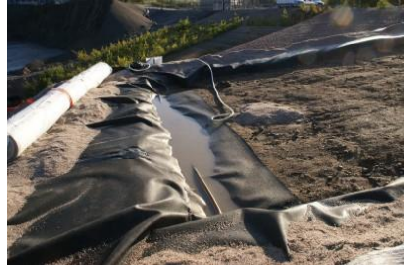
DSC04747 Painunut nurkka viikonlopun jälkeen (27.8.2018)
