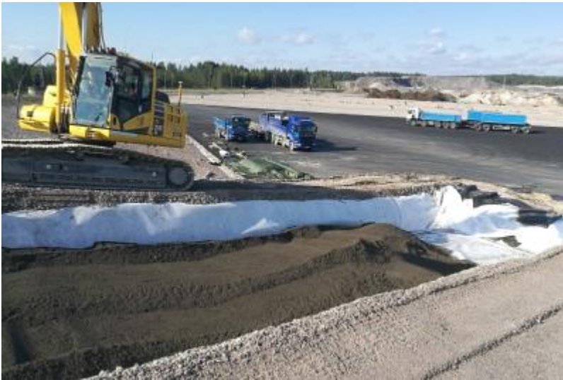
115433 Bitumikuonan levittäminen 19.9.2018 (Vahanen 2018)
