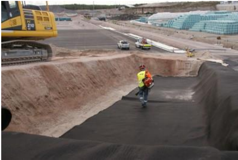
DSC04861 Suojageotekstiilin puhdistaminen
