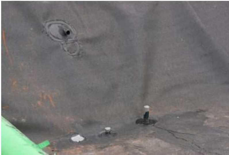
DSC04531 Valmiit läpiviennit seuraavana päivänä (23.8.2018)
