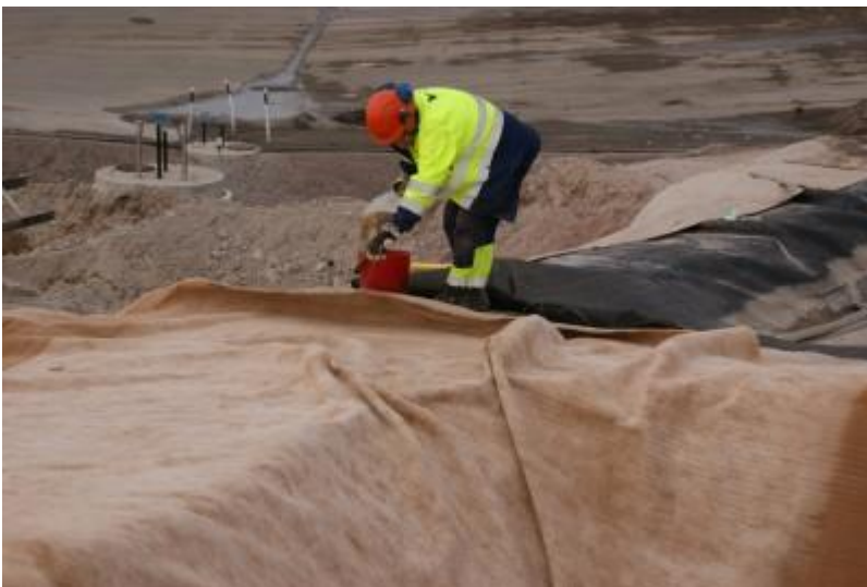
DSC04902 Bentoniittimatton reunojen tiivistäminen bentoniittijauheella
