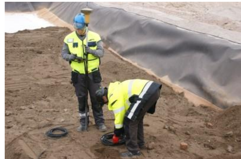
DSC04680 Anturin asentaminen ja anturin tarkemittaus
