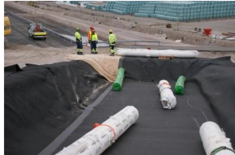
DSC04533 Työmaa edellisen päivän jäljiltä
