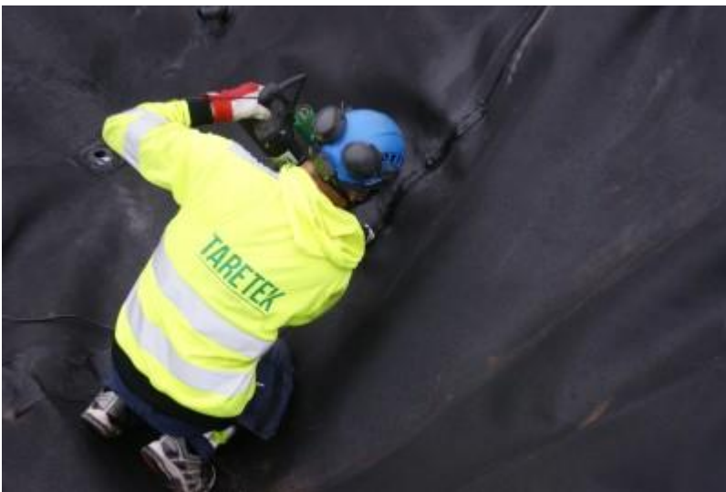
DSC05007 Kaksoissauman paikkaaminen ekstruusiosaumauksella päädyssä
