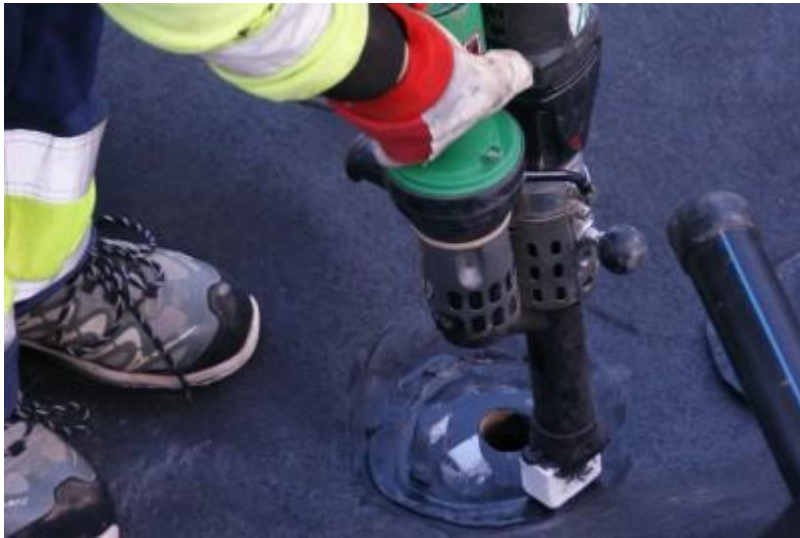
DSC04982 Pohjan läpiviennin ekstruusiosausaus
