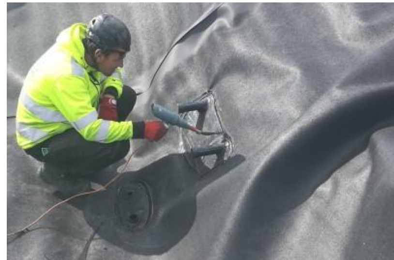
135810 Läpiviennin kipinäkoe 13.9.2018 (Vahanen 2018)
