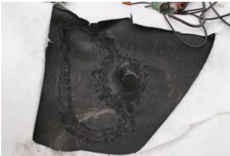
DSC05056 Läpivienti ja sen viereinen paikkaus, kuparilangan asennus
