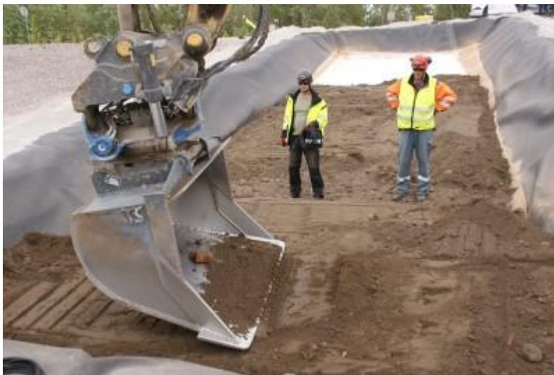
DSC04679 Pintakerroksen Hki-moreenin tiivistäminen kauhalla painelemalla
