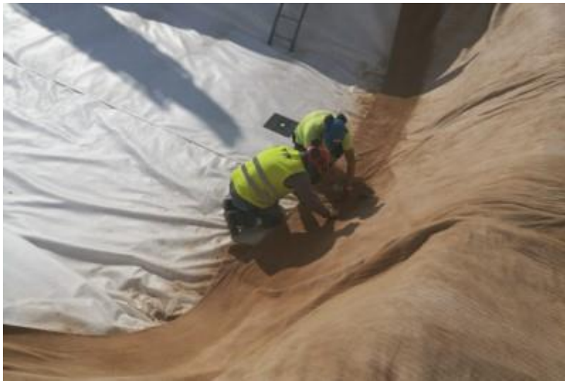
125800 Läpivientien saaminen päädyn bentoniittimaton läpi (Vahanen 2018)
