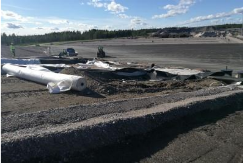
152157 Pintakerroksen ja kuivatuskerroksen välisen salaojamaton vaihtaminen suodatinkankaaseen 13.9.2018 (Vahnen 2018)
