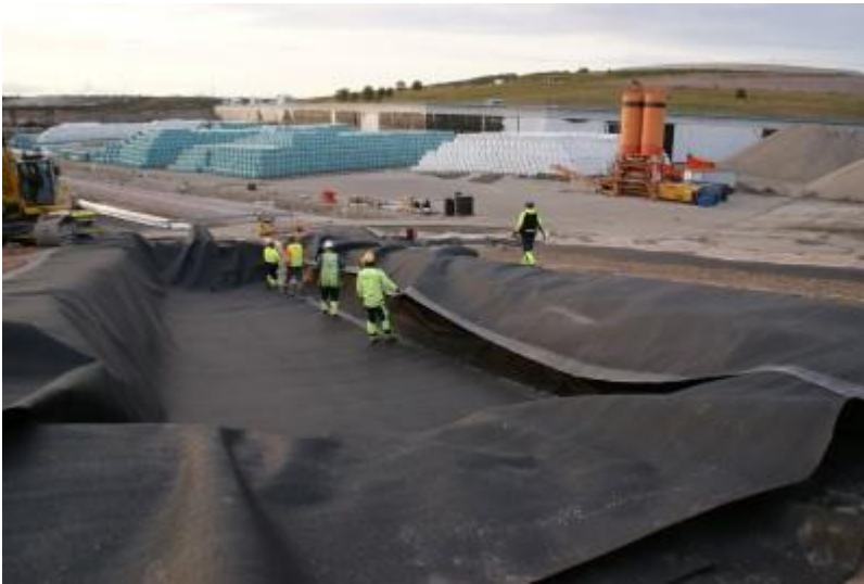
DSC04943 Pohjakalvon levittäminen
