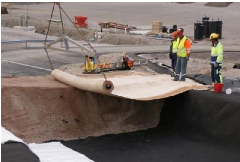
DSC04881 Bentoniittimaton levittäminen päättyyn
