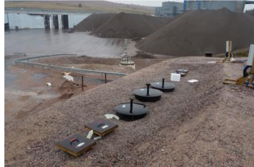
P4091331 Koepintarakenteiden A.1 ja A.2 kaivot (Reiman 2019)
