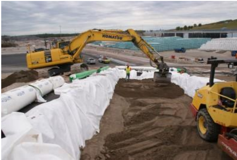
DSC05068 Kuonabentoniitin levittäminen lopulliseen kerrospaksuuteen
