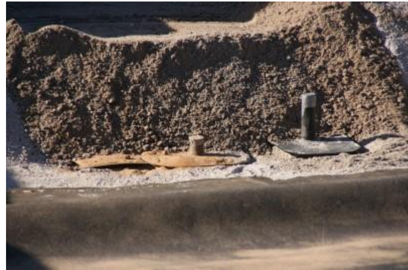
DSC04446 Kolmas läpivienti lisätty pohjalle
