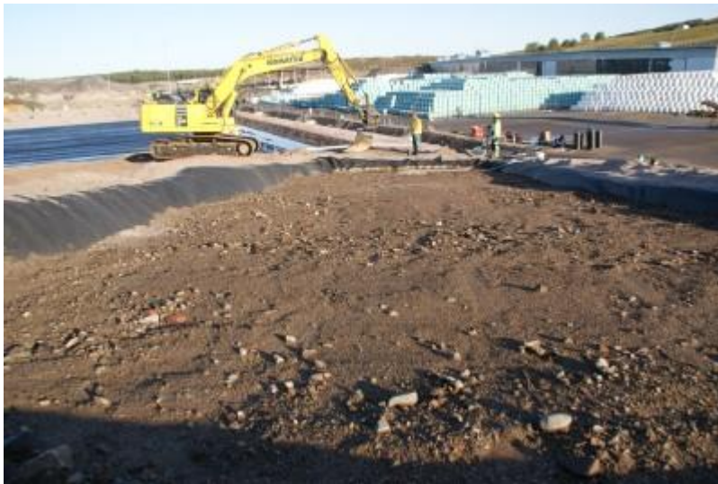
DSC04751 Valmiin pintakerroksen pinta sateen jälkeen
