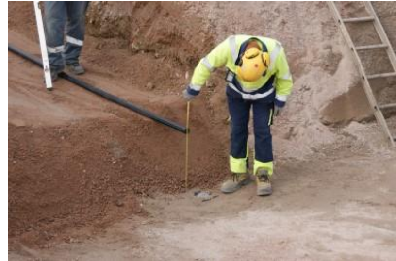
DSC04833 Putken tason tarkastus
