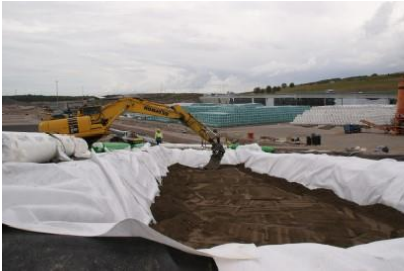
DSC05040 Kuonabentoniitin levittäminen
