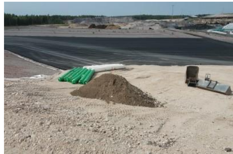
20180824_132445 Rullatuotteiden välivarastointi työmaalla
