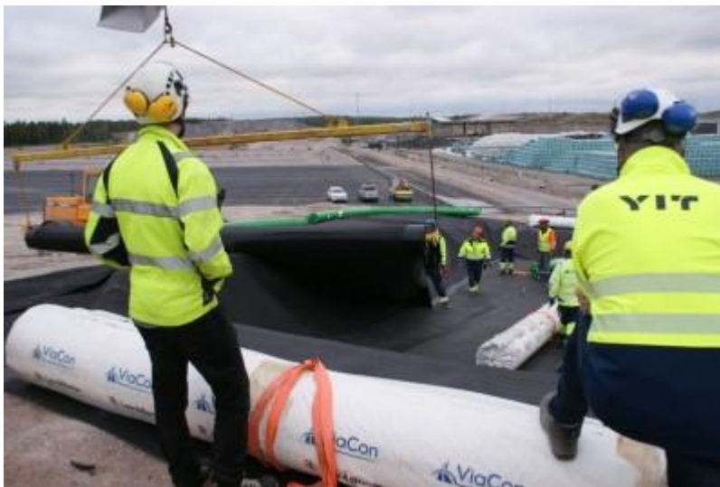
DSC04543 Tiivistyskalvon levitys ja limitys
