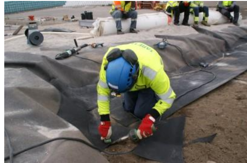
DSC04688 Pintakerroksen päälle asennetun kalvokaistaleen kiinnitys
