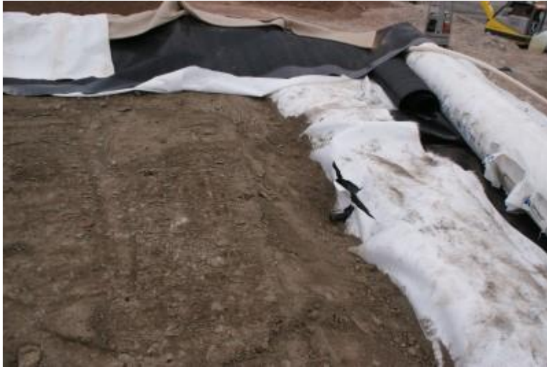
DSC05117 Kasvukerroskseen läpivienti, ei vielä kasvukerrosta
