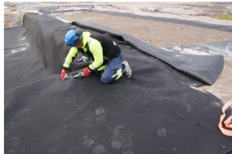
DSC04858 Suojageotekstiilien kiinnittäminen toisiinsa
