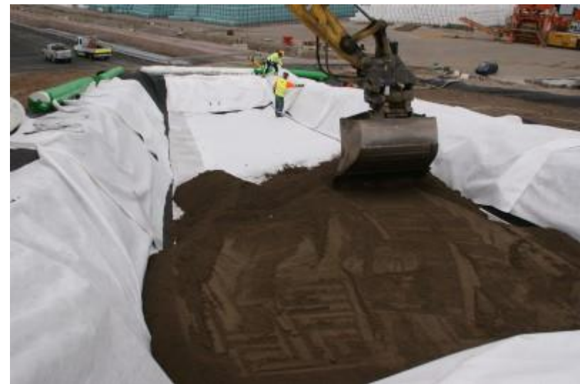
DSC05035 Kuonabentoniitin levittäminen. Luiskissa suodatinkangas
