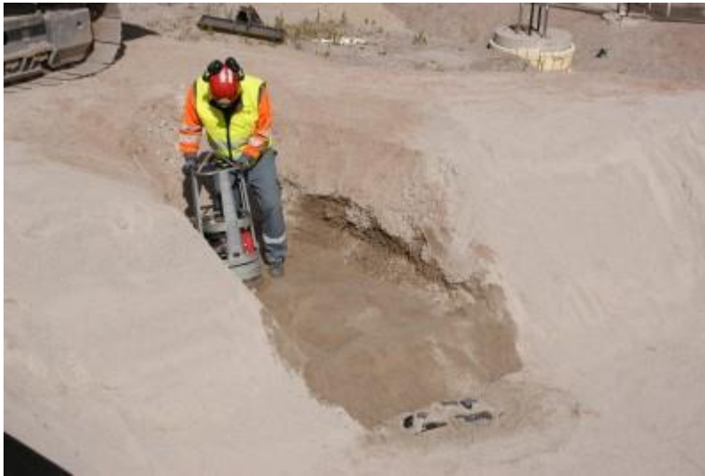
DSC04376 Putkien asennus
