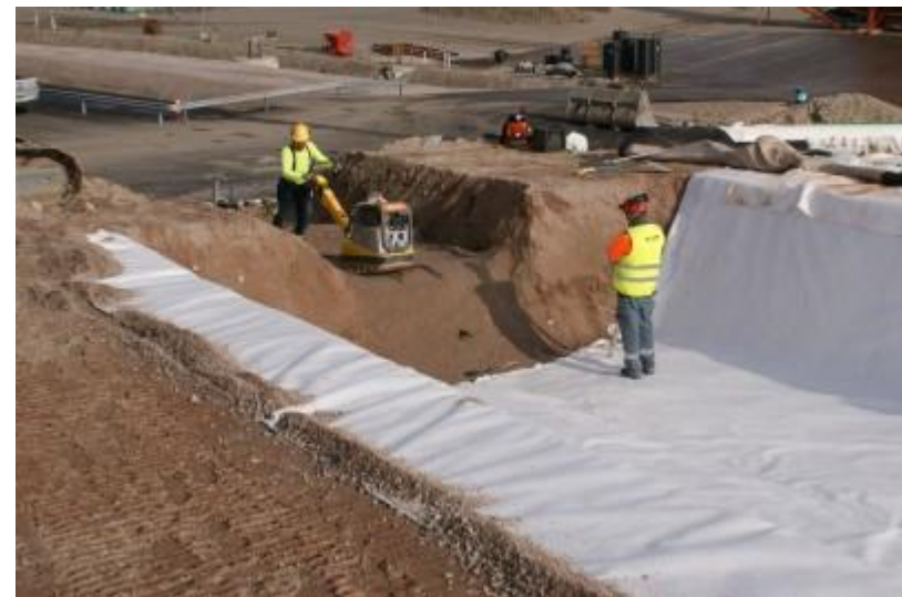
DSC05150 Putkikaivannon tiivistäminen
