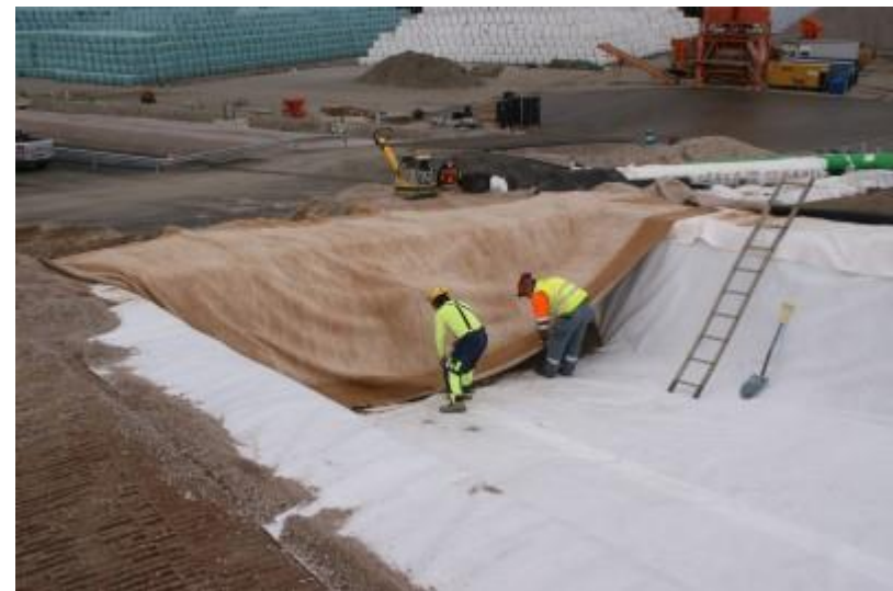
DSC05161 Päädyn bentoniittimaton asentaminen
