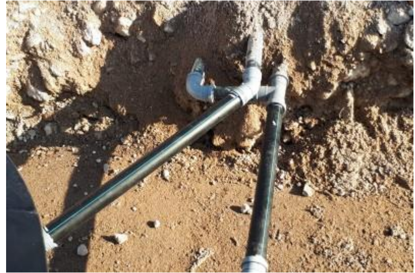
162013 Putkien liitos 19.9.2018 (Leppänen 2018)
