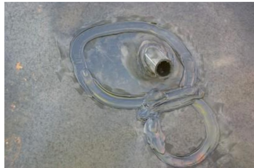
DSC04526 Päädyn läpivienti ja sen alla oleva paikka
