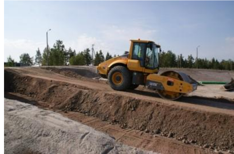
DSC04713 A.2 ja B.2 välisen välipenkereen tiivistäminen
