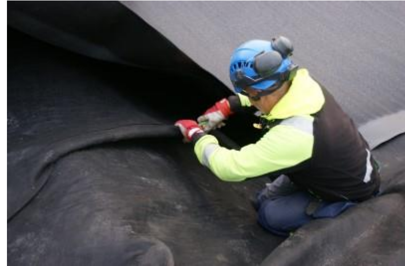
DSC04922 Suojageotekstiilin muotoilu pohjakalvon alla
