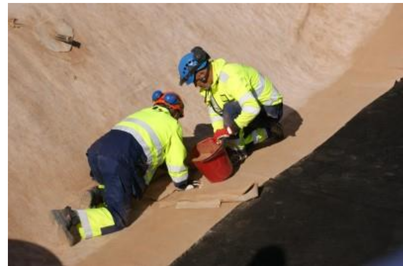
DSC04403 Läpivientien tiivistäminen bentoniittijauheella ja -matolla
