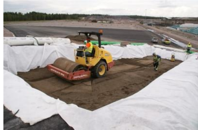
DSC05045 Kuonabentoniitin koetiivistys, 1. jyräys
