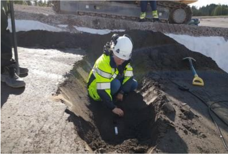
153203 Anturin asennus, mittamies valmiina kuopan vieressä (Vahanen 2018)
