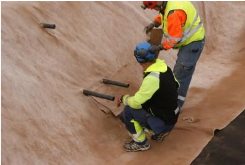
DSC04895 Läpivientien paikkaaminen
