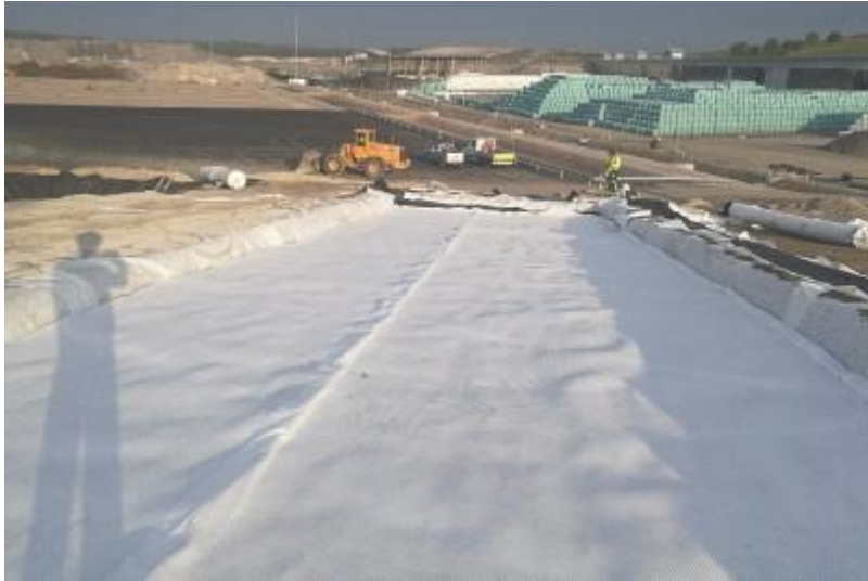
083431 Kuivatuskerroksen päällä salaojamatto, vaihdettu suodatinkankaaseen myöhemmin (Vahnen 2018)
