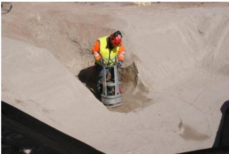
DSC04364 Putkikaivannon lätkäys
