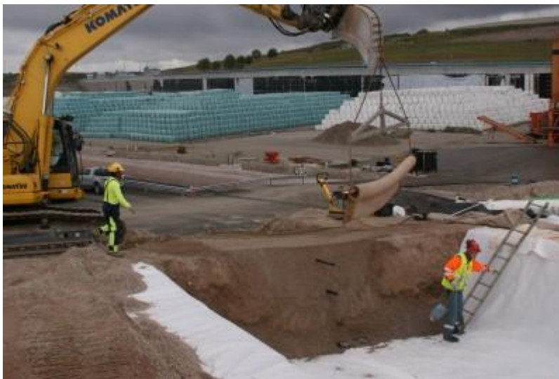
DSC05160 Penkan läpiviennit
