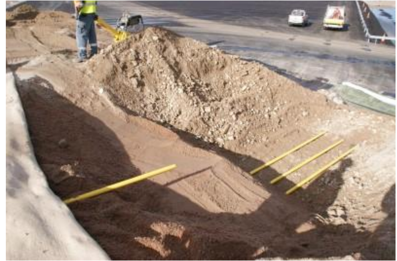
DSC04778 Putkien jatkaminen
