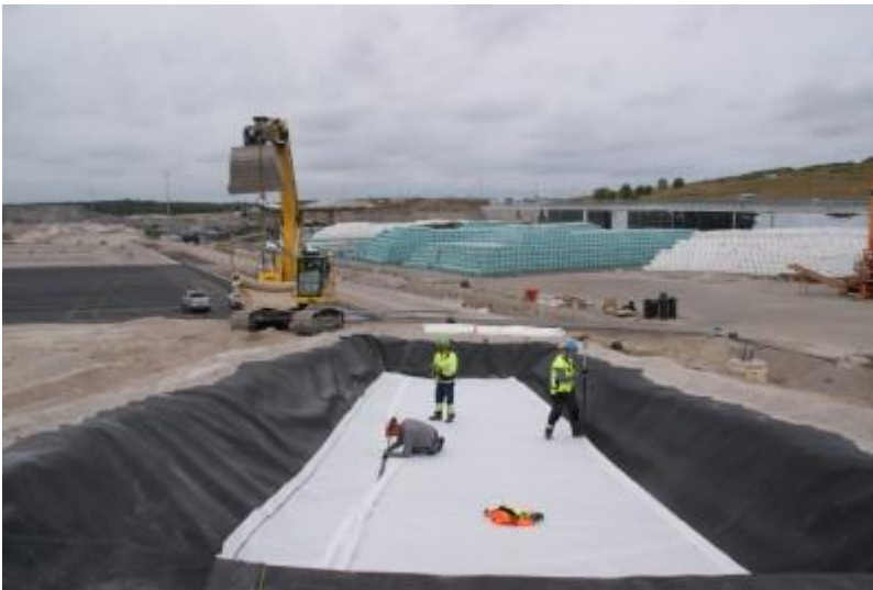
DSC04622 Salaojamatton tarkemittaus
