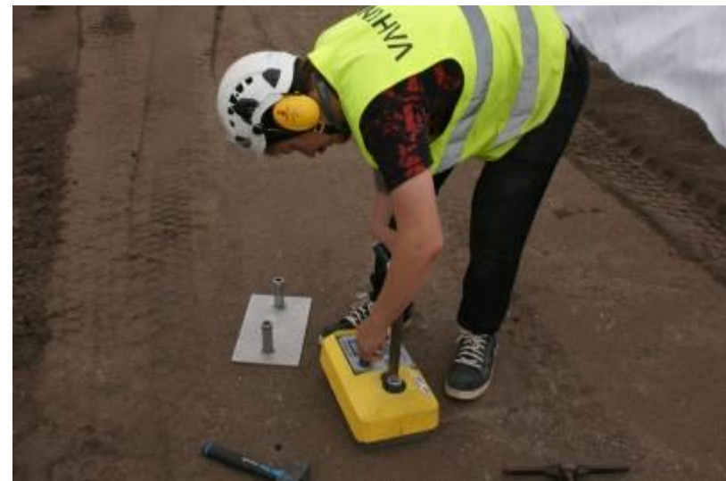
DSC05047 Riippumattoman laadunvalvojan 1. jyräyksen troxler
