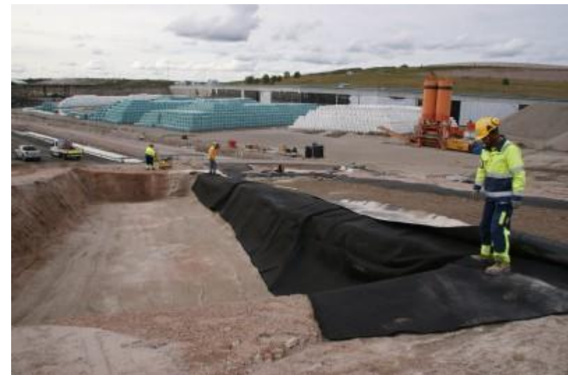
DSC04841 Suojageotekstiilin levittäminen luiskaan
