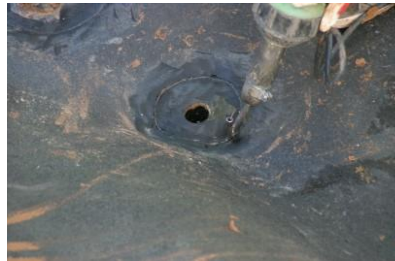
DSC04492 Kuparilangan kiinnittäminen läpivientiin
