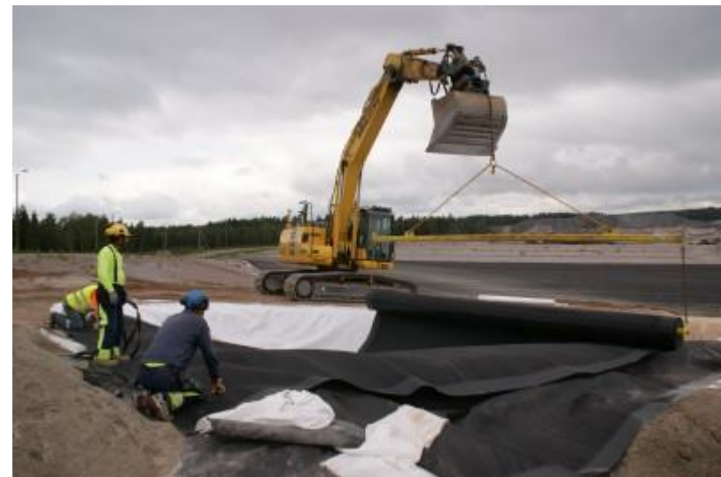
DSC05175 Pohjakalvon levittäminen
