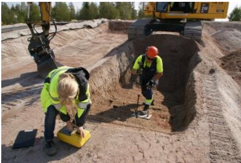
DSC04726 A.2 ja B.2 välisen välipenkereen Troxler-mittaus (rakennustavan tarkastus)
