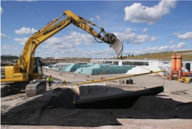
DSC04408 Pohjakalvon levittäminen
