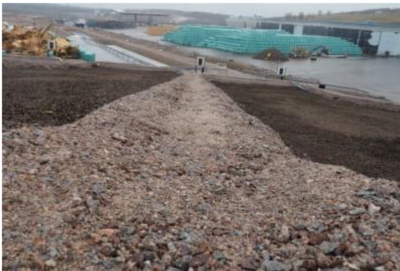
P4091341 Koepintarakenteiden A.2 ja A.1 välinen reunavalli
