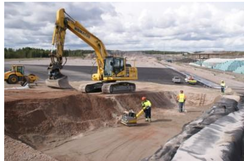
DSC04790 Koekentän pohjan tiivistys (27.8.2018)
