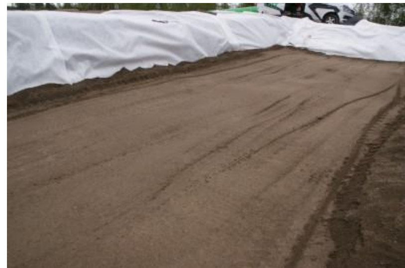
DSC05058 Kuonabentoniitin koetiivistys, pinta 3. jyräyksen jälkeen
