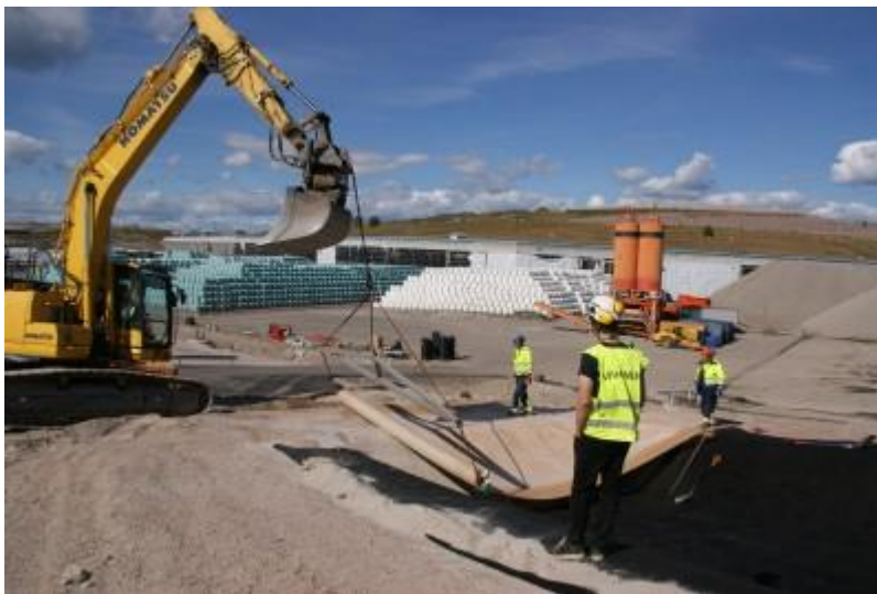
DSC04391 Bentoniittimatton asentaminen luiskan pätyyn
