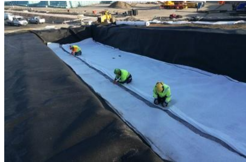
081634 Salaojamattojen yhdistäminen 3.9.2018 (Vahanen 2018)
