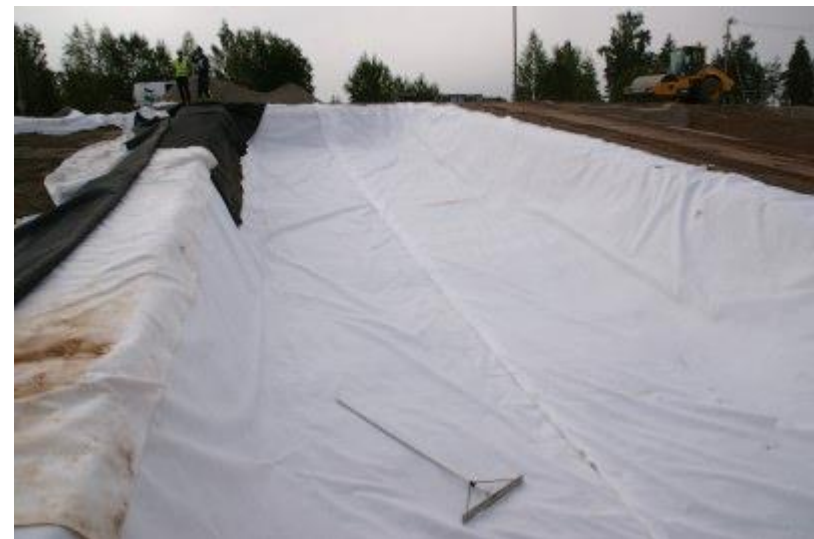
DSC05147 Valmis suodatinkangas
