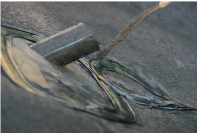
DSC04518 Kipinäkoe päädyn läpiviennissä
