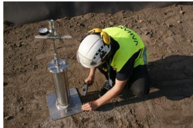
DSC04708 Vesivolymetrin kiinnittäminen alustaan
