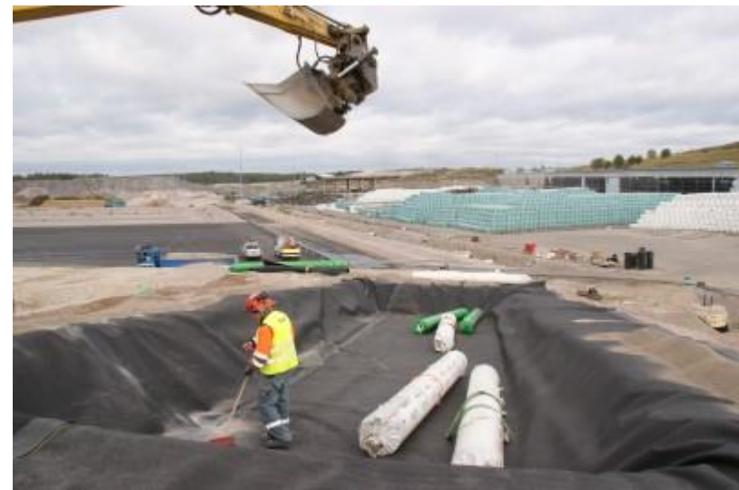
DSC04594 Väliaikainen tuenta ja pohjakalvon lakaiseminen
