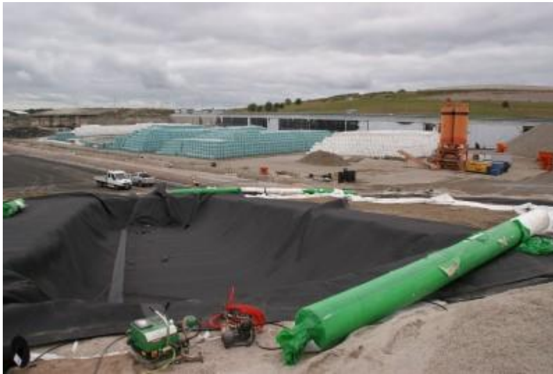
DSC05209 Pohjakalvon väliaikainen tuenta
