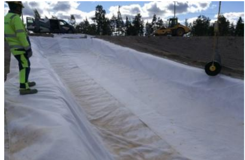
123244 Suodatinkangas ennen pohjakalvon levittämistä (Vahanen 2018)
