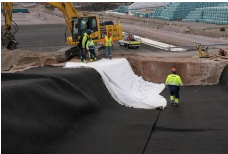
DSC04868 Suojageotekstiilin levittäminen
