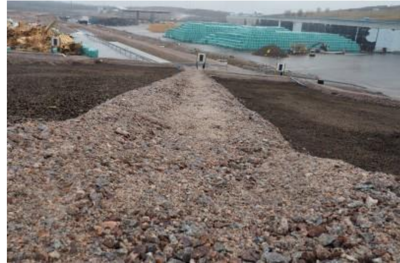
P4091341 Koepintarakenteiden A.2 ja A.1 välinen reunavalli
