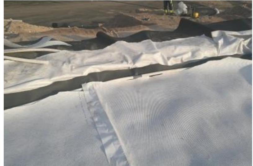
083456 Pintakerroksen vedet keräävä salaojaputki (Vahnen 2018)
