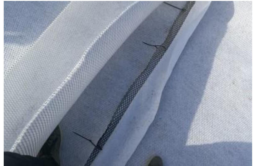
140505 Yhdistämiseen käytetty nippusiteitä (Vahnen 2018)
