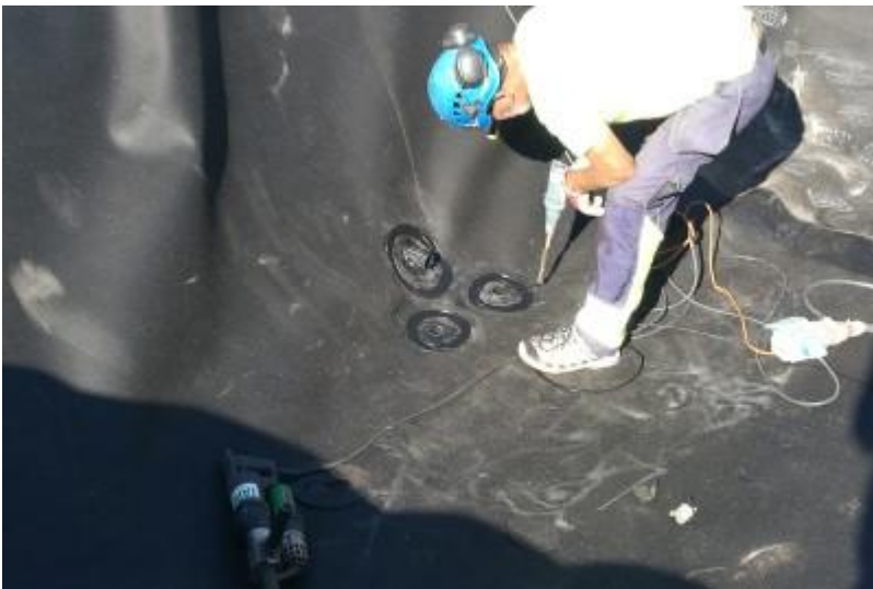
150846 Lävivientien ekstruusiosaumojen kipinätestaus (Vahnen 2018)
