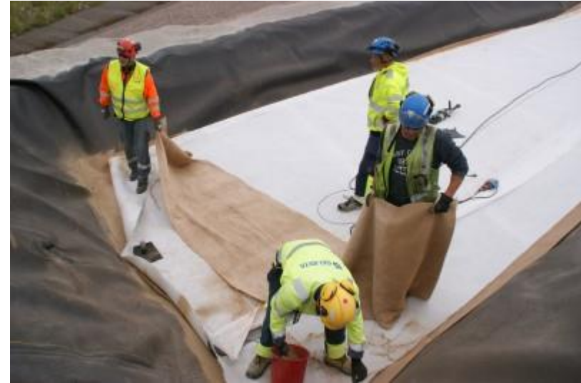
DSC04556 Bentoniittimattokaistaleen asentaminen päättyyn
