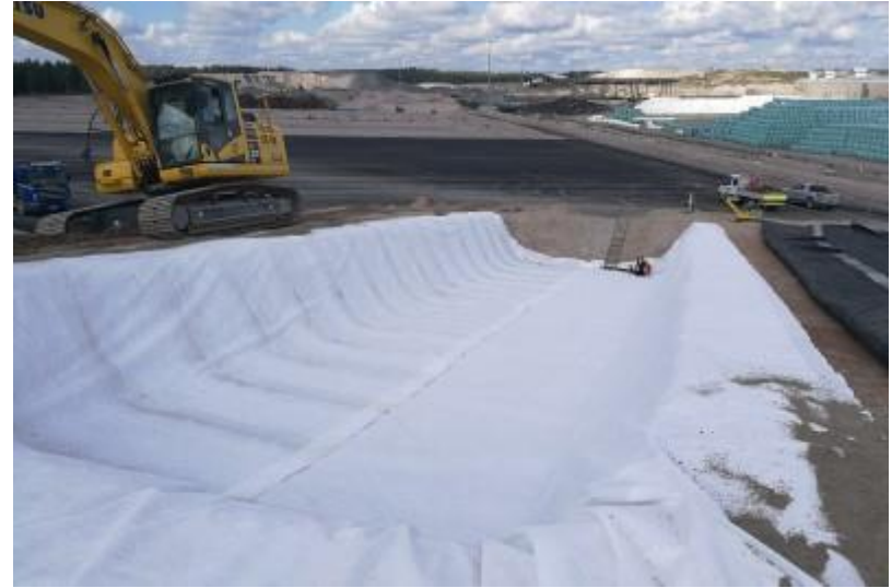
113715 Kaksi päällekkäistä suodatinkangasta suojageotekstiilin tilalla 3.9.2018 (Vahanen 2018)
