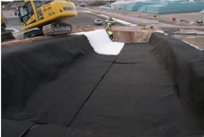
DSC04874 Valmiit suojageotekstiilit
