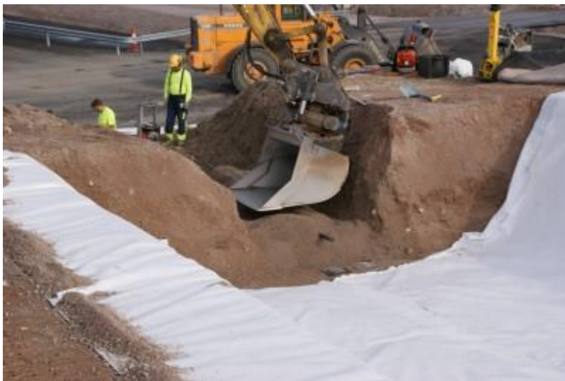
DSC05149 Putkien asentaminen
