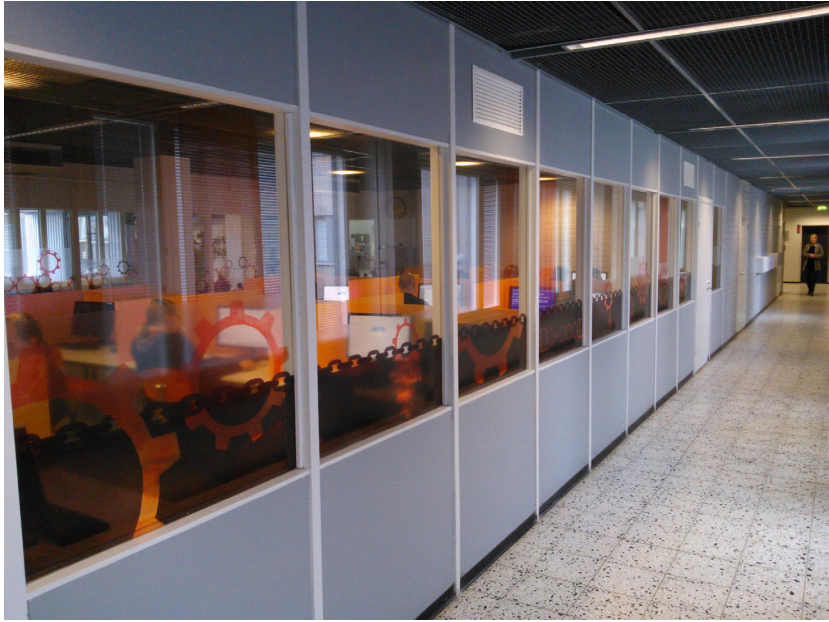
Kuva 6.7 ATK-luokan K1103 WC-käytävän puoleinen sivu, jonne siirtoilmapuhaltimet puhaltavat ilmaa ATK-luokasta käytävään. Puhaltimet sekä niiden säleiköt ovat siistit ja ovat nähtävissä kuvan yläreunassa ikkunoiden yläpuolella.
