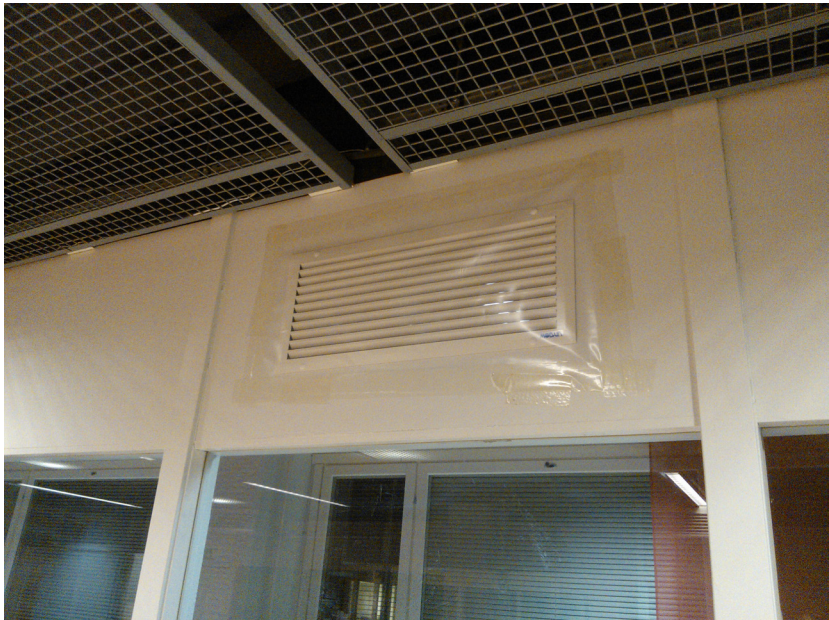
Kuva 6.8 Muovitettu siirtoilmasäleikkö luokan K1103 seinässä. Kun haluttiin tutkia luokan sisäilman laatua vailla aulan ja ATK-luokan välistä ilmanlaadun tasaamista aukkojen asennuksen jälkeen, muovitettiin aukot mittausten ajaksi.
