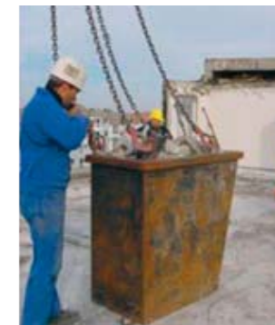
KUVAT 1: Elementtikerrostalon purkutyötä Saksassa
