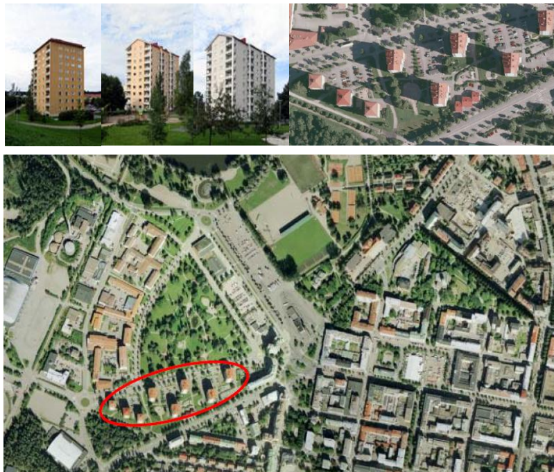
Kuva 5.1. Ilmakuva Lahden keskustasta ja Paasikivenkadun Hakatorneista, jotka on kuvassa ympyröity.
