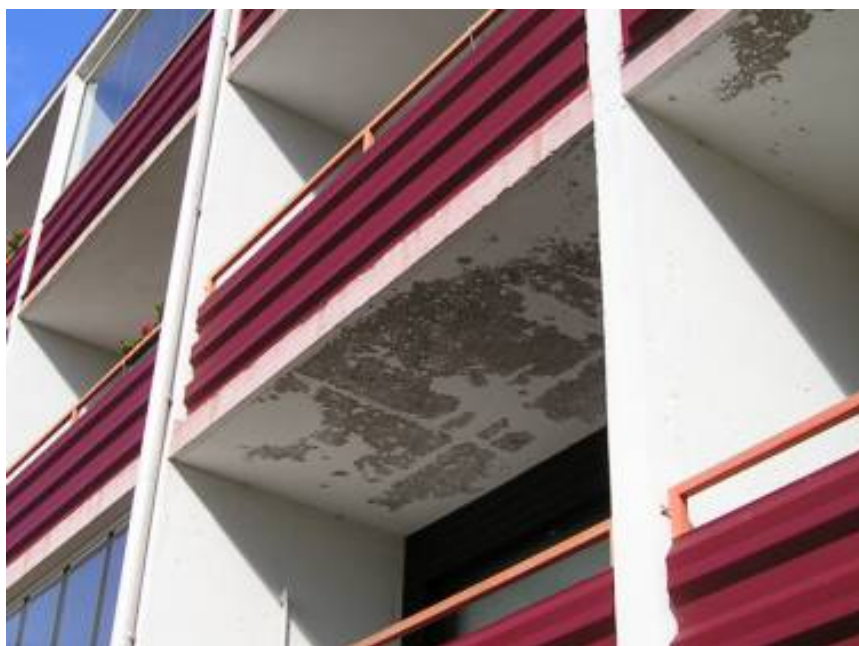
Kuva 3.24 Parvekelaattojen alapinnan maalin hilseily on yleensä merkki kosteuden kulkeutumisesta rakenteen läpi tai rakenteessa. Vauriomekanismien esiintyminen on näillä kohdin todennäköisempää ja vaurionopeus suurempaa kuin muissa rakenteissa.
