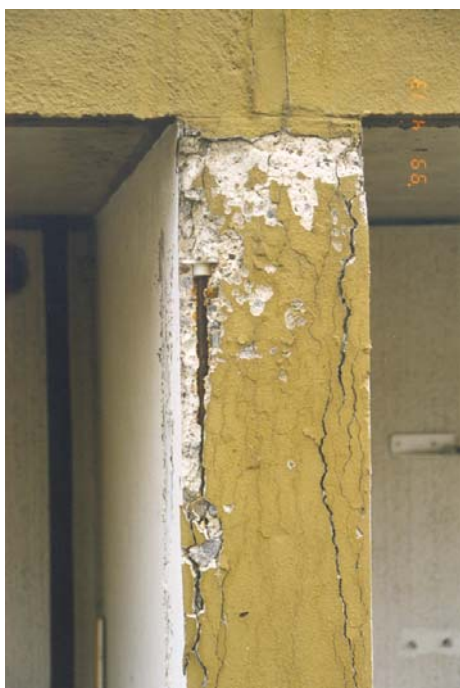
Kuva 3.6 Tyypillistä parvekkeen piellelementin etureunan pakkasrapautumaa.
