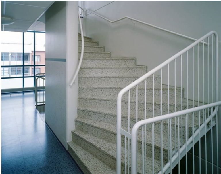
Kuva 30. Mosaiikkibetoniset portaat [106]
