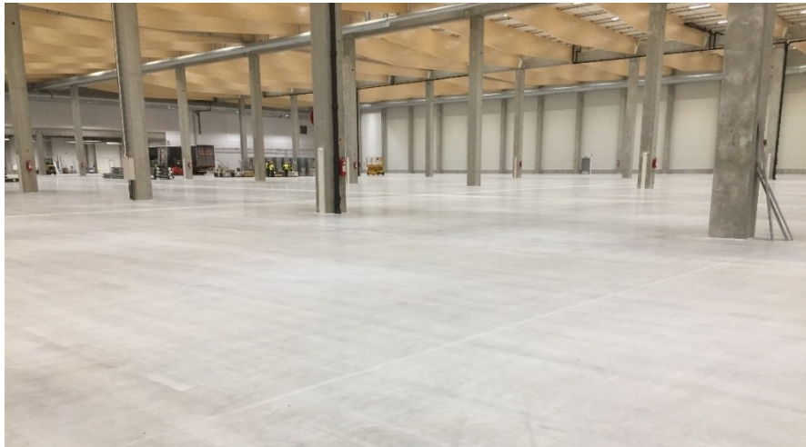
Kuva 31. Logistiikkahallin kiiltohiottu ja silikaattikäsitelty lattia [109]
