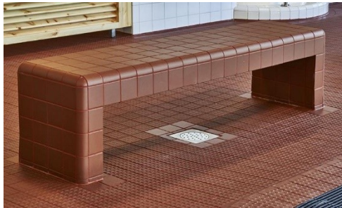
Kuva 29. Kohokuvioituja laattoja Tampereen uintikeskuksessa [104]
