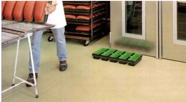
Kuva 34. Polyuretaanimassalattia [112]
