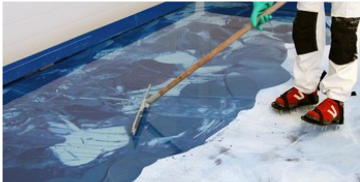
Kuva 33. Epoksinpinnoitteen levitys [111]
