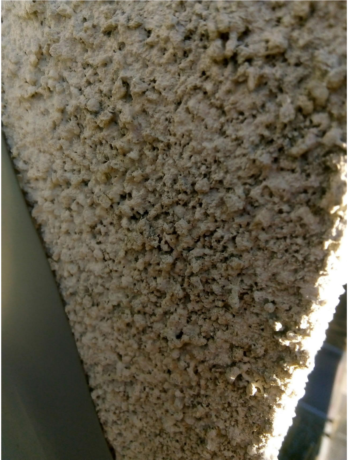
Kuva 7: Pinnoitteen harvarakeisuutta.
