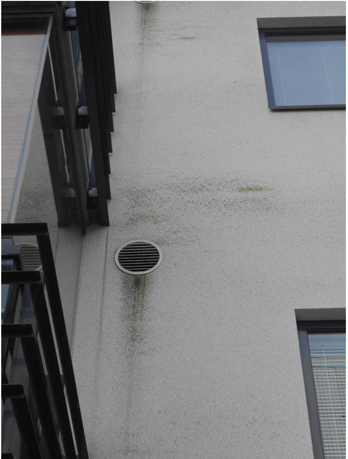
Kuva 39: Julkisivun leväkasvustoa.
