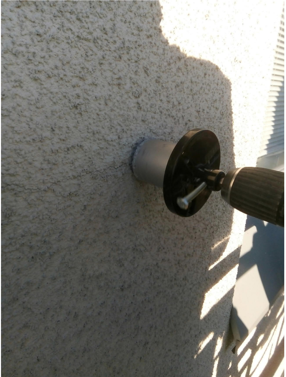
Kuva 55: Näytteenotto ohutrappaus-eristejärjestelmästä porakoneeseen asennetulla ti-manttiporalla.
