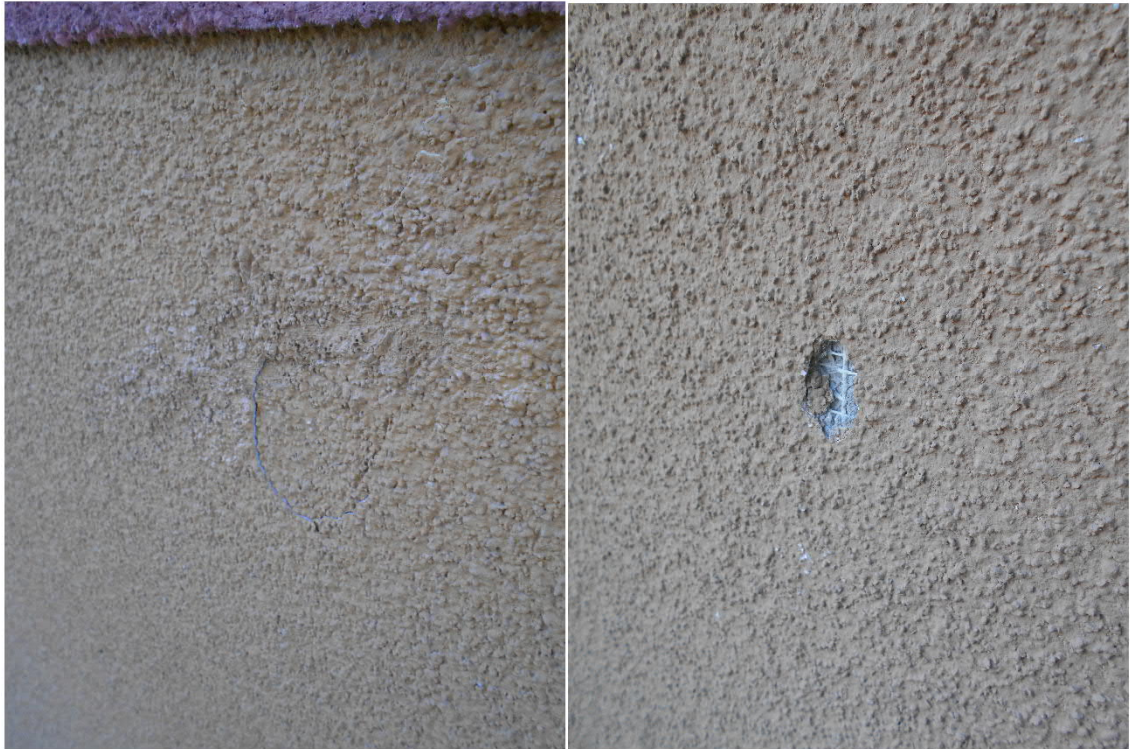
Kuva 33: Mekaanisten iskujen aiheuttamia vaurioita. Vasemman puoleisessa tapauksessa isku on aiheuttanut rappauksen läpileikkautumisen. Oikeanpuoleisessa tapauksessa isku on aiheuttanut rappauksen lohkeamisen.
