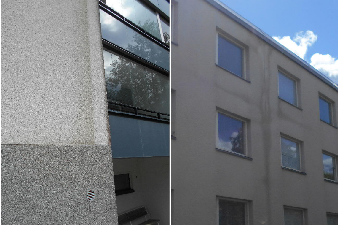
Kuva 46: Julkisivujen leväkasvustoja.
