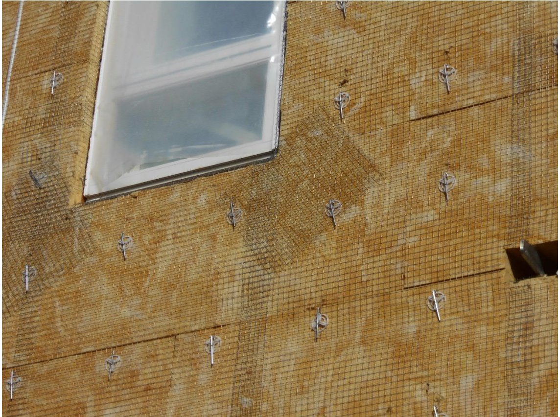
Kuva 13: Lämmöneristeen ulkopinta rappausverkon asennuksen jälkeen. Kuvassa näkyy kiinnikkeiden pyöreä ja muovinen rengasvälike, jonka päällä on pystysuunnassa lukitus-salpa. Rappausverkko asennetaan rengasvälikkeen avulla oikeaan asemaan ja lukitaan paikoilleen lukitussalvalla. Ikkuna-aukon nurkissa näkyy vinoon asennetut lisärappaus-verkot. Rappausverkko on taitettu ikkunapielen ympäri nurkkavahvikkeeksi.
