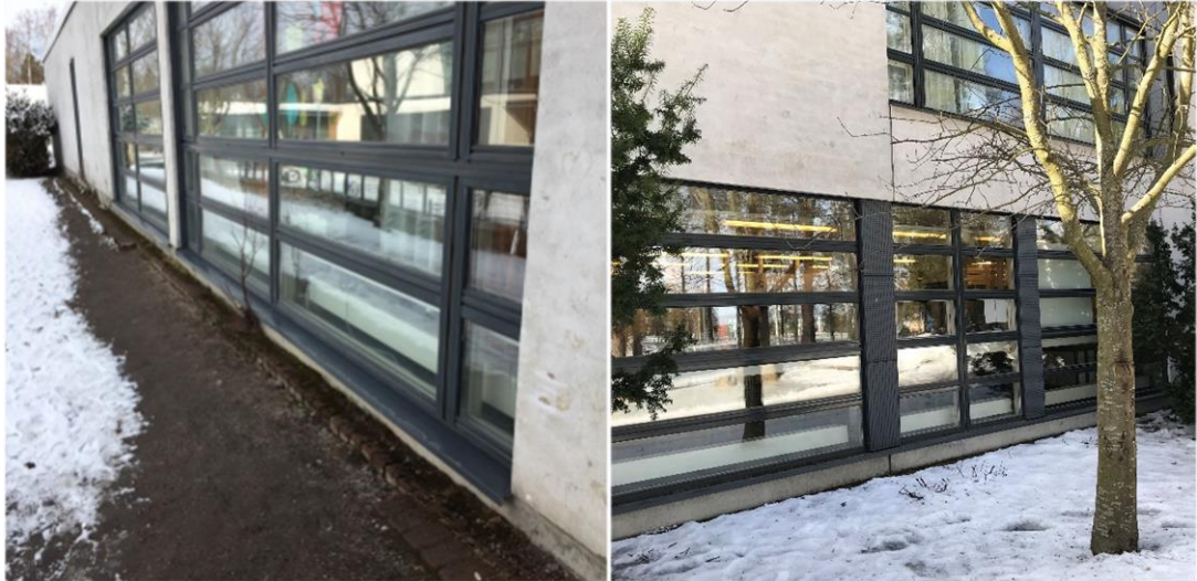
Kuva 23. Valkoisen talon lattia on monin paikoin samassa tasossa maanpinnan kanssa.
