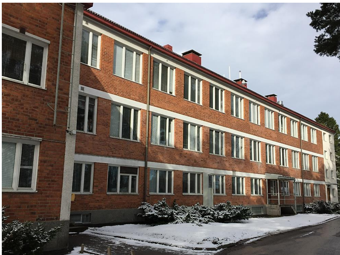
Kuva 27. Tiilitalo edustaa aikakautensa arkkitehtuuria.
