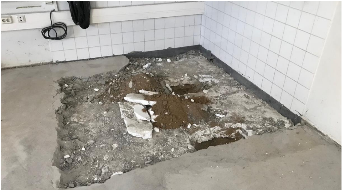
Kuva 24. Kuvaamataidon luokan alla olevaa maaperää tutkittiin rakenneavauksin.
