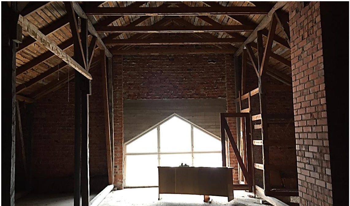
Kuva 39. Tiilitalon ullakkotila on avara ja hyväkuntoinen.
