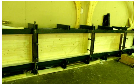
Kuva 3.3. Liimattuja sahatavarapalkkeja puristetaan. Palkkeja on kaksi päällekkäin ja kaksi rinnakkain.
