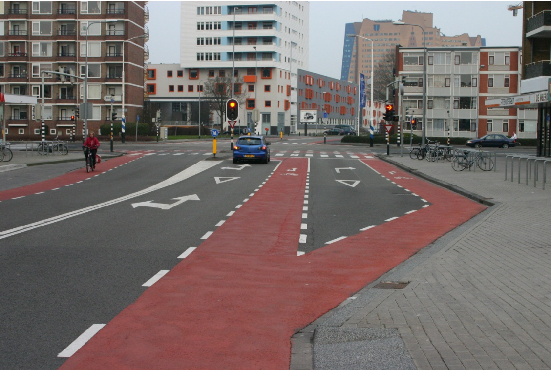
Kuva 23. Oikealle kääntyvät autot ylittävät pyöräkaistan ryhmittäessä Groningenissa Alankomaissa. Kuva: Kalle Vaismaa 2010
