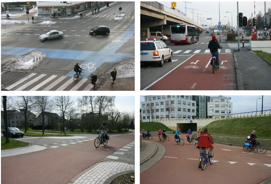
Kuva 41. Liittymäsuunnittelu on korkeatasoista mestarikaupungeissa. Houtenissa (alh.) autot väistävät pyöräilijöitä. Pyöräteiden liittymissä etuajo-oikeus on kerrottu liikennemerkkein ja katumerkinnöin. Kuvat: Kalle Vaismaa 2010.
