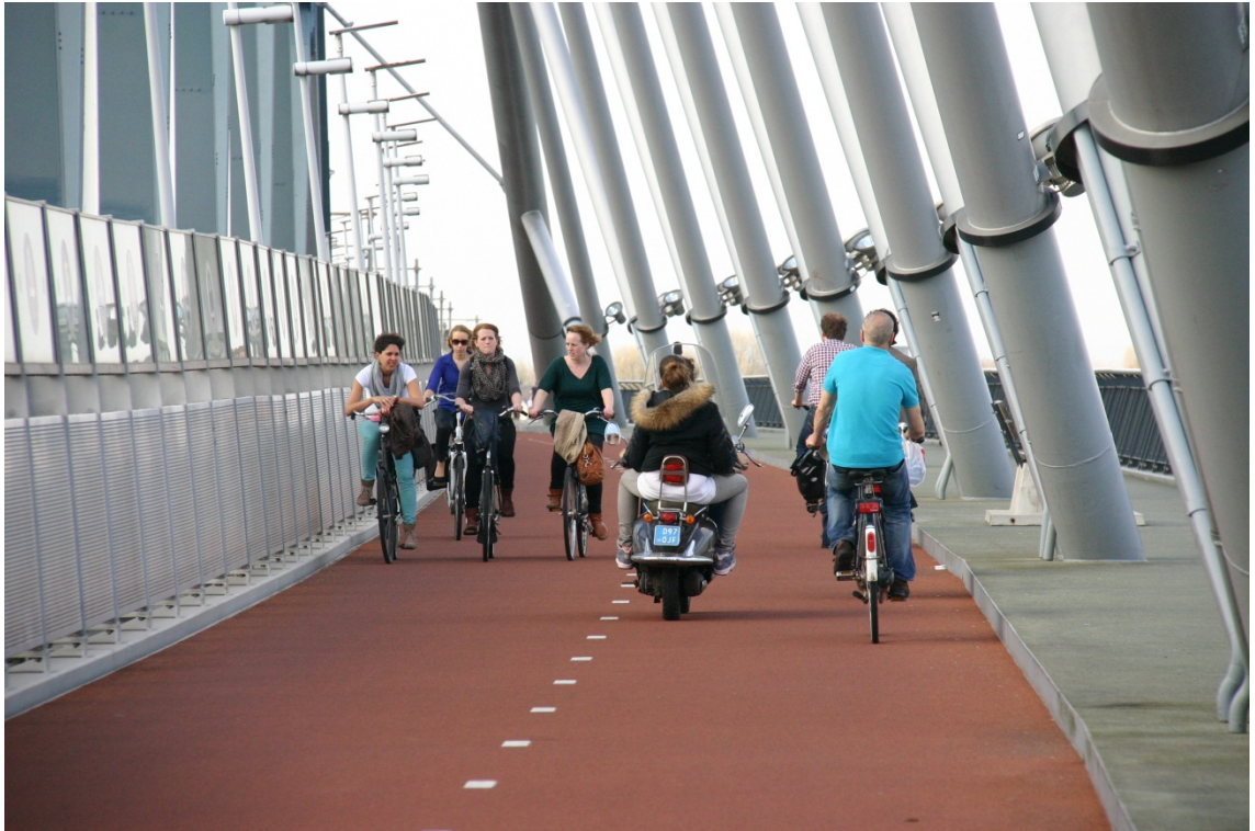
Kuva 21. Pikatietasoinen pyöräilyn pääväylä kulkee rautatien vieressä Nijmegenissa Alankomaissa. Uusi pyöräily silta on rakennettu rautatiesillan kylkeen. Kuva: Kalle Vaismaa 2013.
