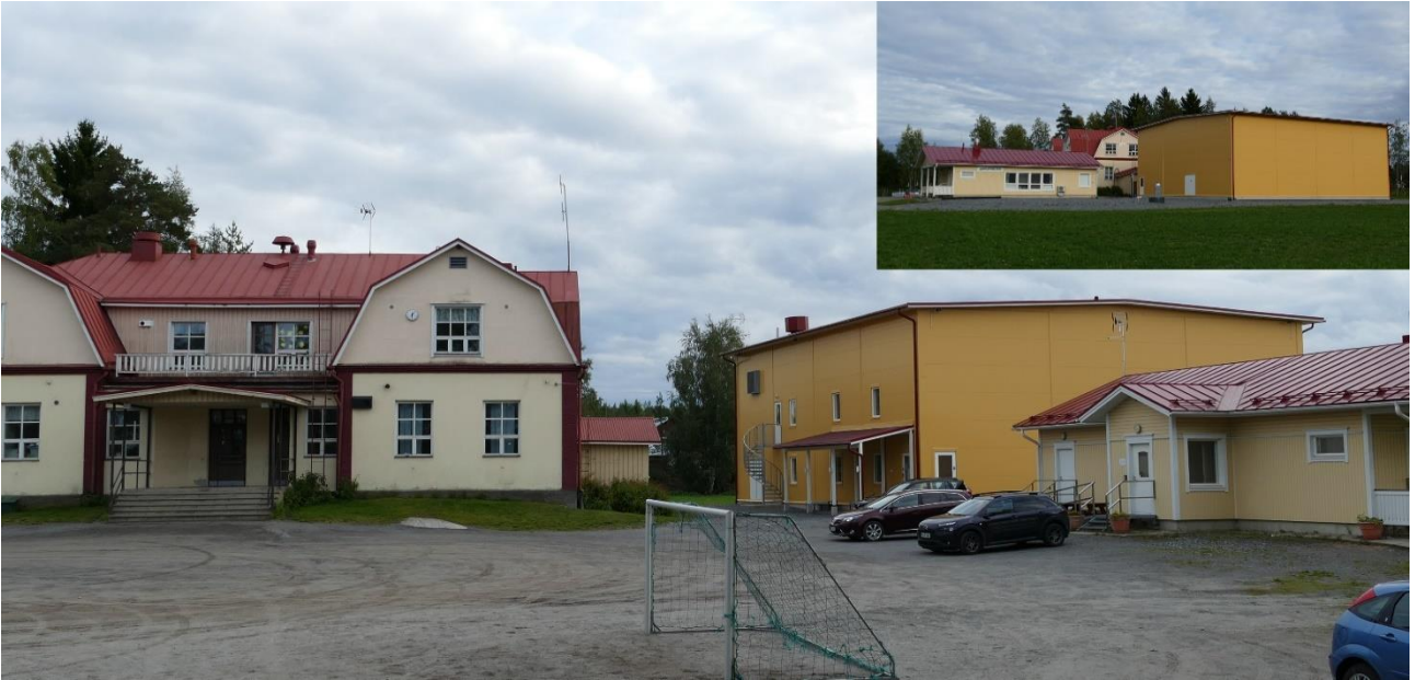
Kuvio 2 Keltainen monitoimihalli rakennettiin kyläkoulun ja kylätalon väliin. (Kuvat: Mikko Kangas)
